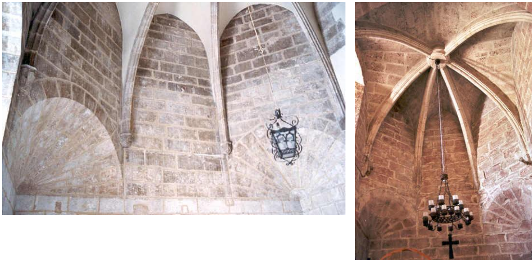
Ochavos sobre trompas cónicas. Sala capitular de la catedral de Segorbe. Capilla de la iglesia del monasterio de Santa María del Puig
