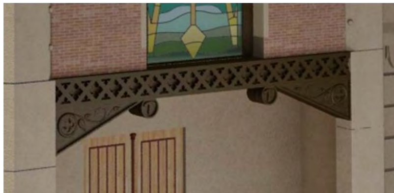
Il·lustració 117. Llinda de ferro com a biga de gelosia.
