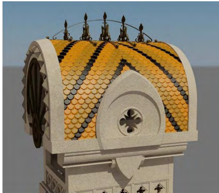
Il·lustració 112. Cobertes amb escata ceràmica.
