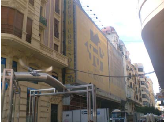
El Capitol- Levante en proceso de construcción
