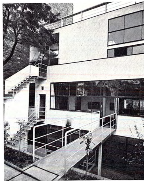
Blick vom Garten in den Living-room mit äußerer Treppe
