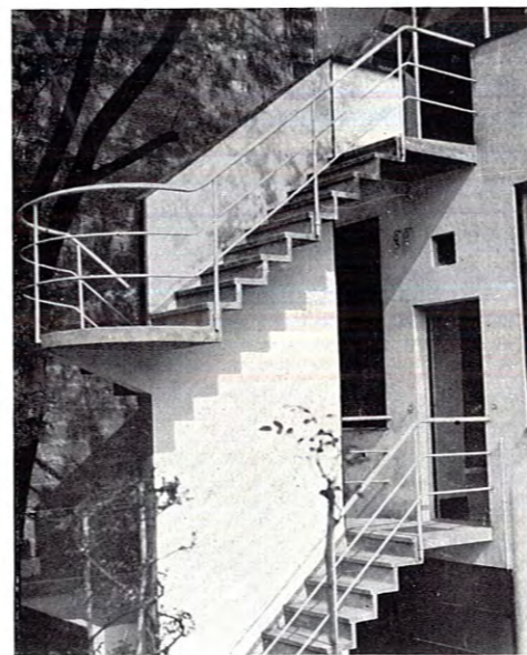
Die äußere unter einem Baum durchführende Treppe
