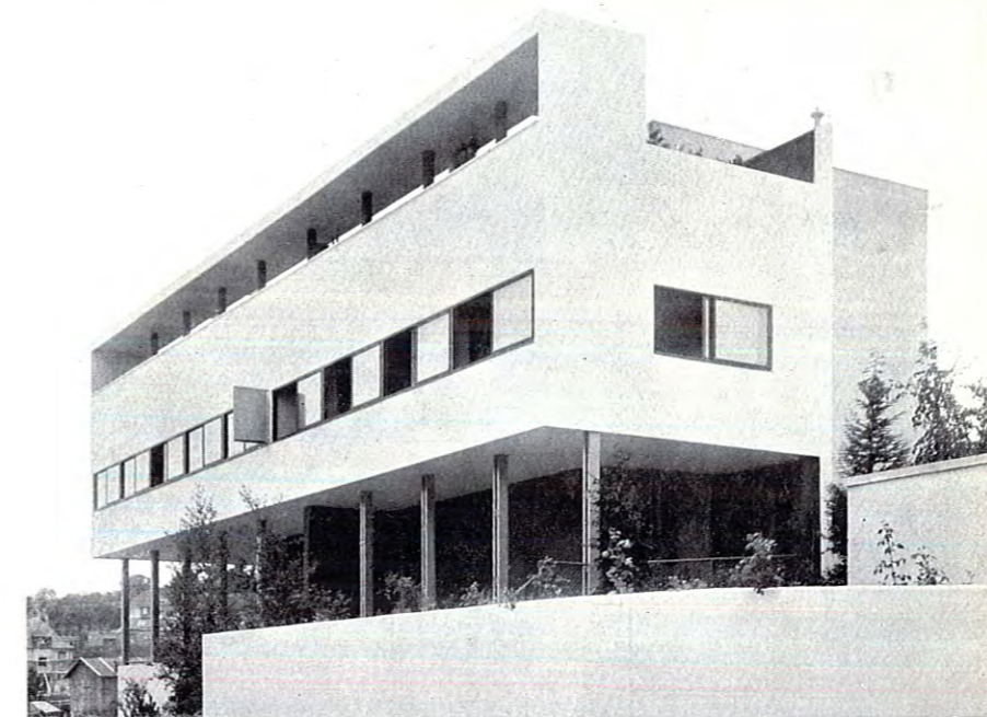
Ostfassade des Doppelwohnhauses
