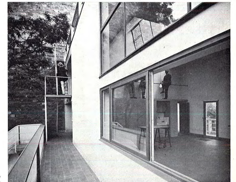
Balkongang vor dem Atelier (Gartenseite) — eine weitere äußere Treppe führt auf die Dachterrasse
