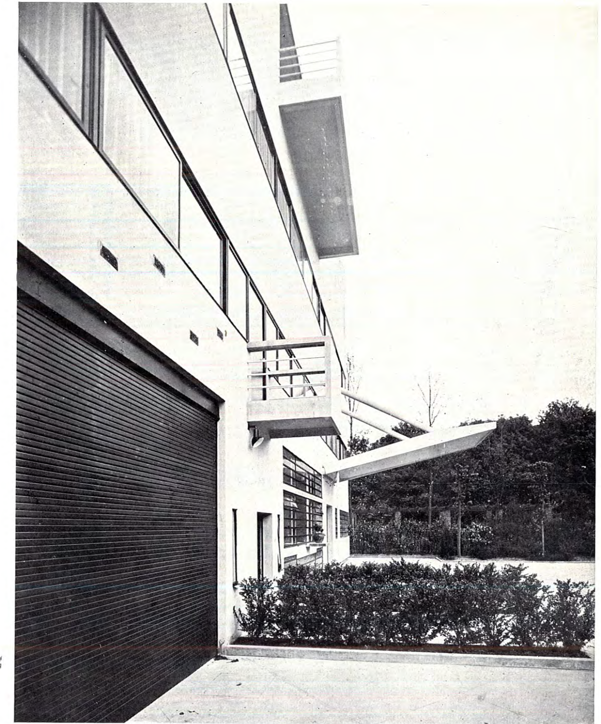
Straßenfassade — Das Schutzdach über dem Haupteingang
