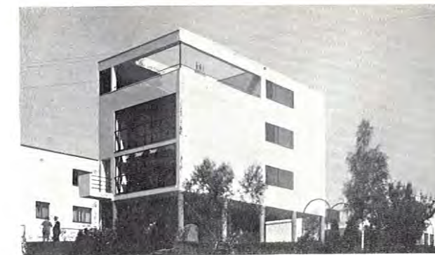
Einfamilienhaus in Stuttgart 1927
