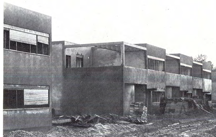
Das Einfamilien-Reihenhaus (im Bau)
