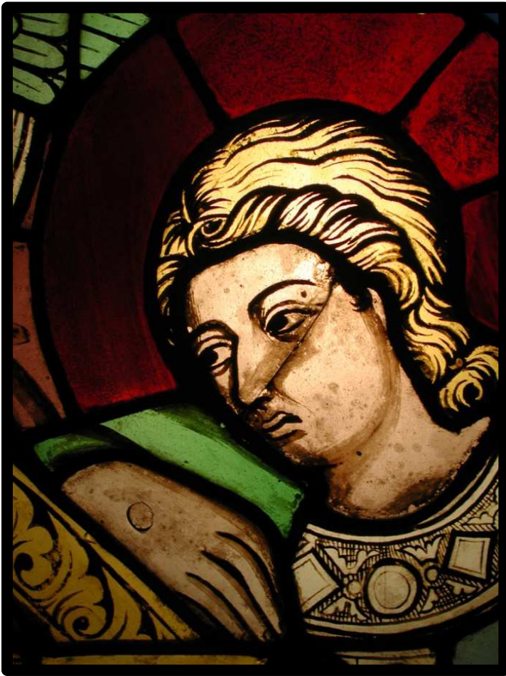
Fig. 156 (a, b) Duomo di Siena, rosetón absidal, ejemplo de dos fracturas vítreas previas a la restauración.
