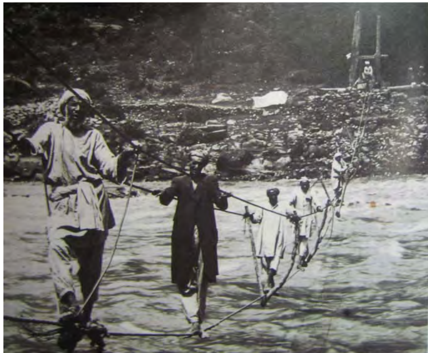
Figura 1. Puente vernáculo (barras y cables).
