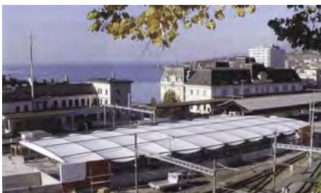
Figura 27. Cubierta con Tensairity Garage Parc Montreaux
