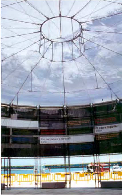
Figura 46. Bifid Tension Dome I. Llorens y H. Pöppinghaus
