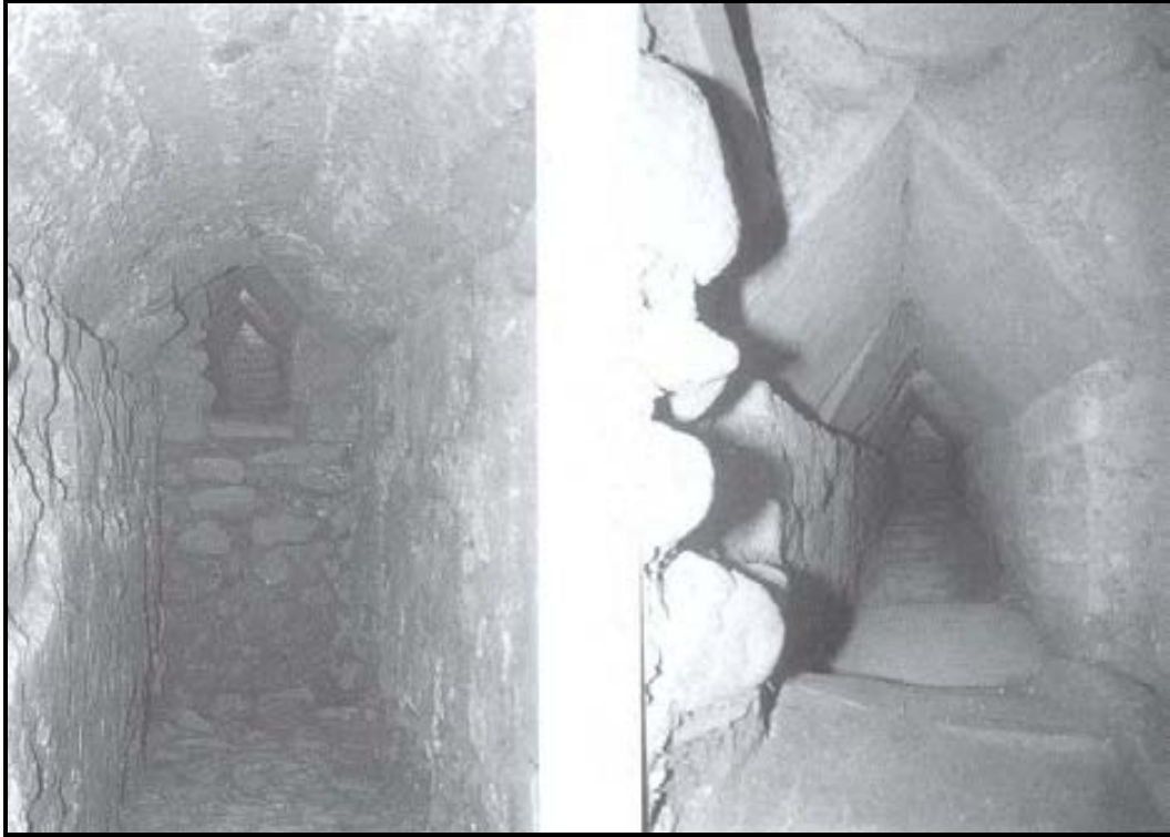
Fig. 110: Vista de detall de les canalitzacions romanes documentades al Pati de la Rectoria (Martín 2004).
