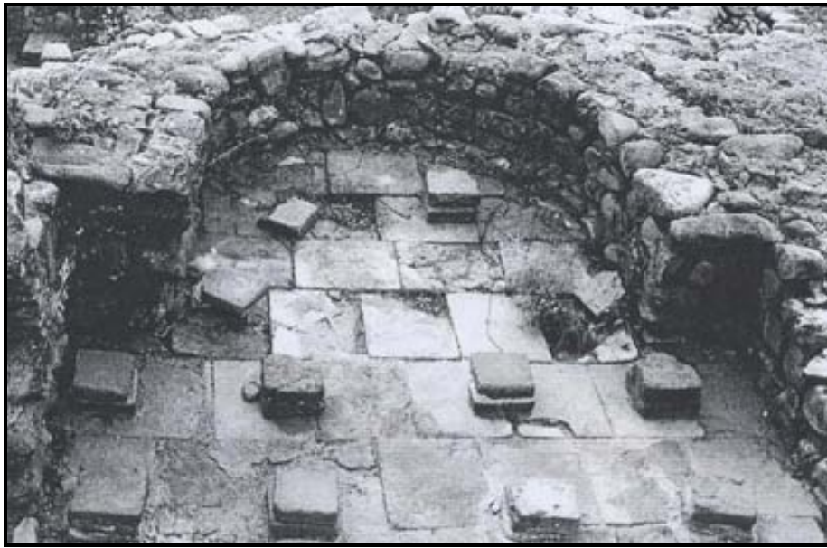
Fig. 97: Detall del sistema d'hipocaust del caldarium de Can Terrés (Tenas et al. 1996).
