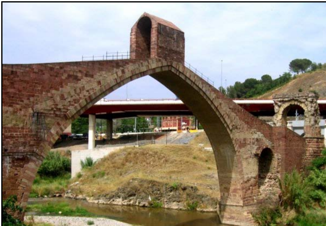
Fig. 81: Vista del Pont del Diable (www.poblesdecatalunya.cat).
