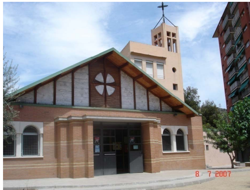
Vista exterior del templo y el campanario
