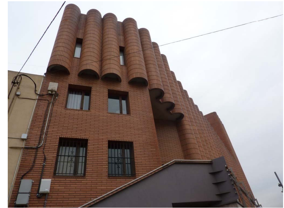
Fachada lateral del edificio
