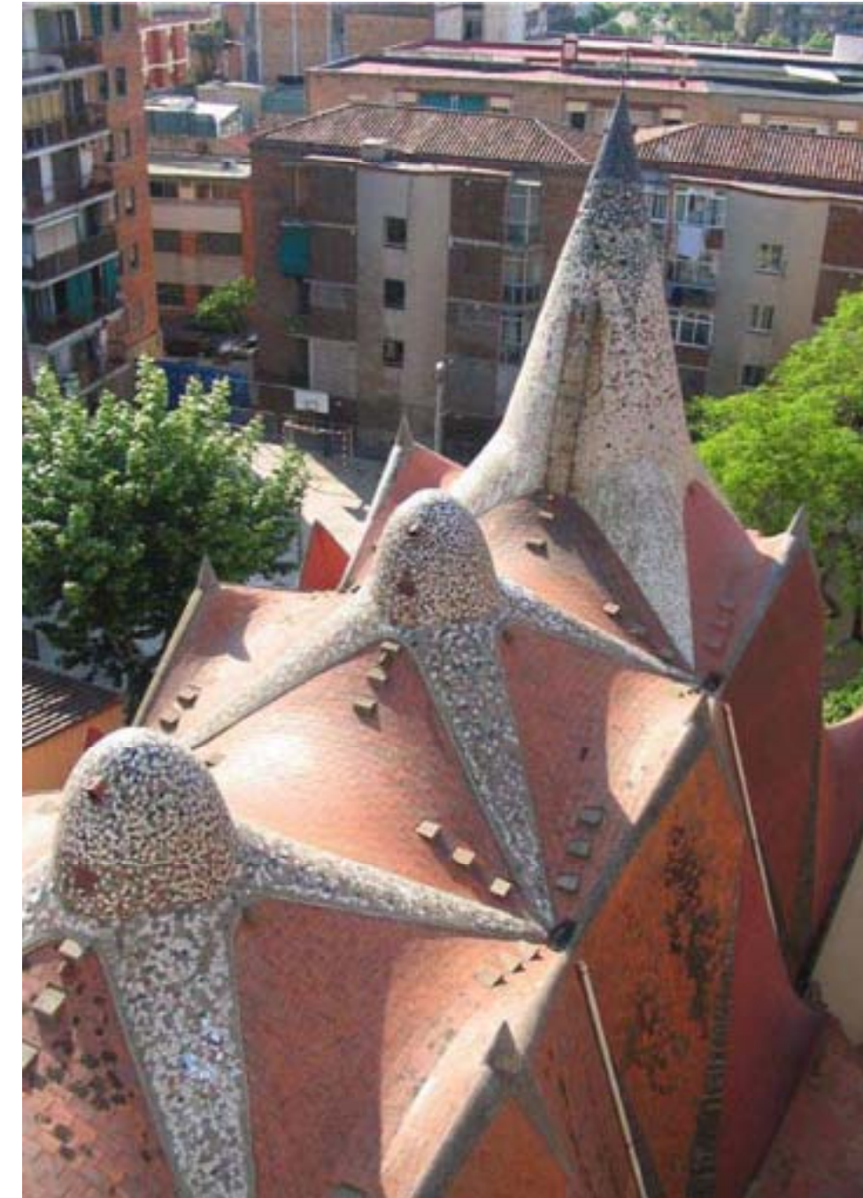
Vista de la cubierta n
