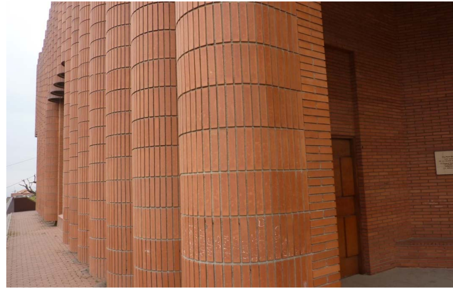
Detalle de la fachada cerámica
