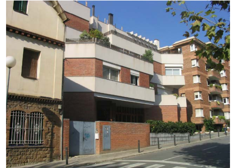
Vista general del edificio
