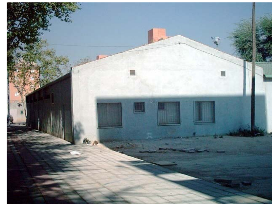
Vista fachada posterior
