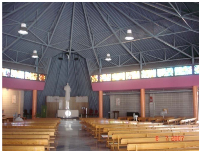
Vista interior de la nave del templo
