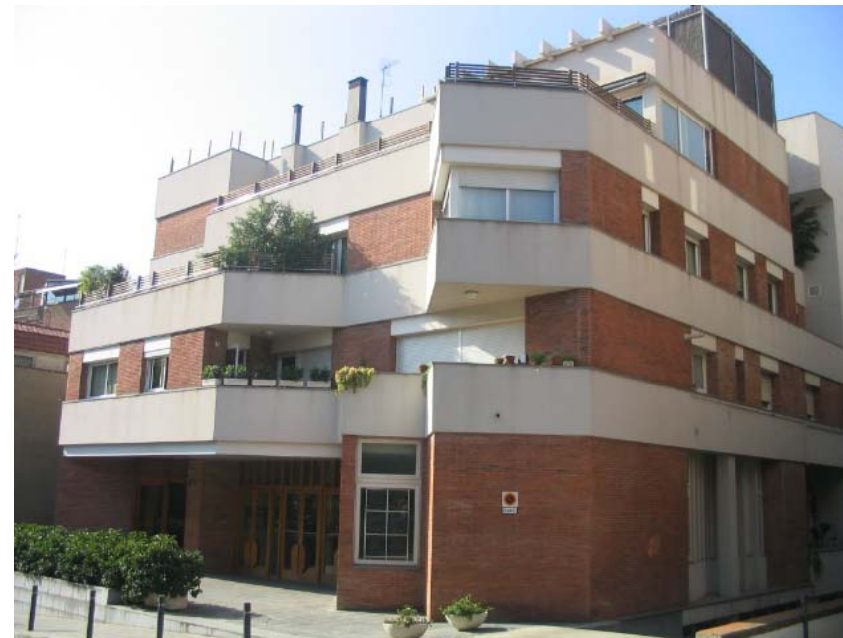
Vista general del edificio
