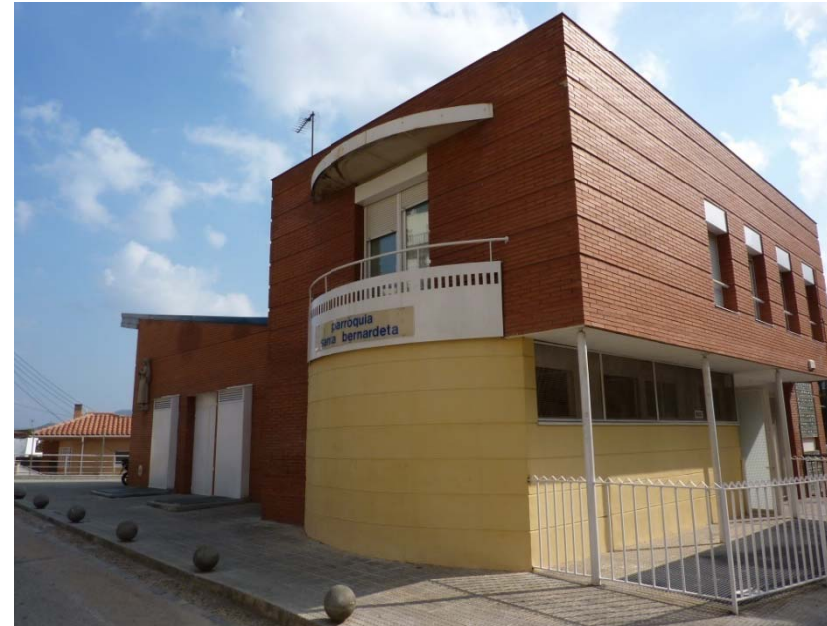
Vista de la fachada lateral
