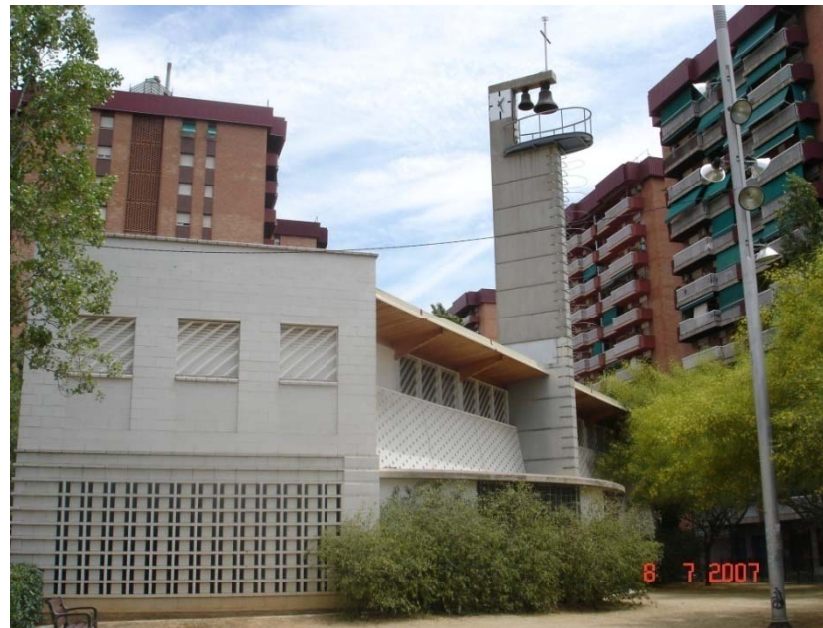
Vista exterior del templo y el campanario
