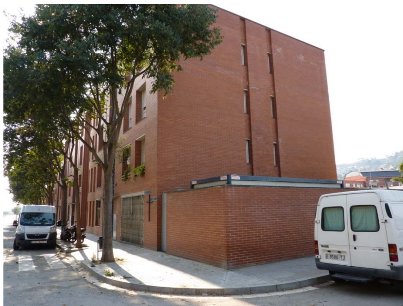
Vista de la fachada lateral
