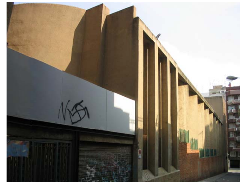
Fachada lateral del edificio
