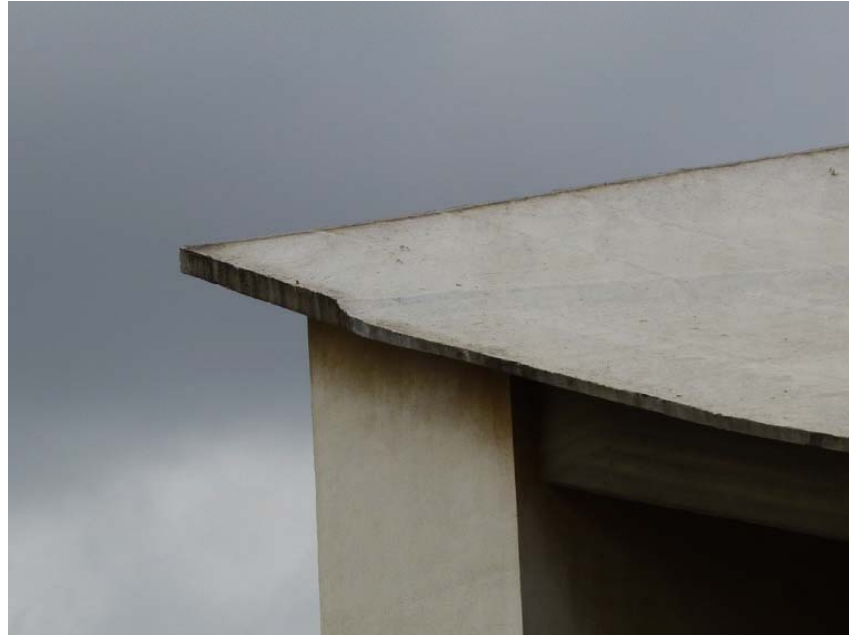
Detalle de la cubierta
