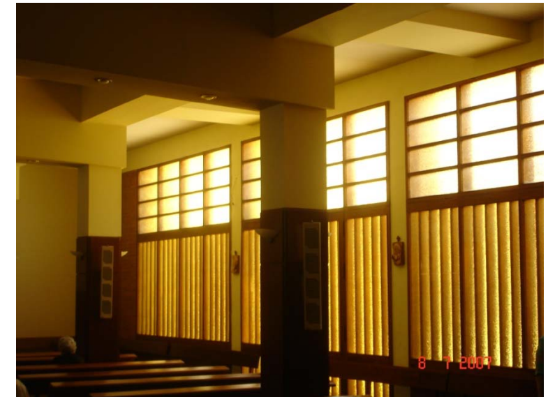
Detalle de la estructura
