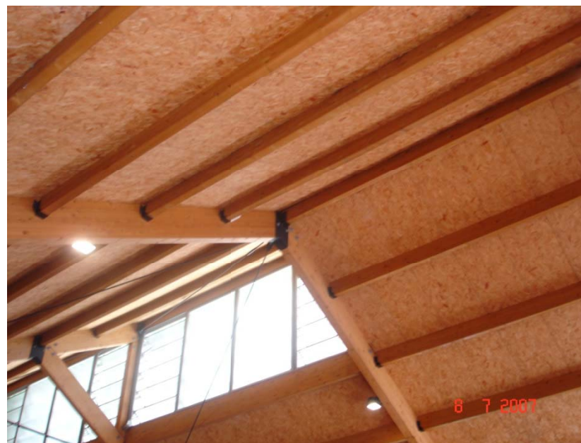
Detalle de la cercha de madera laminada
