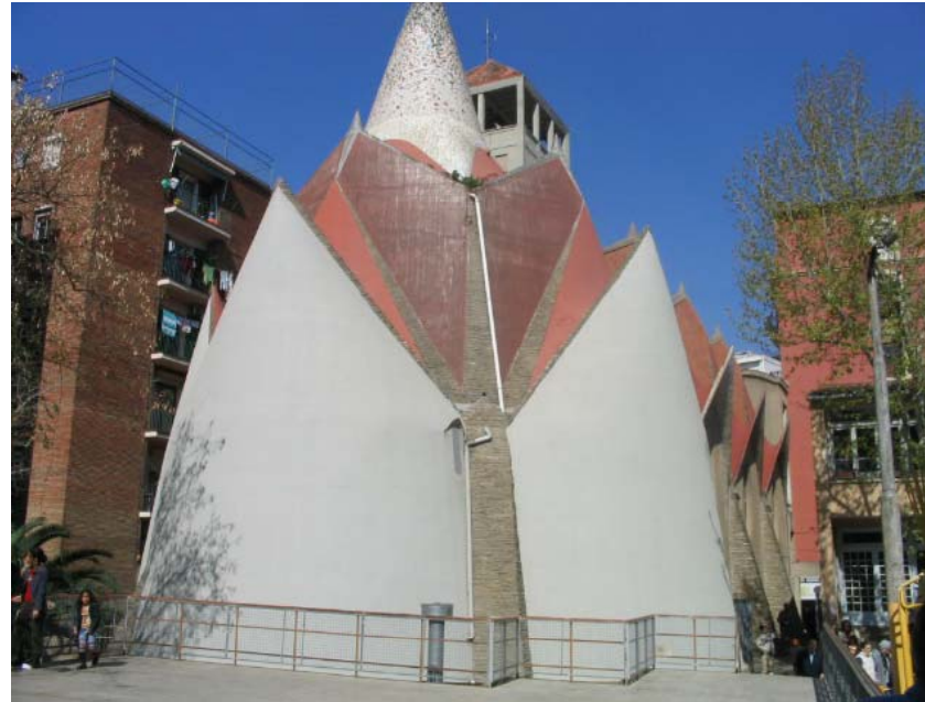
Vista exterior del edificio
