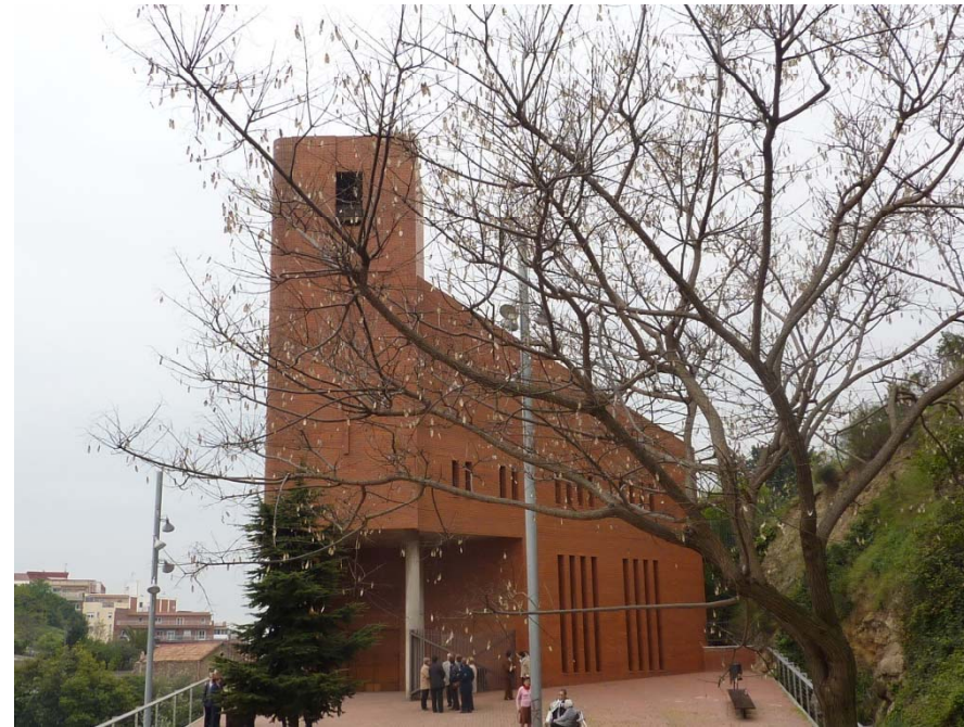
Fachada principal del templo y campanario
