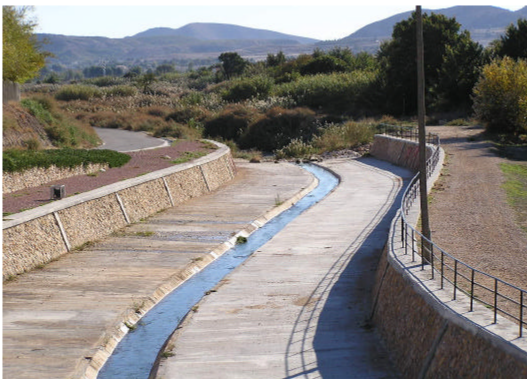
Foto 2.- Río Vinalopó a su paso por Sax (Alto Vinalopó).
