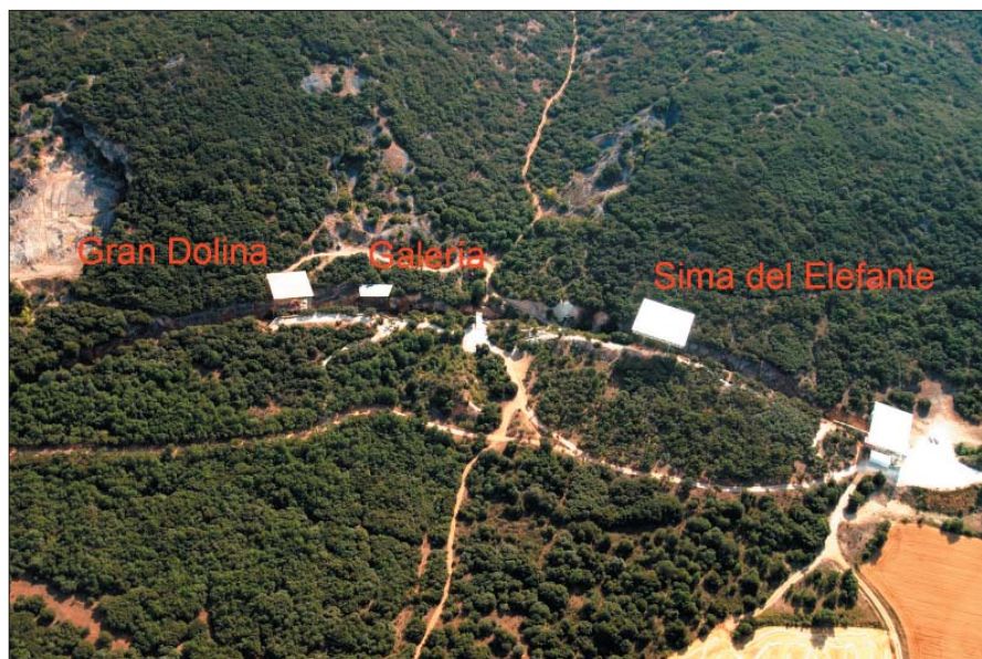
Figura VI.3 Vista aérea de la Trincher del Ferrocarril con los yacimientos señalizados.
