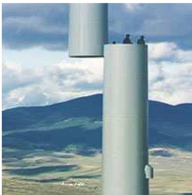
El cielo gira: la instalación de los molinos de viento.
