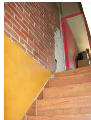
Imagen 6_Acceso 2º Piso
