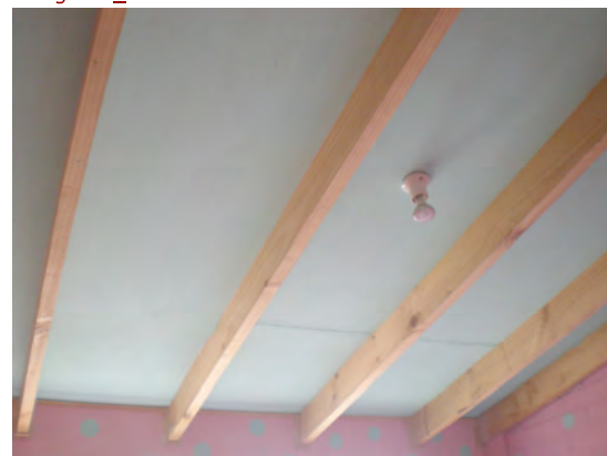
Imagen 6_ Piso 2º / Techumbre 2ª Etapa
