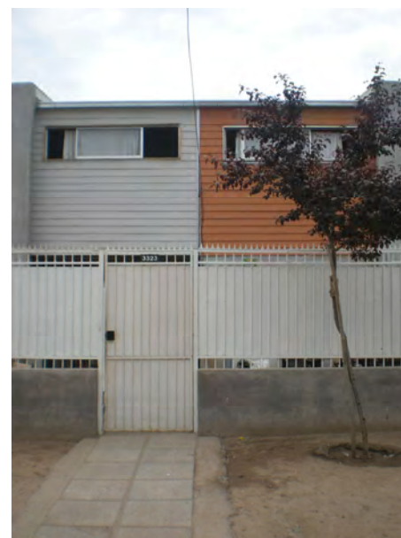
Fachada Principal Vivienda
