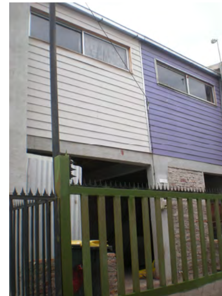
Fachada Principal Vivienda
