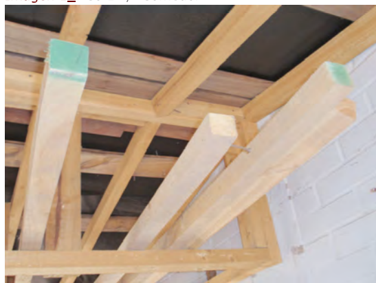
Imagen 5_Piso 2º / Estructura Techumbre
