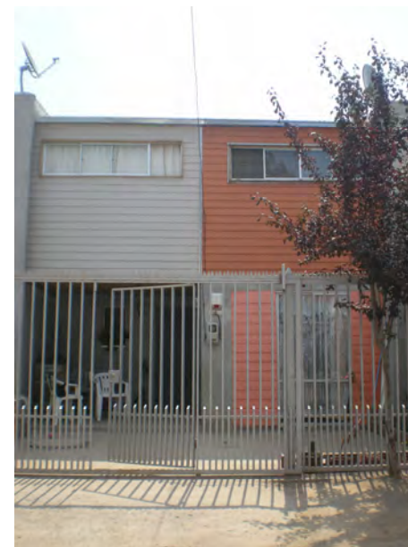
Fachada Principal Vivienda
