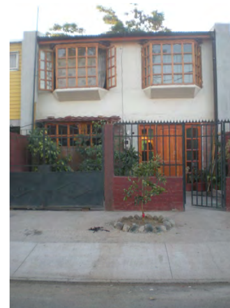
Fachada Principal Vivienda
