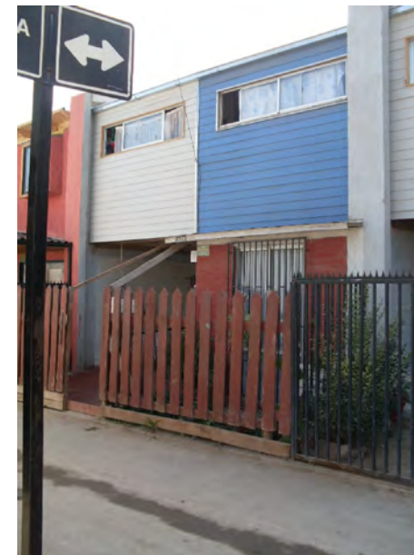
Fachada Principal Vivienda
