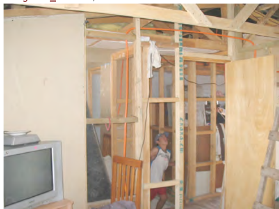
Imagen 5_Piso 2º / Estructura Tabiquería
