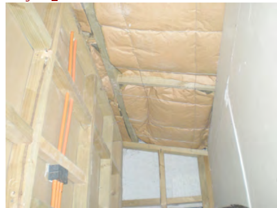
Imagen 6_ Piso 2º / Techumbre 2ª Etapa
