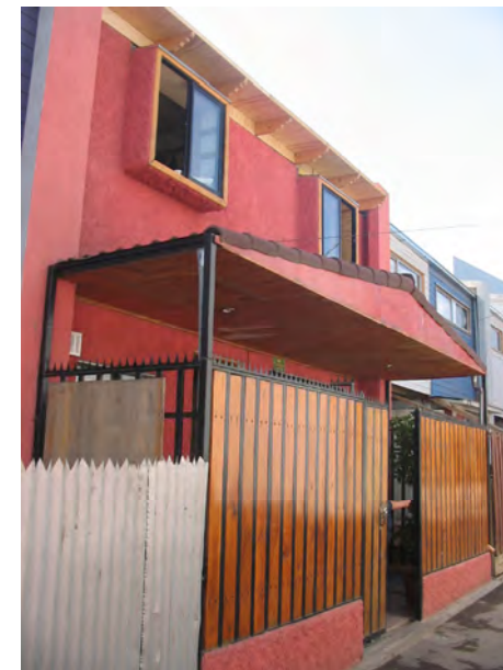
Fachada Principal Vivienda
