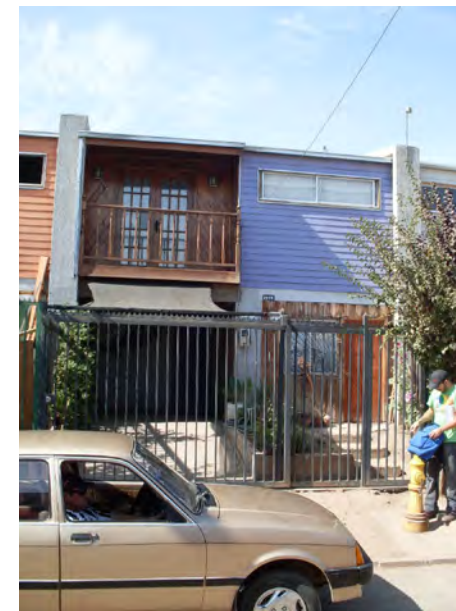
Fachada Principal Vivienda
