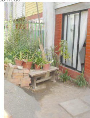
Imagen 6_Piso 1º /Cerramiento Exterior
