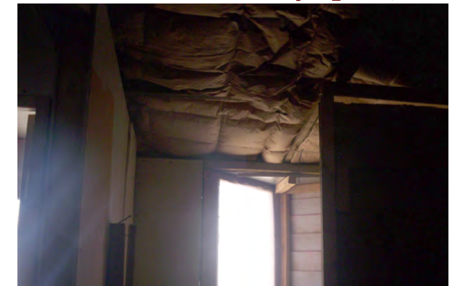
Imagen 8_ Piso 2º / Techumbre
