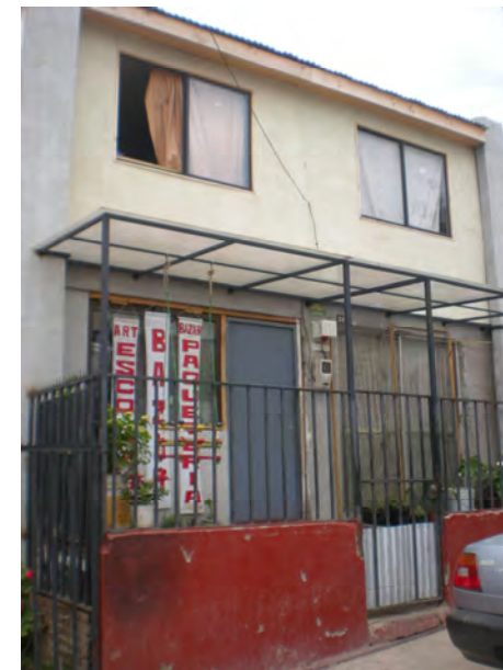
Fachada Principal Vivienda
