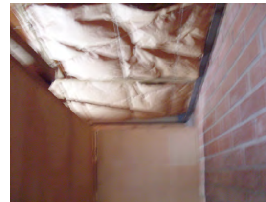
Imagen 3_Piso 1º/ Techumbre 1ª Etapa
