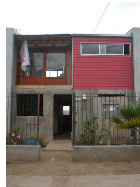
Fachada Principal Vivienda
