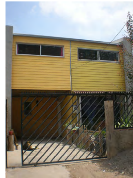
Fachada Principal Vivienda
