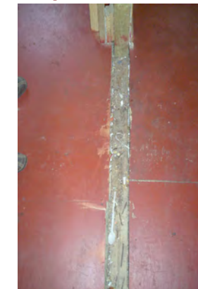
Imagen 7_ 2º Piso / Pavimento
