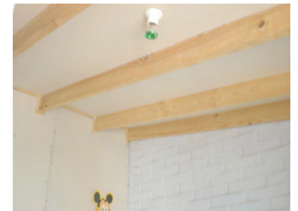
Imagen 4_Piso 2º / Techumbre 2ª Etapa
