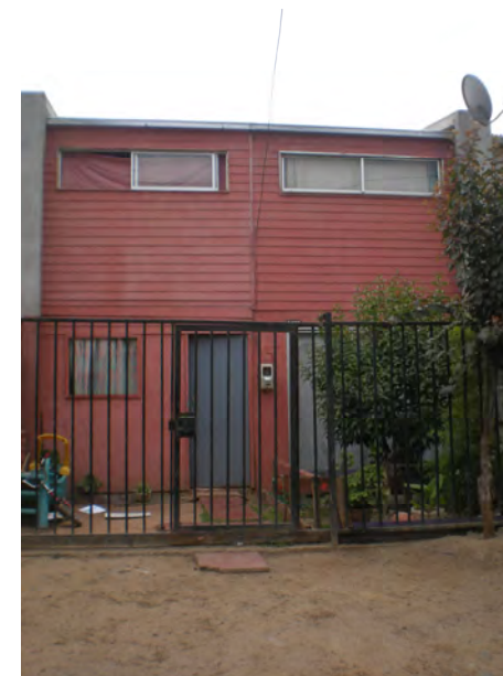
Fachada Principal Vivienda
