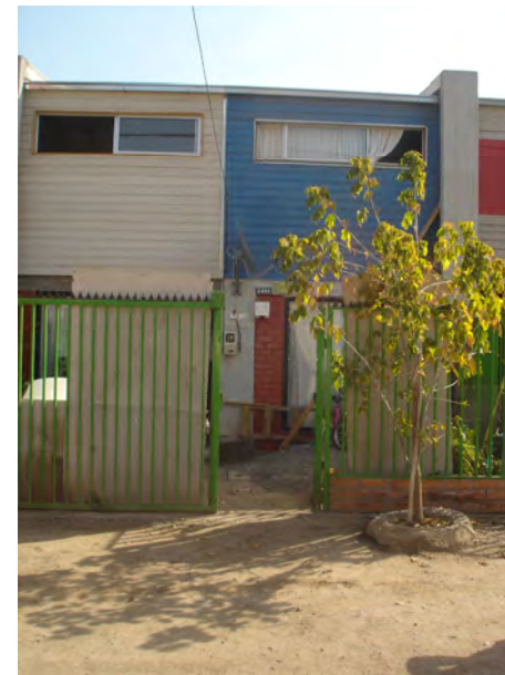
Fachada Principal Vivienda
