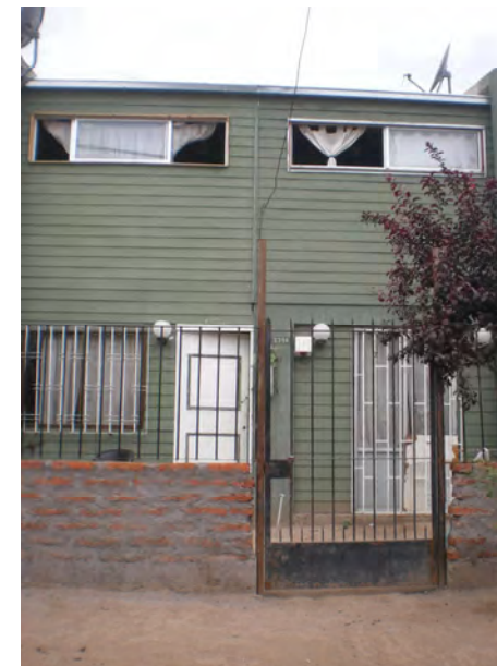
Fachada Principal Vivienda
