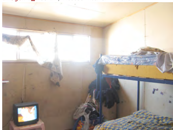
Imagen 5_Piso 2º / Techumbre 1ª Etapa
