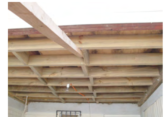
Imagen 4_Estructura Pavimento 2º Piso
