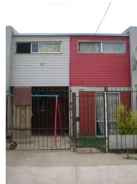
Fachada Principal Vivienda
