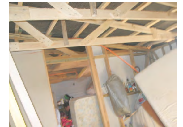
Imagen 4_Piso 2º / Estructura Techumbre
