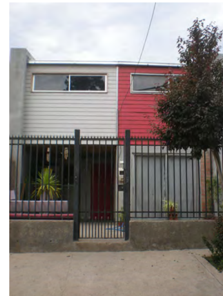
Fachada Principal Vivienda
