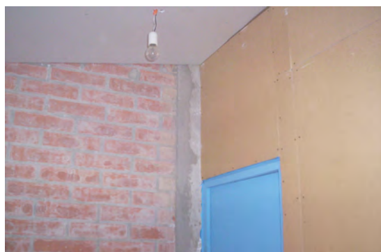
Imagen 5_Piso 2º / Techumbre 1ª Etapa / Pasillo
