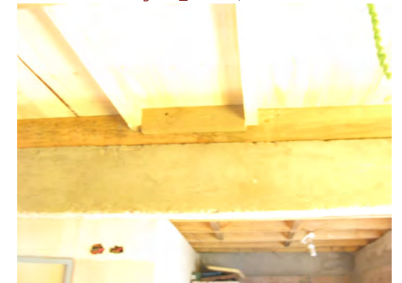
Imagen 8_Piso 1º / Estructura pavimento 2º piso
