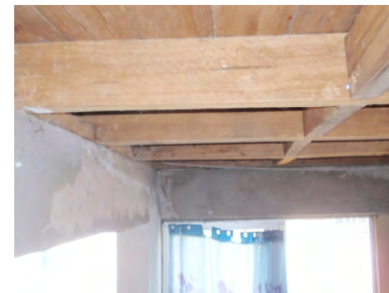
Imagen 3_Piso 1º/ Estructura Pavimento 2º Piso
