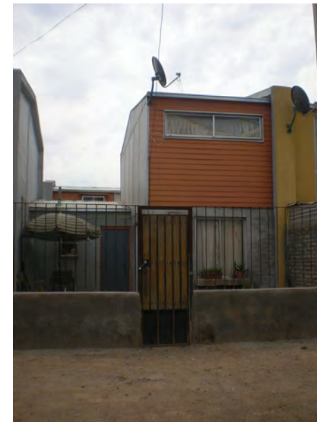
Fachada Principal Vivienda
