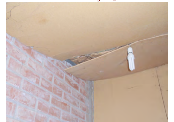
Imagen 8_Piso 2º / Estructura Techumbre Balcon
