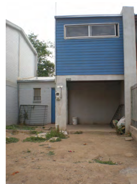
Fachada Principal Vivienda
