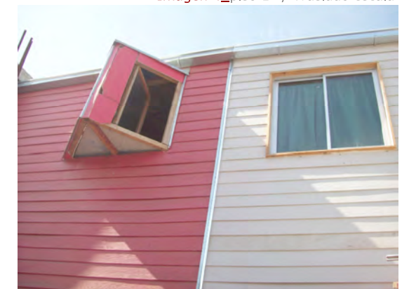
Imagen 8_Cerramiento Fachada Posterior
