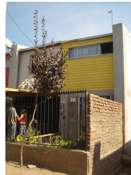
Fachada Principal Vivienda
