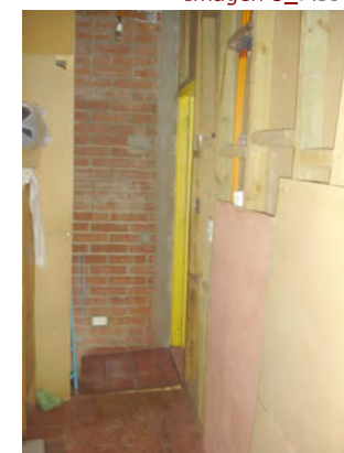
Imagen 7_Piso 2º / Pasillo
