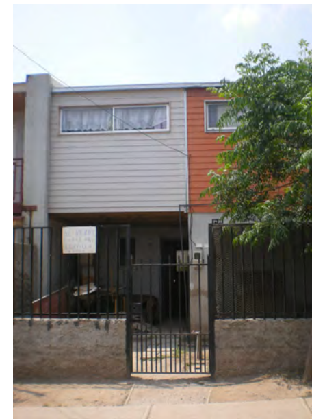
Fachada Principal Vivienda
