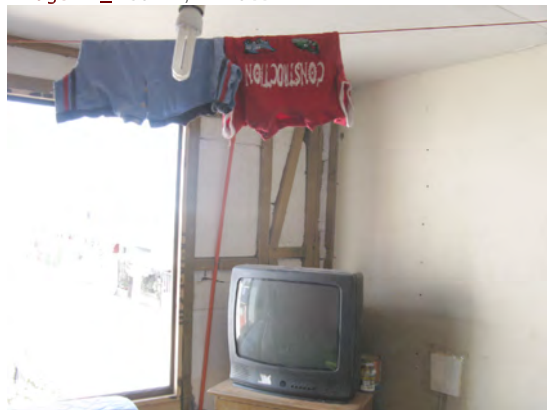
Imagen 5_Piso 2º / Estructura Tabiquería
