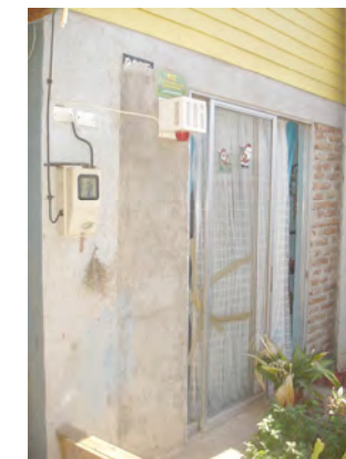
Imagen 3_Piso 1º / Cerramiento exterior
