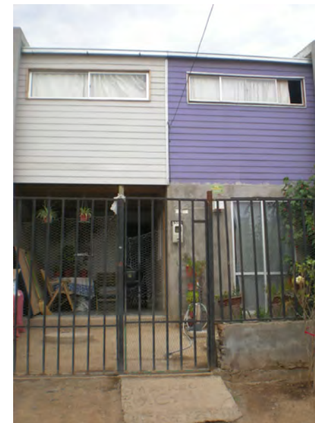
Fachada Principal Vivienda
