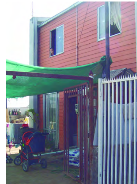
Fachada Principal Vivienda
