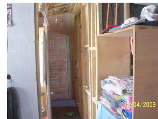
Imagen 4_Piso 2º / Pasillo
