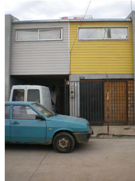
Fachada Principal Vivienda
