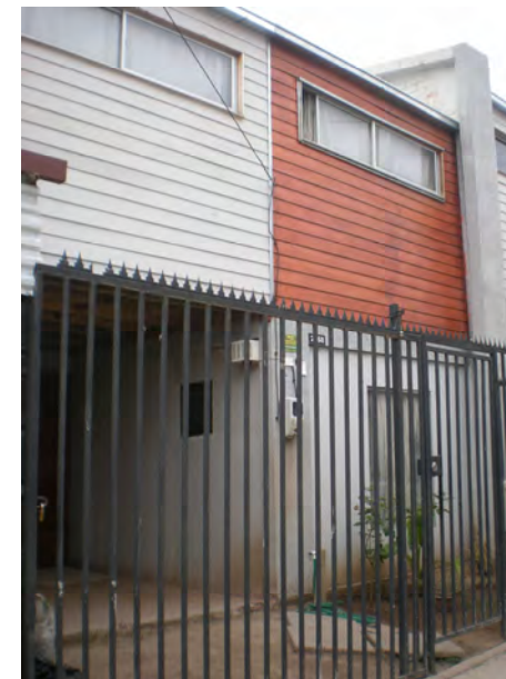
Fachada Principal Vivienda
