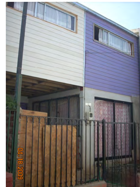
Fachada Principal Vivienda
