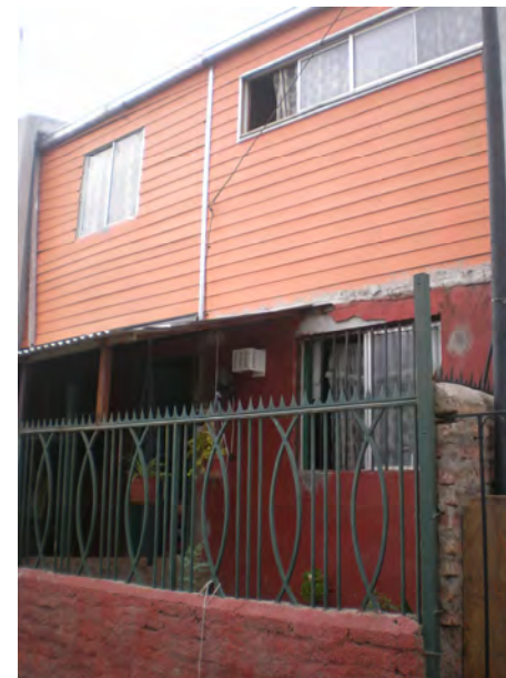
Fachada Principal Vivienda
