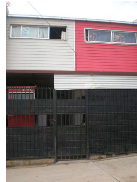
Fachada Principal Vivienda
