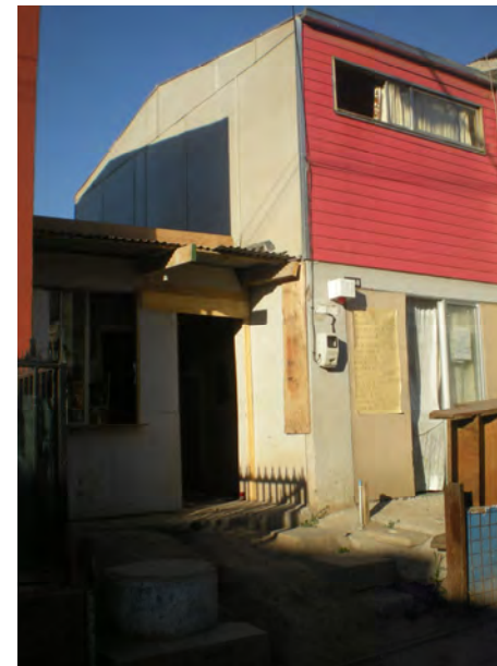
Fachada Principal Vivienda
