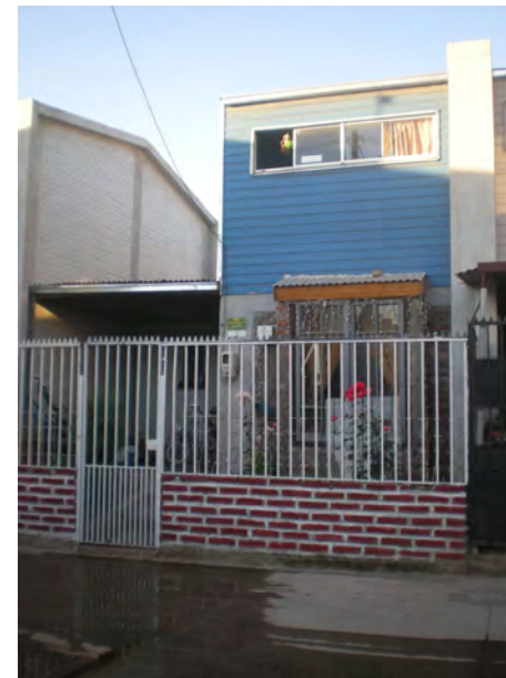
Fachada Principal Vivienda
