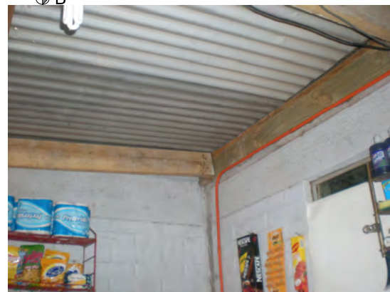
Imagen 2_Piso 1º/ Techumbre Almacen
