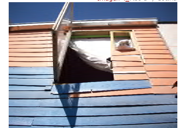
Imagen 8_Cerramiento Fachada Posterior
