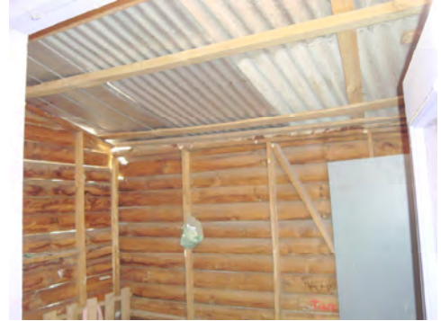
Caso de Estudio 19 Tabiquería de madera / lavadero nueva construcción
