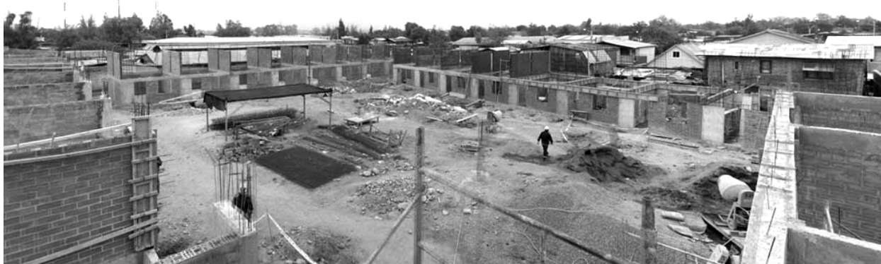
Fig. 17 _Sistema estructural de albañilería reforzada_ Villa Nuestra Vida (2008)
