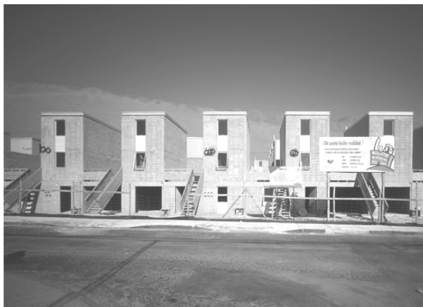
Fig. 2_ Viviendas del proyecto entregadas
