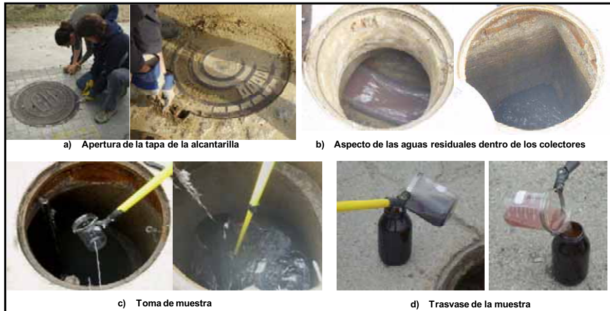
Figura 16. Imágenes del muestreo en la red de alcantarillado
