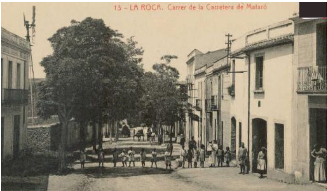
Fotos n. 55 i 56.- Imatges de la carretera de Mataró a la seva arribada al poble de la Roca.
