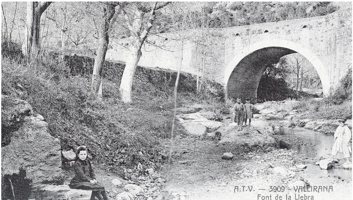
Fotos n. 17 i 18.- Imatges de la carretera a l'altura de Vallirana i de les obres de fàbrica construïdes. A la foto inferior, el pont de la Llebra.
