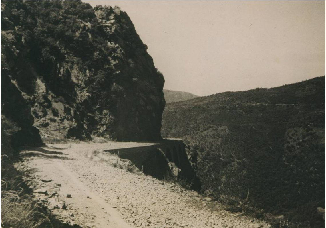
Foto n. 144.- Carretera de Santa Fe de Montseny eb el lloc del Roc Ramon. El projecte de la via des de Campins és de 1929-1933 (ANC, Codis n. 220-221), però les obres es portaren a terme durant els cinquanta del segle XX.
