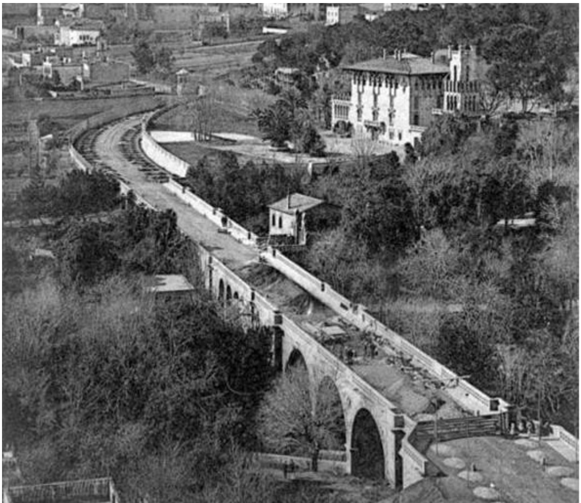
Foto n. 120.- Fotografia de l'actual Passeig Reina Elisenda de Montcada amb el pont de Felip en construcció als primers anys del segle XX (Arxiu del Districte de Sarrià-Sant Gervasi).
