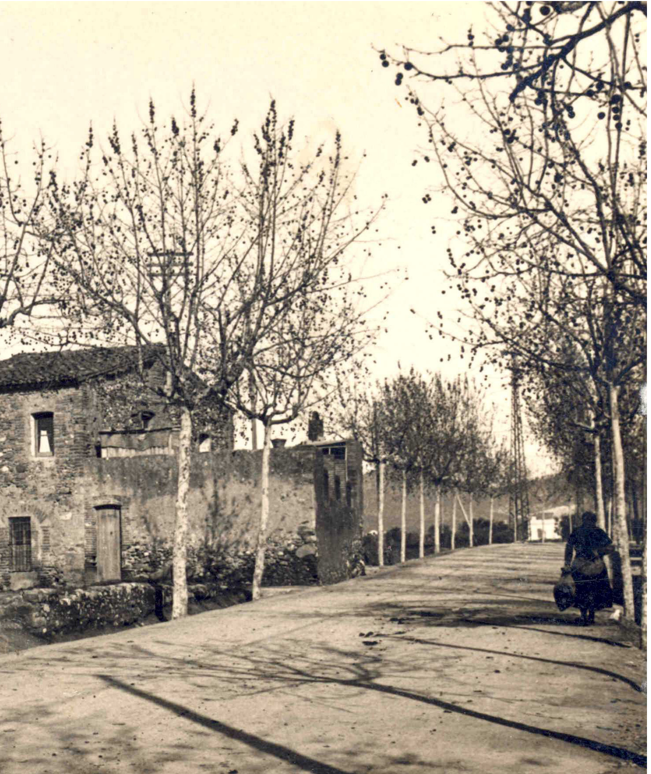
Carretera de Matadepera. Masia de Can Fatjó (Arxiu Municipal de Terrassa)
