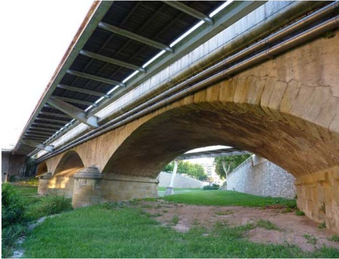
Foto n. 32.- Imatge actual del pont sobre el Mèder, amb les passarel·les de vianants.
