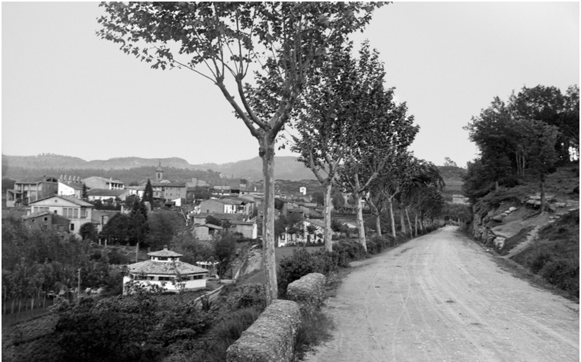
Foto n. 90.- Arribada de la carretera a Sant Julià de Vilatorça (IEFC).
