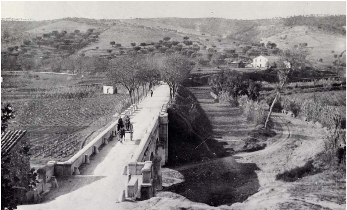
Foto n. 65.- Imatge del pont sobre la riera de Sentmenat a l'entrada del poble.
