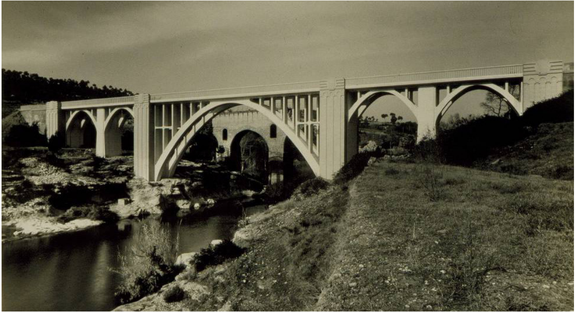
Foto n. 141.- Pont nou de Cabrianes sobre el Llobregat. Publicat a la Revista San Jorge, n. 9, de 1953.
