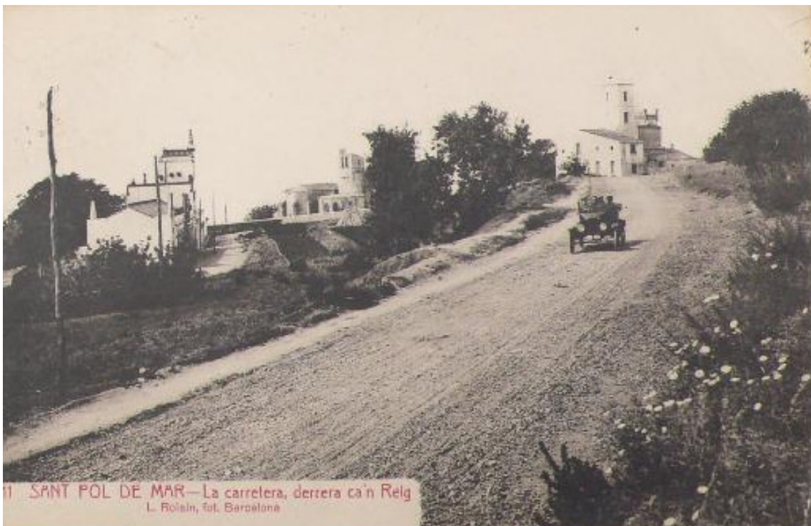
Foto n.º 20.- Paviment de macadam a la N-II a l'altura de Sant Pol de Mar
