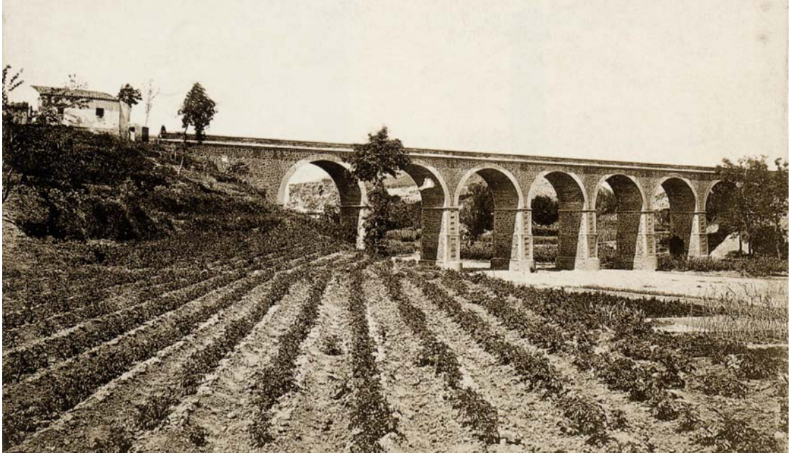
Foto n. 59.- Imatge del Pont de la Salut sobre el riu Ripoll al tram de carretera entre Sabadell i Caldes de Montbui.
