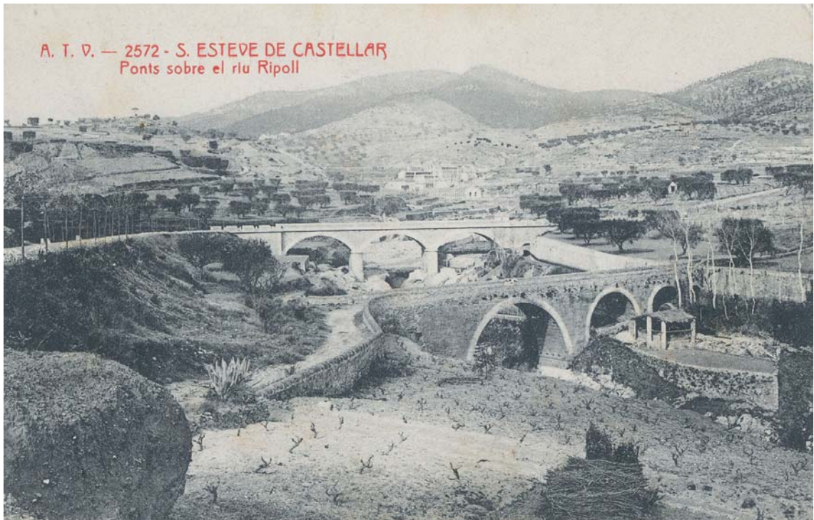
Foto n. 111.- Imatge dels ponts de Sant Esteve de Castellar sobre el riu Ripoll; el segon, el pont nou de la carretera a Sentmenat (Col·lecció E. Boix).
