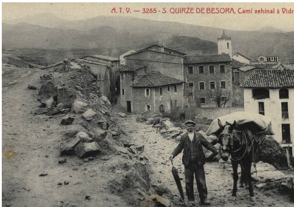
Foto n. 130.- Imatge de l'esplanació del camí veïnal de Sant Quirze de Besora a Vidrà. Procedent del Pla de 1905 (Col·lecció E. Boix).
