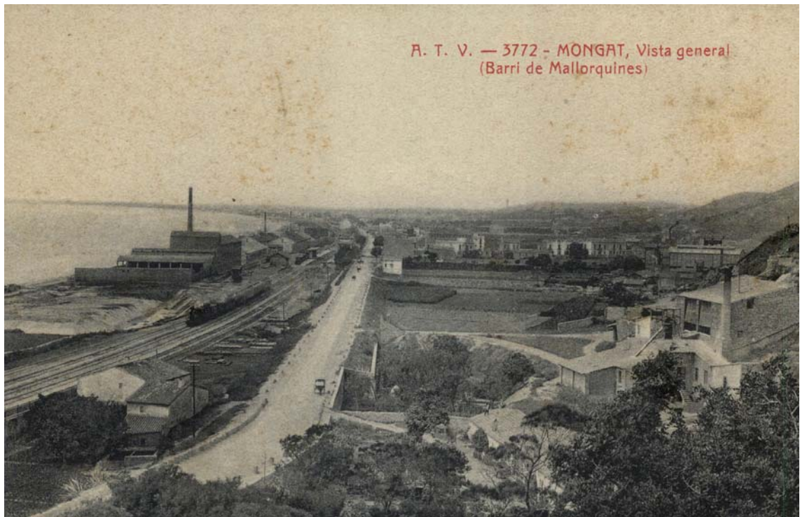
Foto n.8.- Imatge de la carretera reial en el tram del Maresme, a l'altura de Montgat (Col·lecció E. Boix).
