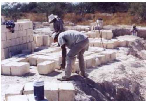
g) Extracción del “cuartón” o “sillar”
