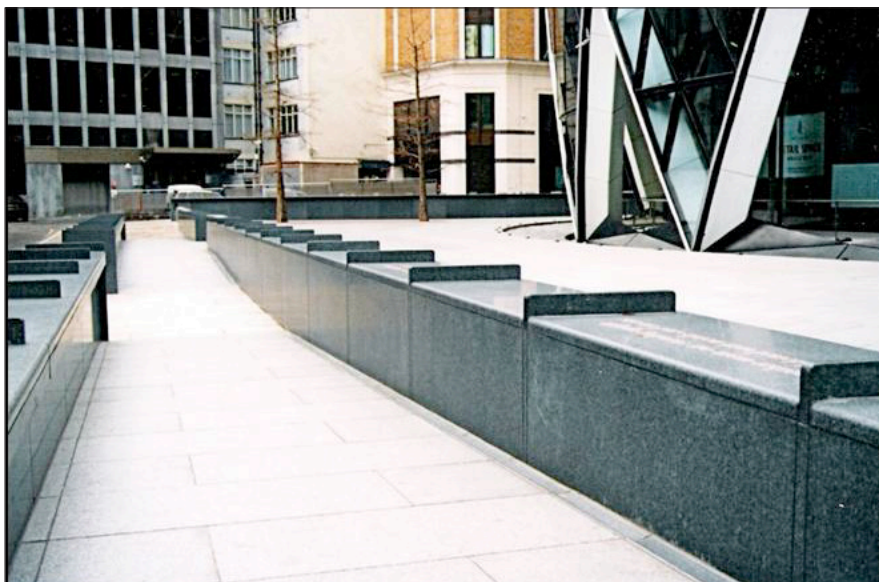
Skatestoppers en los bancos de granito pulido frente a uno de los emblemáticos edificios de la City del arquitecto N. Foster. London, 2005. Fuente: X. Camino.
