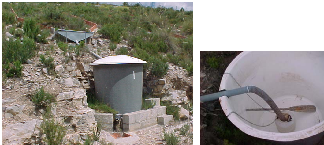
Foto 3.1.2_1. Detalle del colector y tanque en las parcelas de erosión de la estación experimental de La Concordia.
