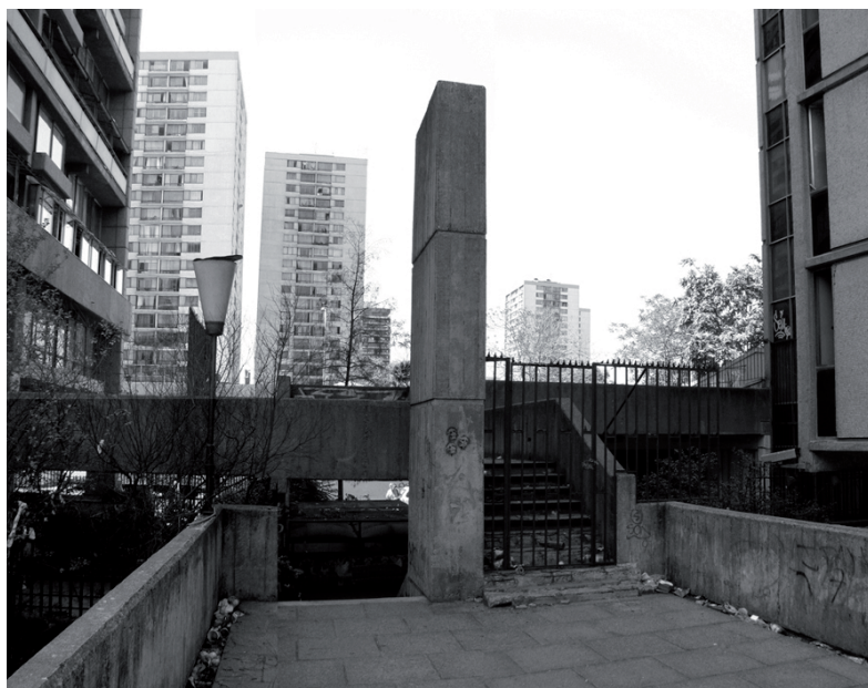
15 Acceso clausurado del sistema de circulaciones elevadas entre la torre 3 y el edificio "chapa" poniente del conjunto de BVCH. Vista hacia el sur, fotografía de la autora, enero 2009.
