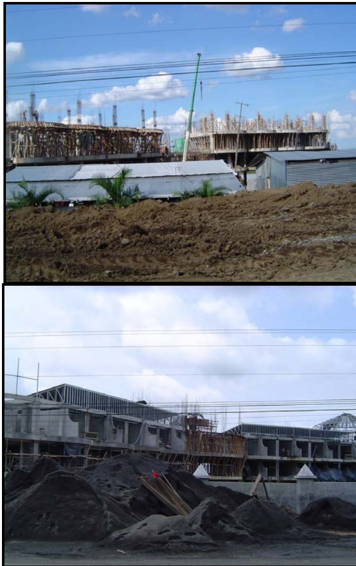
Fotografía 19. Secuencia de construcción de un hotel a lo largo de la carretera hacia el Volcán Arenal. Diferencia de tiempo entre fotografías, 3 meses
