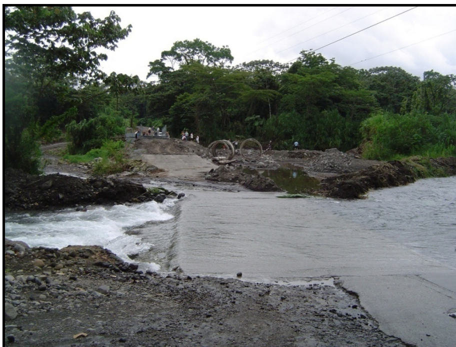
Fotografía 38. Al fondo puente en reconstrucción, Río Agua Caliente sobre parte del camino que comunica El Castillo con la carretera a La Fortuna
