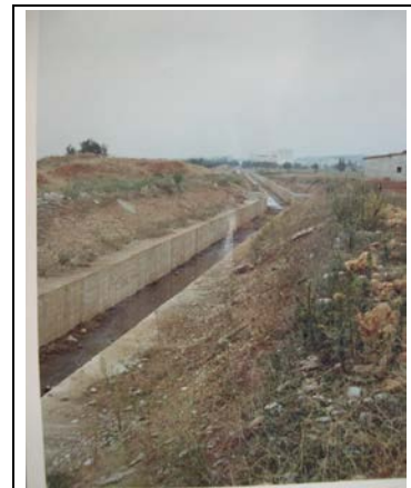
Foto 11.7. Canal del marge dret. Tram en secció rectangular (novembre de 1967)
