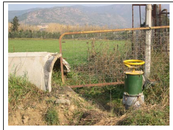
Foto 11.19. Substitució de la xarxa àeria de reg per una de soterrada a les proximitats de Pedret. Autor: David Pavón (7-II-2007)
