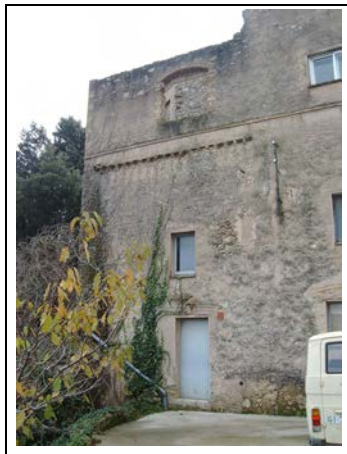
Foto 14.33. Antiga central hidroelèctrica de Caixàs (Les Escaules, Boadella d'Emp.). Autor: David Pavón (9-XII-2005)
