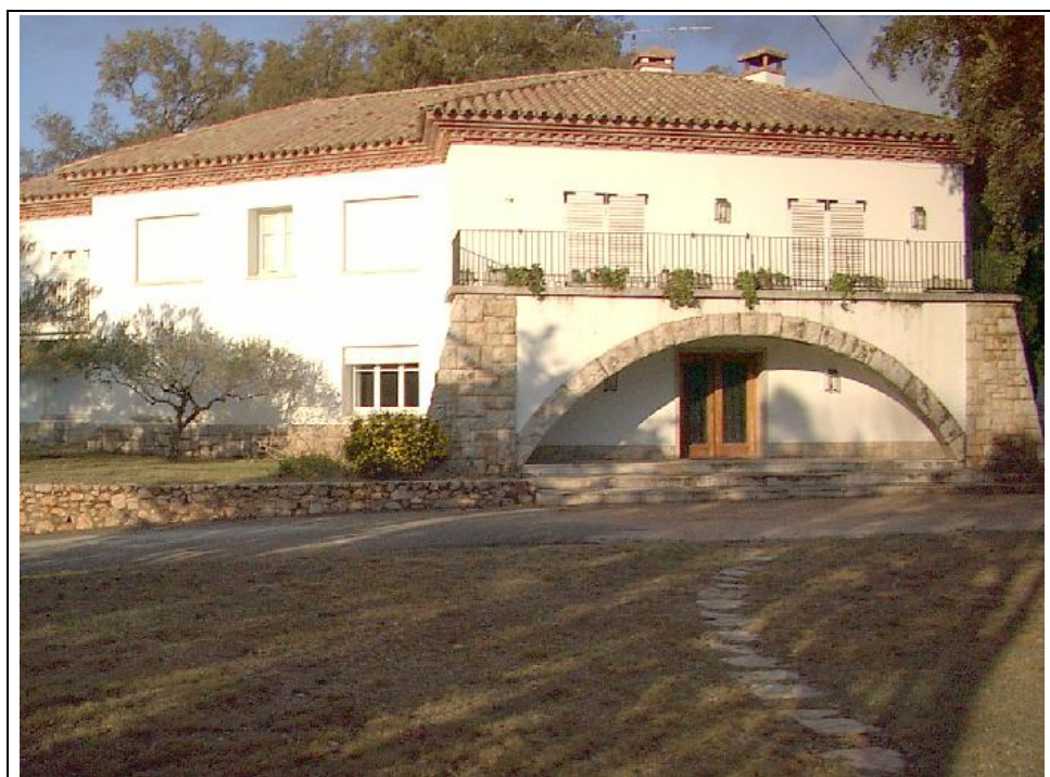
Foto 10.14. Casa de l'administració de l'embassament de Boadella. Autor: David Pavón (17-I-2001)
