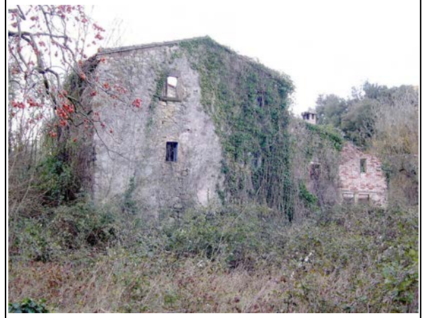
Foto 14.14. Antiga central hidroelèctrica d'Albanyà o d'en Gorgot. Autor: David Pavón (3-I-2006)
