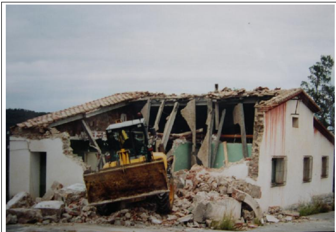
Foto 10.15. Enderroc de l'antiga caserna de la Guàrdia Civil aixecada, en un emplaçament estratègic, per garantir la seguretat i l'ordre durant la construcció de la presa (octubre de 1994).
