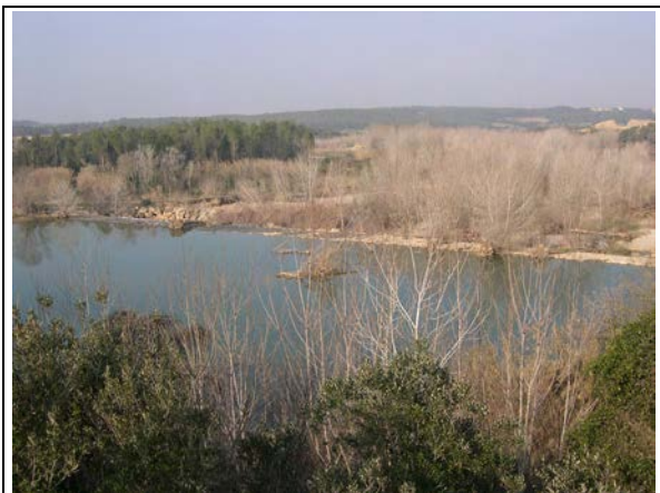
Foto 14.11. Resclosa de la central hidroelèctrica de Sant Mori, des d'on es deriven les aigües per a la central hidroelèctrica del mateix nom. Autor: David Pavón (15-II-2006)
