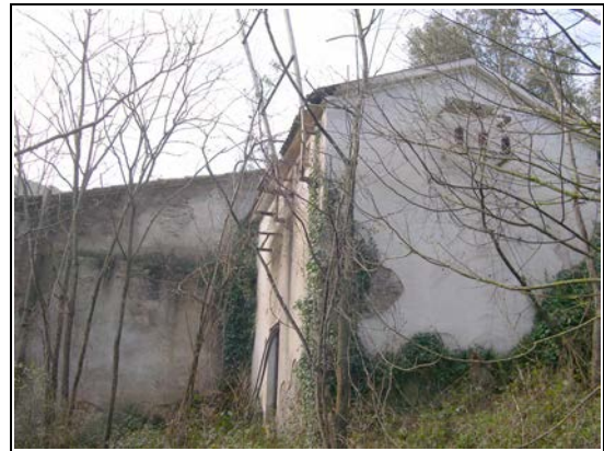
Foto 14.20. Antiga central hidroelèctrica d'en Cabot (Maçanet de Cabrenys), al riu Arnera.
