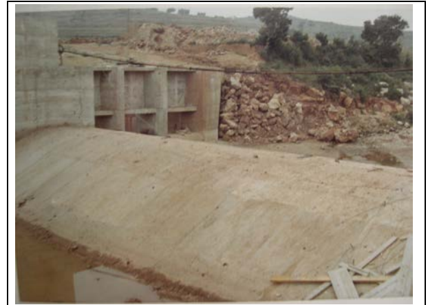
Foto.11 5. Resclosa de derivació de Pont de Molins. Sobreixidor (novembre de 1967)
