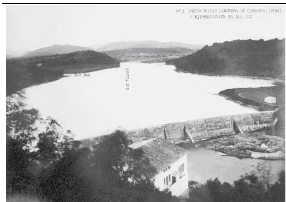
Foto 9.6. Espectacular resclosa de la central hidroelèctrica de Serinyà, amb el seu edifici en primer terme. El conjunt, ubicat acte seguit de l'aiguabarreig entre els rius Ser i el Fluvià, havia de quedar inundat per vas de l'embassament de Crespí el qual reculava fins als peus de Besalú.
