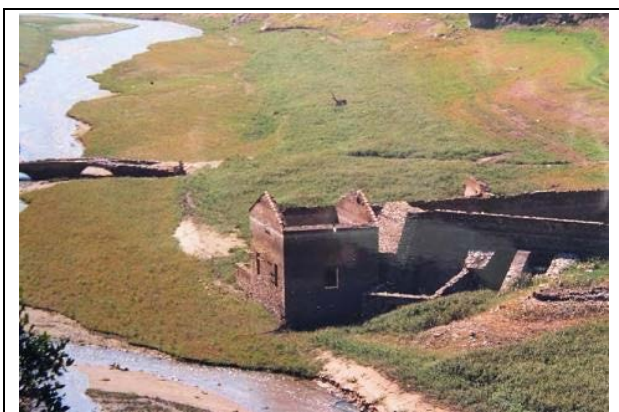
Foto 14.23. Vella central hidroelèctrica "La Arnerense", primera de les construïdes a la conca de la Muga i inundada per l'embassament de Boadella; posada al descobert durant la sequera de 1994 (Darnius), al riu Arnera.
