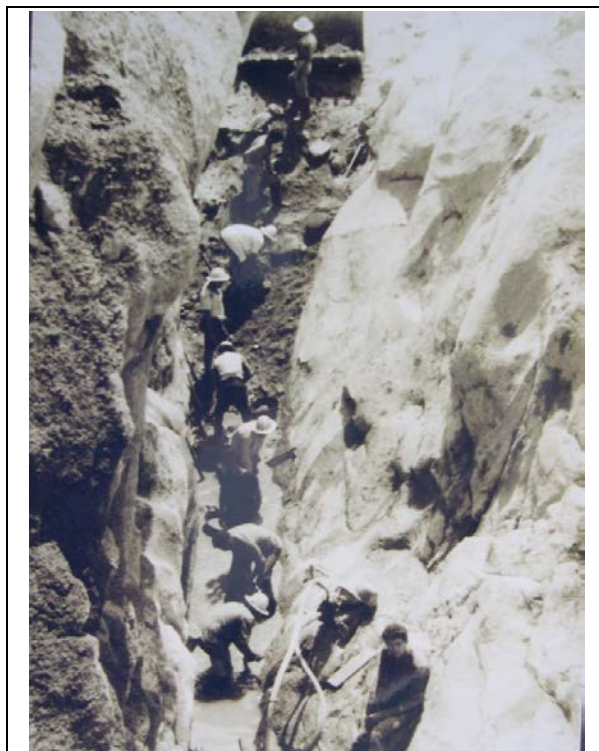
Foto 10.13. Formigonat de l'esquerda que va quedar al descobert en fer les excavacions pels fonaments de la presa al llit del riu Muga (agost de 1964). Dipòsit: Arxiu administratiu de l'embassament de Boadella (AAEB)
