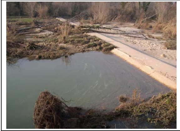
Foto 14.7. Resclosa de la central hidroelèctrica d'Arenys d'Empordà, des d'on es deriven les aigües per a la central hidroelèctrica del mateix nom. Autor: David Pavón (15-II-2006)
