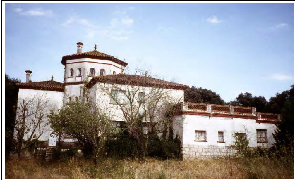
Foto 9.15. Casa de l'Administració pel que havia de ser el futur embassament de Crespà (a l'extrem nord del Pla de Martís), acabada a inicis de la dècada dels 40. És la realització més visible d'aquell projecte que acabà sent desestimat el 1944.
