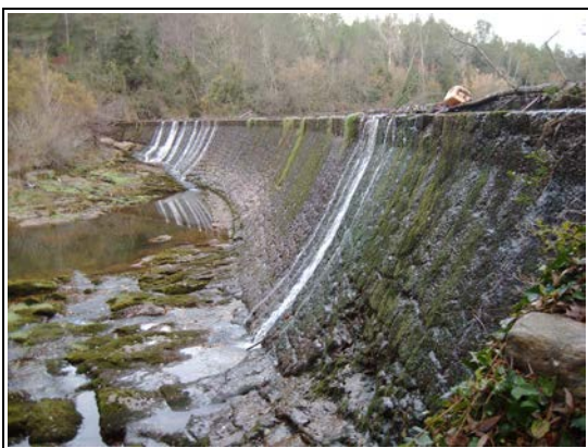
Foto 14.29. Resclosa "El Colze", que adreça les aigües a l'antiga central hidroelèctrica d'en Grida o d'en Miquel (Boadella d'Empordà). Autor: David Pavón (9-XII-2005)
