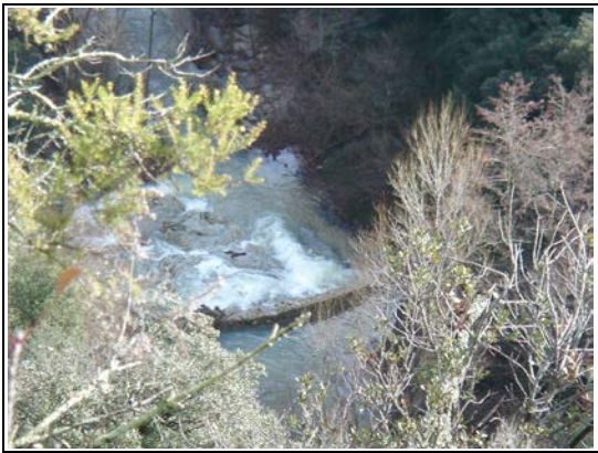
Foto 14.21. Resclosa de l'antiga central hidroelèctrica municipal de Maçanet de Cabrenys, al riu Arnera.
