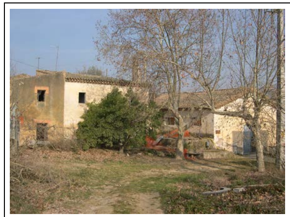
Foto 14.12. Central hidroelèctrica de Sant Mori.
