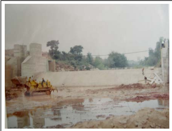
Foto 11.4. Resclosa de derivació de Pont de Molins vista aigües avall. Des d'aquest punt arrencaran els dos canals principals de reg de la zona regable de la Muga (novembre de 1967)
