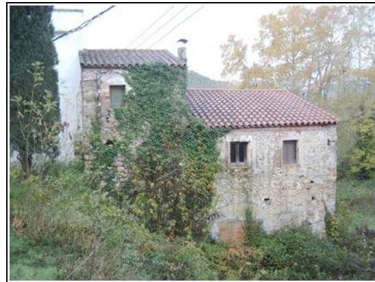
Foto 14.28. Antiga central hidroelèctrica Boadella I –antic molí del Castell– (Boadella d'Empordà). Autor: David Pavón (9-XII-2005)
