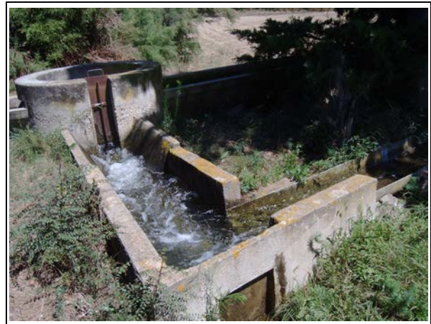
Foto 11.13. Derivació d'una sèquia secundària des de la primària "Cabanes núm. 5" per a l'abastament dels camps. Autor: David Pavón (26-VIII-2004)
