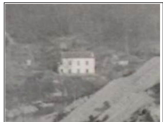
Foto 14.24. Vella central hidroelèctrica "La Farga", inundada per l'embassament de Boadella.
