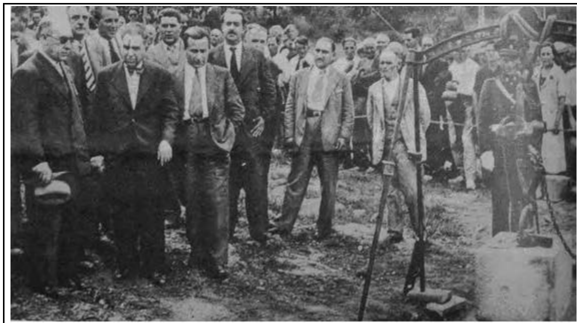
Foto 9.11. Col·locació de la primera pedra de la casa de l'administració pel futur embassament de Crespà, al Pla de Martís. Hi assistiren, entre d'altres, el ministre d'Obres Públiques, Manuel Marraco, el seu predecessor, Guerra del Ríó i el conseller d'Obres Públiques de la Generalitat, Vallès i Pujals. Assenyalant, amb el dit avall, el delegat del govern dels Serveis Hidràulics del Pirineu Oriental, Jaime Polo Otín (9-IX-1935).
