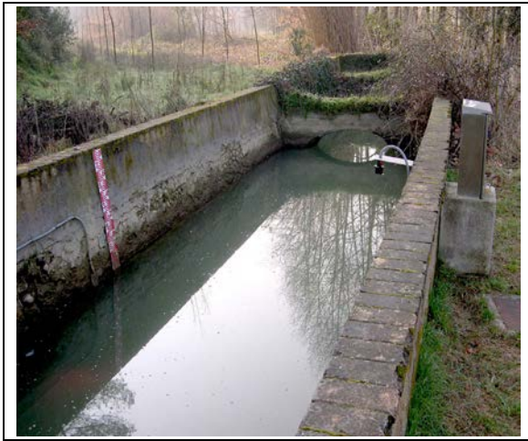
Foto 14.9. Canal de conducció d'aigües des de la resclosa del Fluvià fins a la central hidroelèctrica d'Arenys d'Empordà. Autor: David Pavón (15-II-2006)
