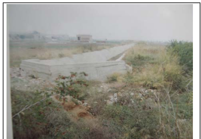
Foto 11.9. Canal del marge dret. Tram en secció trapezial (novembre de 1967)
