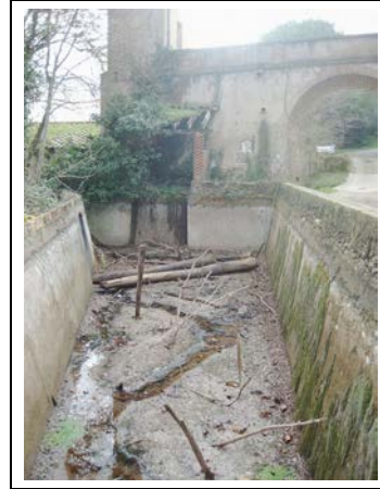
Foto 14.32. Antiga central hidroelèctrica de Genover o Molí de Baix (Les Escaules, Boadella d'Empordà). Autor: David Pavón (9-XII-2005)
