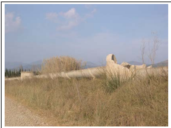
Foto 11.18. Abandonament de la xarxa àeria de reg a les proximitats de Pedret. Autor: David Pavón (7-II-2007)
