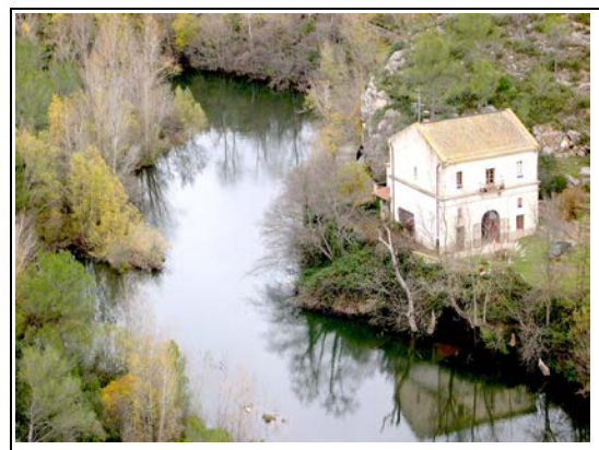
Foto 14.30. Antiga central hidroelèctrica d'en Grida o d'en Miquel (Boadella d'Empordà). Autor: David Pavón (9-XII-2005)
