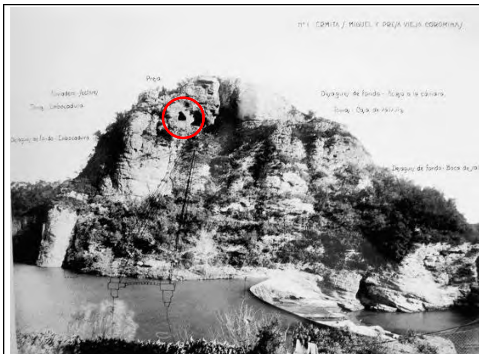
Foto 9.4. Perspectiva des de la vertical en la que es preveia la construcció de la presa de Crespià (es veu dibuixada pels facultatius). Just a sota, la resclosa de derivació d'aigües per a la immediata central de Martís. Al capdamunt del cingle de conglomerat s'aprecia l'esvoranc (encerclat) de la capella troglodítica medieval de St. Miquel de la Roca. Font: CSHPO, Pantano de Crespià , 1930. Fotografies annexes. Fons del Ministeri d'Obres Públiques, AGA (Alcalá de Henares)
