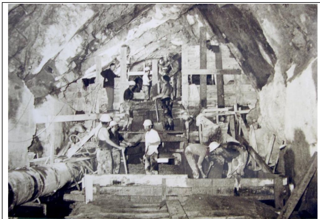
Foto 10.12. Treballs per tancar el túnel de desviació d'aigües de la Muga, quan les obres del mur ja estan molt avançades (agost de 1967). Dipòsit: Arxiu administratiu de l'embassament de Boadella (AAEB)
