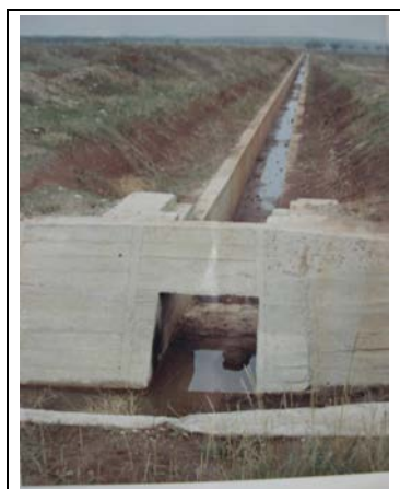
Foto 11.8. Presa de la sèquia Figueres núm. 1 al canal principal del marge dret (novembre de 1967)
