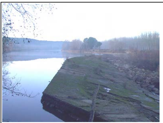
Foto 14.5. Resclosa de la central hidroelèctrica de Calabuig (Bàscara), des d'on es deriven les aigües per a la central hidroelèctrica del mateix nom.
