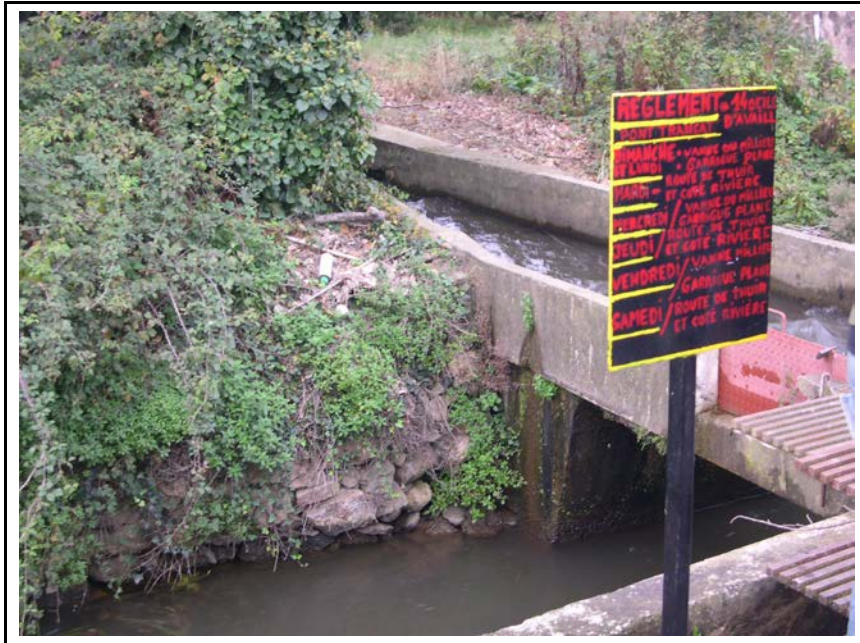
Foto 7.8. Intersecció entre el rec de Tuir (inferior) i el rec de Corbera (superior); ambdós són canals d'irrigació històrics de la Catalunya Nord que fertilitzen el Riberal del riu Tet, per la seva riba dreta. Proximitats del poble de Corbera les Cabanes (Rosselló). Reglament de distribució de torns de rec per ullals (recs secundaris) en funció dels trams i dels dies de la setmana. Autor: David Pavón (27-X-2006)
