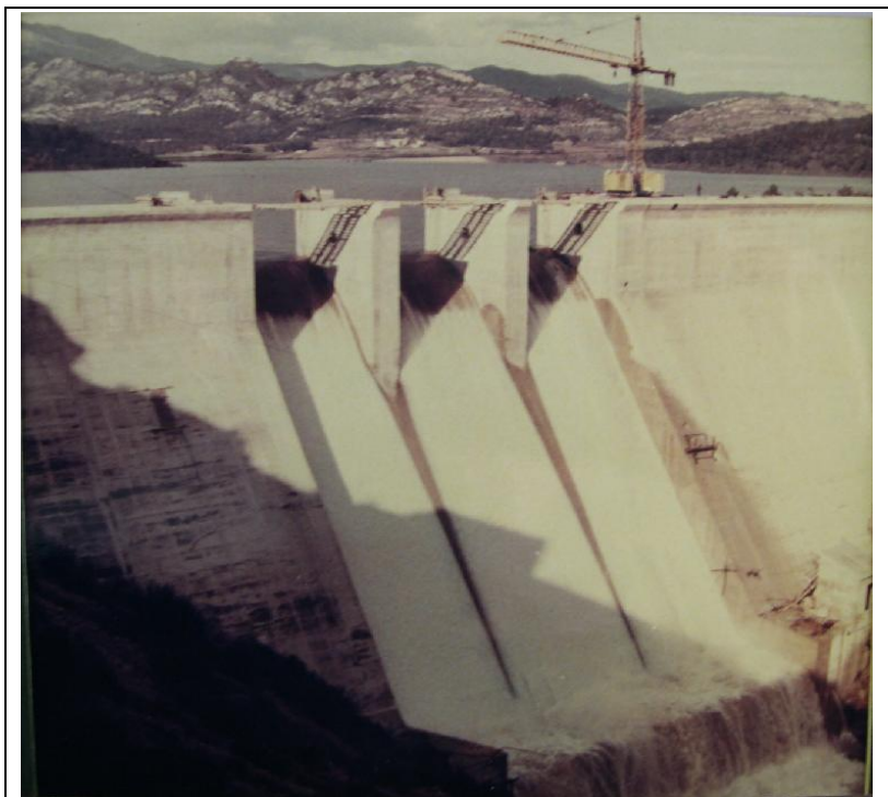
Foto 10.11. Embassament omplert, per primer cop, després de l'episodi de pluges del novembre i desembre de 1968. Encara no està acabada la coronació de la presa i s'han d'instal·lar les tres comportes que permetran augmentar el volum global del pantà. Dipòsit: Arxiu administratiu de l'embassament de Boadella (AAEB)
