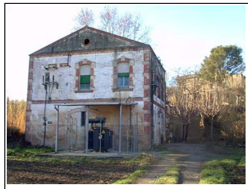
Foto 14.6. Central hidroelèctrica de Calabuig (Bàscara).
