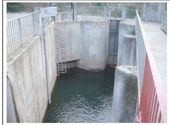
Foto 11.11. Derivació del canal principal de l'esquerra des de la resclosa de Pont de Molins. Autor: David Serra (5-I-2006)
