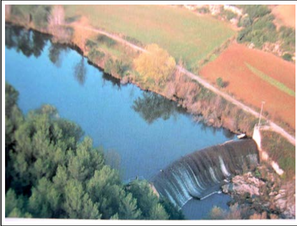
Foto 14.31. Resclosa que adreça les aigües a l'antiga central hidroelèctrica de Genover o Molí de Baix (Les Escaules, Boadella d'Empordà). Actualment utilitzada com a contraembassament regulador de cabals entre la central hidroelèctrica Boadella II (peu de presa de Boadella) i els regants. Autor: Robert Prat (2003).
