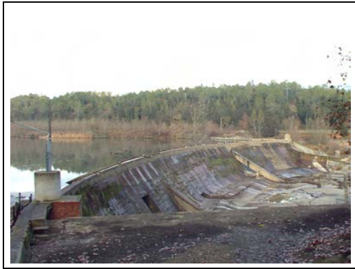
Foto 14.1. Resclosa de la central hidroelèctrica de Serinyà, des d'on es deriven les aigües per a la central hidroelèctrica del mateix nom.
