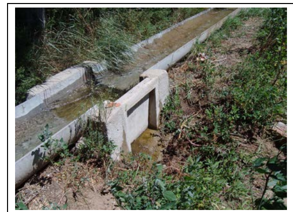
Foto 11.15. Bagant tancat. Accés de les aigües de reg a les parcel·les inferiors. Autor: David Pavón (26-VIII-2004)
