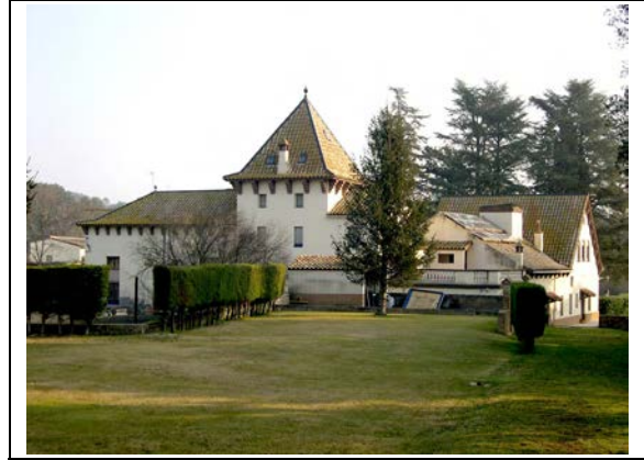
Foto 14.8. Central hidroelèctrica d'Arenys d'Empordà.
