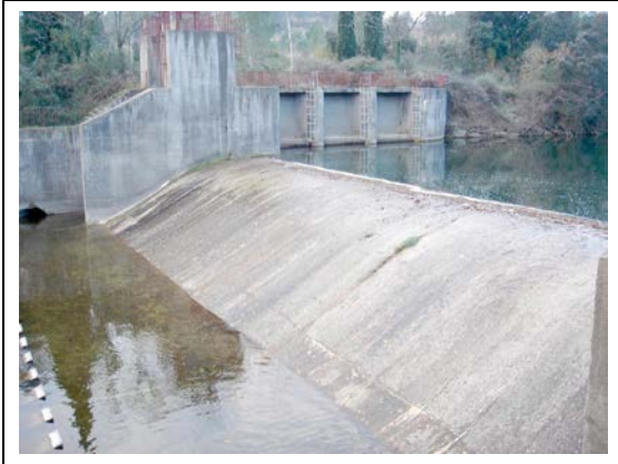
Foto 11.10. Resclosa de derivació dels canals principals de la dreta i de l'esquerra a Pont de Molins. Autor: David Serra (5-I-2006)
