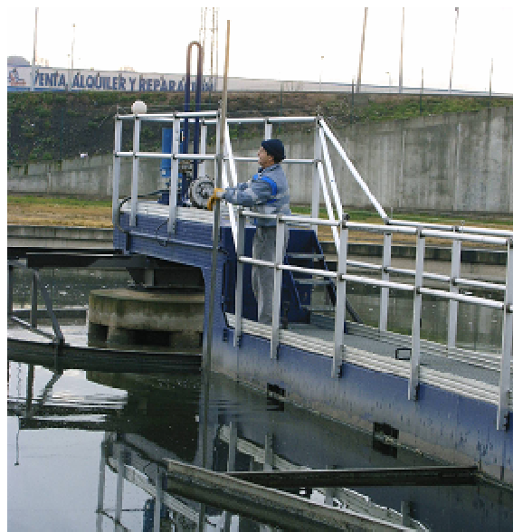
Figura 4.7. Mesura manual de l'alçada de fang en el decantador secundari de l'EDAR Granollers.
