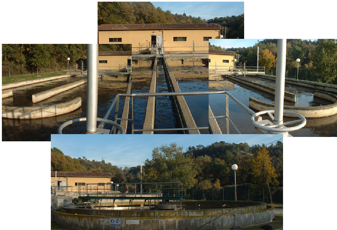
Figura 5.2. Fotografies de l'EDAR Taradell amb els dos carrousel, el decantador secundari de la línia 2 i la caseta on hi ha part del pretractament (bombeig de capçalera i tamís) i de la línia de fangs (filtres banda)
