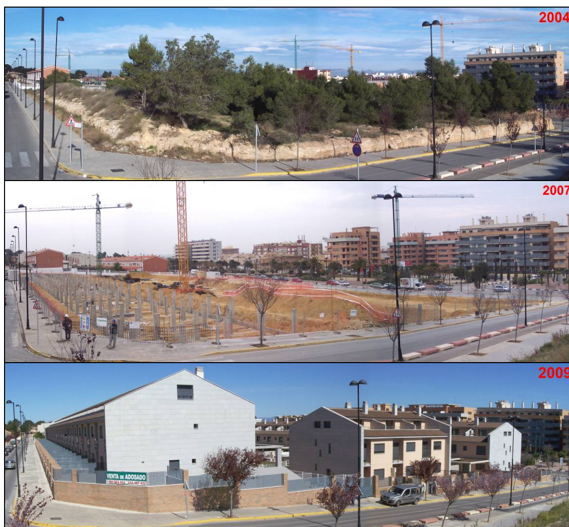
Figura 3: Ejemplo de retirada de suelo para la edificación de viviendas. Suroeste de Torrent (Valencia).
