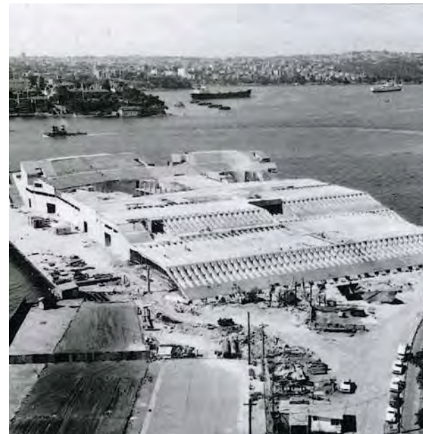
9. Plataforma en construcció l'Òpera de Sydney, Utzon.
