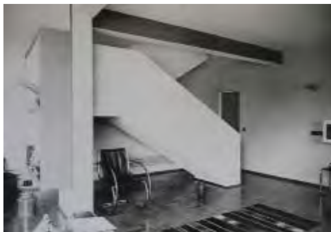
20. Martienssen. Dupla biga-pilar. Fotografia des del finestral.
