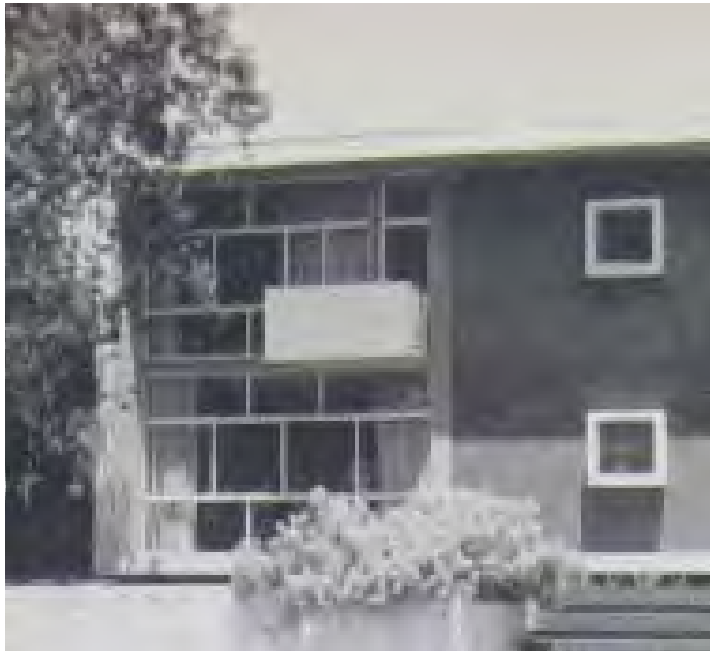
21. Martienssen. Balcó a la casa a Grenside.
