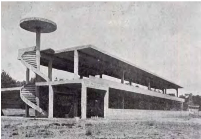
6. Fotografia en construcció del Sanatori d'Hilversum. Duiker i Bjolet.
