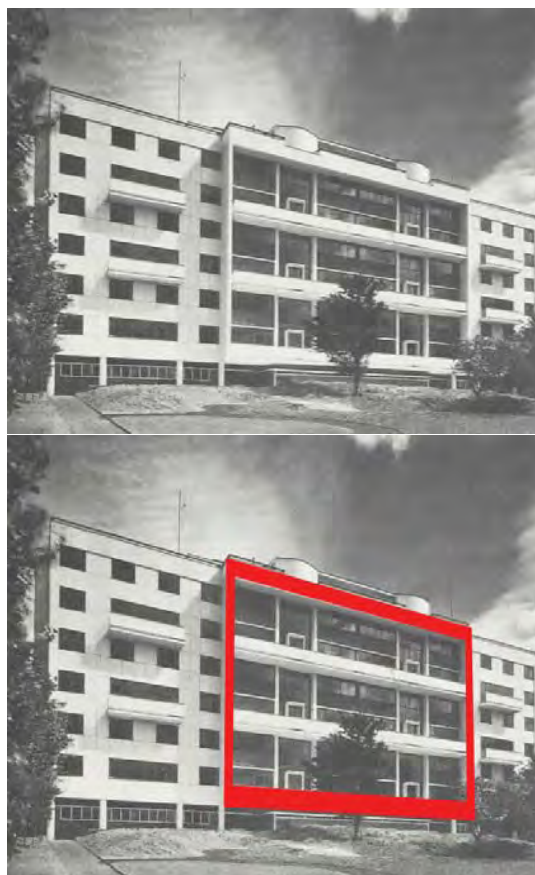
54. Visió de la façana cap al parc del: Highpoint II. Lubetkin.
