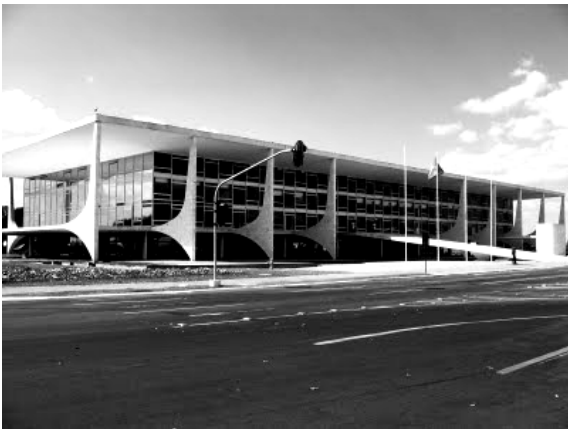
Fig. 1.3.17 Palácio do Planalto, Brasília 1958. Oscar Niemeyer. El edificio, heredero de la arquitectura de Le Corbusier, aprovecha las posibilidades plásticas del hormigón para otorgar una imagen a través de la estructura.
