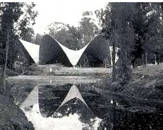
Fig. 1.1.11 Paraboloides hiperbólicos de hormigón del restaurante “Los Manantiales”, construido por Felix Candela en 1951 en Xochimilco, próximo a Ciudad de México. La forma de la estructura permite canalizar los esfuerzos de tal manera que los espesores de lámina son mínimos. De este modo, a través de la búsqueda de unos mecanismos de comportamiento estructural, se origina la forma arquitectónica.
