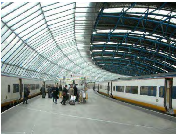
Fig. 1.2.7 Estación de Waterloo, N. Grimshaw, Londres 1993. A partir de una pauta determinada y de una notable sofisticación de los enlaces, la estructura colabora en la configuración formal de la imagen arquitectónica.
