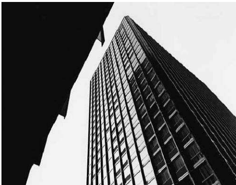
Fig. 1.5.4-5 National Life Insurance. Frank Lloyd Wright 1924. La llegada a la meta: primer edificio de oficinas de envergadura, en forma de torre, donde Wright consiguió un planteamiento estructural diferente al de la Escuela de Chicago, mediante forjados en voladizo que liberan las esquinas del edificio. El tipo de pilares propuestos se repite en muchos proyectos posteriores, como en el campus de la Universidad de Florida de 1934.
