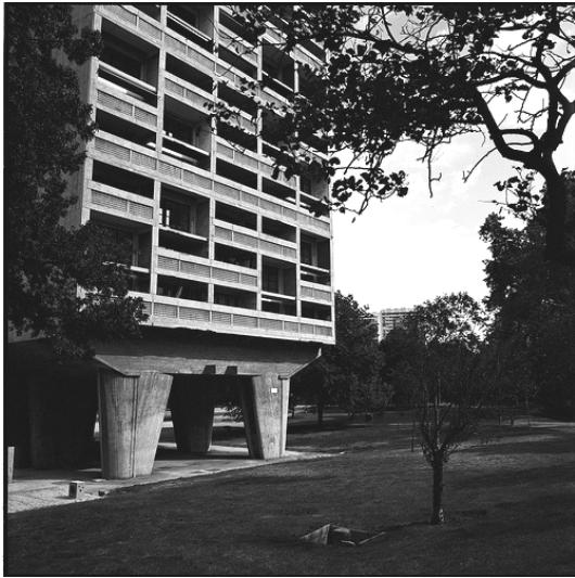
Fig. 1.3.1 Unité d'Habitation de Marsella, Le Corbusier 1952. El cambio del sistema de la estructura en las plantas superiores a una macroestructura mediante pilares y un gran tablero de hormigón, permite liberar la planta baja del edificio, al mismo tiempo que se obtiene un interesante resultado formal.
