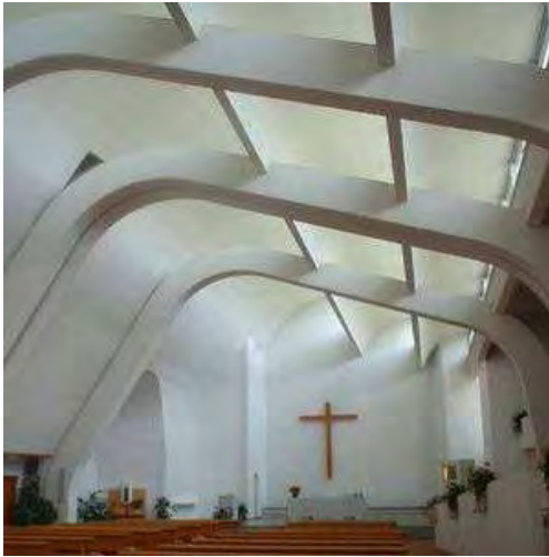
Fig. 1.3.11 En la iglesia de Riola de Alvar Aalto, 1978, las suaves formas de la estructura sirven como base y tamiz de las entradas de luz natural.
