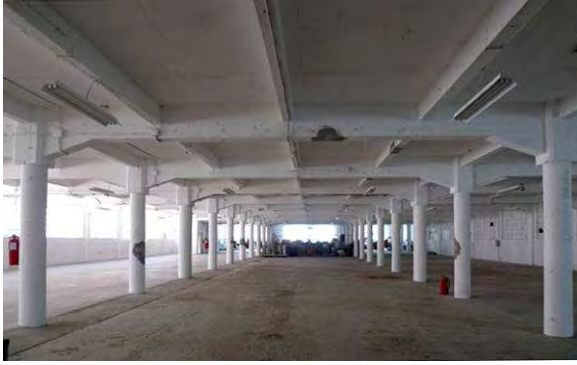
Fig. 1.2.5 Edificio Consoni, construido en Zorrotzaurre, Bilbao, en 1957. La trama de la estructura sirve para ordenar el espacio, aunque no lo condiciona formalmente.
