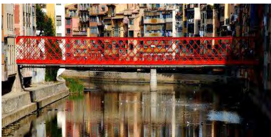
Fig. 1.2.13 Pasarela Eiffel sobre el río Onyar en Girona, 1876. El diseño del puente está guiado por la claridad y el correcto funcionamiento estructural. Sus dimensiones suelen estar optimizadas para todas las secciones y se considera mayor su nivel estético cuanto mayor sea el afinado del dimensionado.
