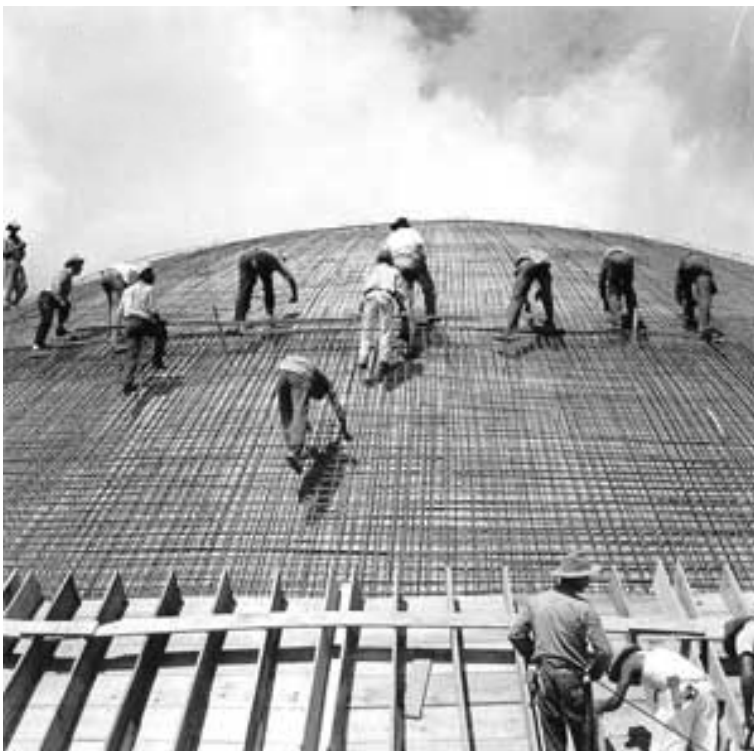
Fig. 1.6.9 Detalle del proceso de construcción, en concreto del armado de una de las cúpulas de hormigón de Brasilia.
