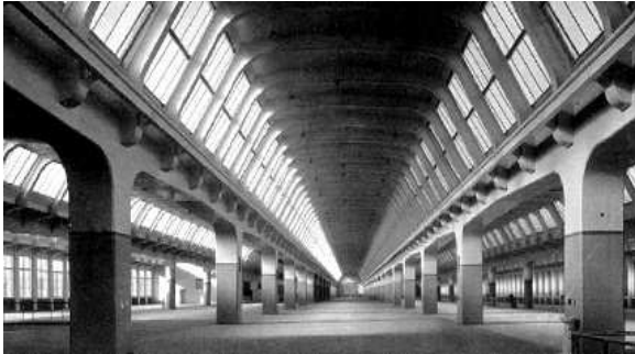
Fig. 1.2.6 Laboratorio de Ingeniería Ford, MI, Albert Kahn, 1925. La estructura porticada es la referencia y condicionante para el resto de elementos constructivos.
