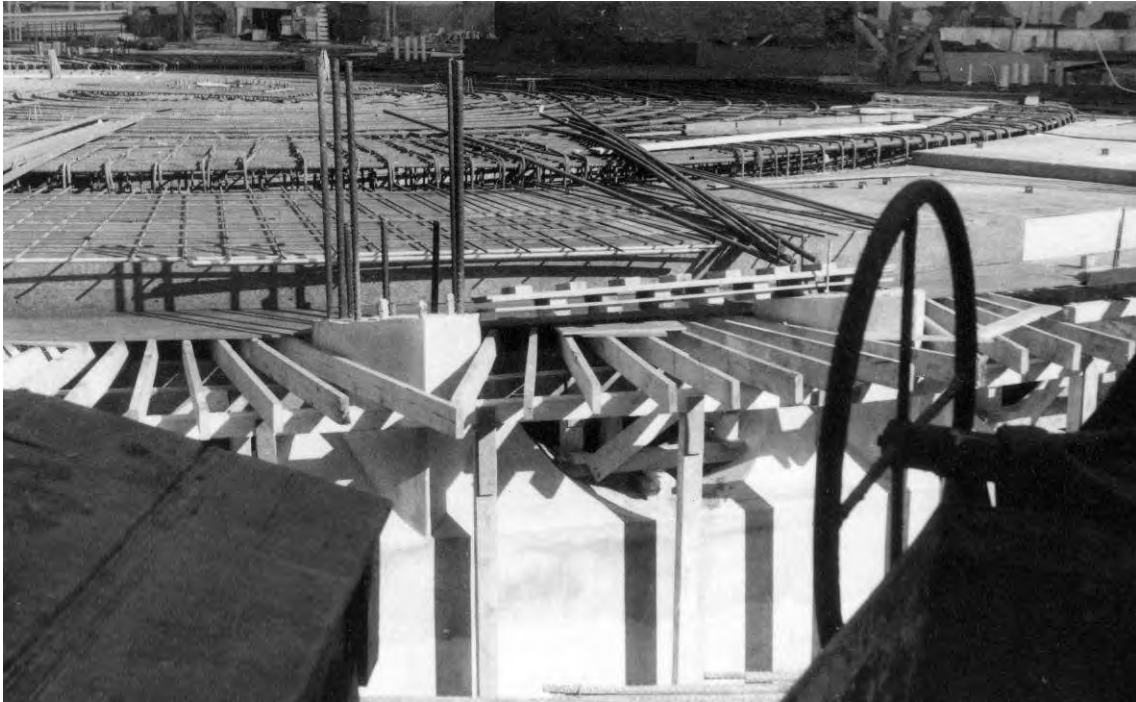
Fig. 3.9.3. El muro que forma el cilindro de la planta baja y primera nace de los pilares del sótano que delimitan la sala de actos. De este modo, el muro también tiene la función de una gran viga pared entre pilares, permitiendo la entrada de luz a la planta sótano a través de un patio inglés lateral. La intersección entre los pilares y el cilindro puede considerarse como una región “D” puesto que el gradiente de tensiones es muy alto alrededor del apoyo.
