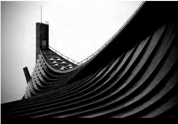
Fig. 1.3.15 Exterior del edificio. La forma de la estructura responde a su comportamiento resistente y a la vez resulta ser la clara imagen del edificio.
