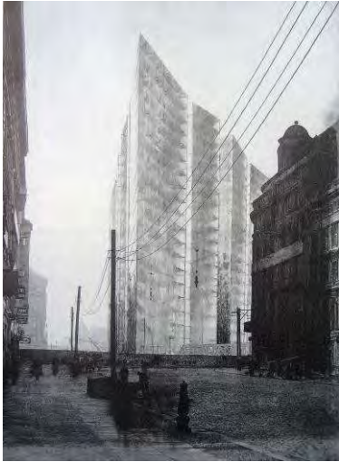
Fig. 1.3.8 Rascacielos para la Friedrichstrasse de Berlín en 1919, y rascacielos de vidrio 1922, de Mies van der Rohe. La estructura de acero interior permite descargar las fachadas de su función portante, transformándose éstas en vidrio. La intención es conseguir una mayor transparencia hacia el exterior a través de la desmaterialización de la estructura, la cual conduce a que en algunos dibujos, ni siquiera se intuya la posición de los pilares.
