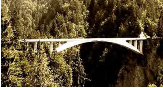
Fig. 1.2.14 Puente de Salginatobel, Suiza. Robert Maillart 1930. La forma del puente tiene una relación directa con el planteamiento resistente
