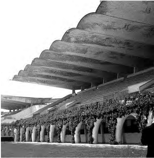
Fig. 1.6.1 Hipódromo de la Zarzuela. Colaboración de Eduardo Torroja en la configuración de la estructura de la gradería y la cubierta con el arquitecto Carlos Arniches, en 1935. En este caso la figura de Torroja ha predominado sobre la del arquitecto, al tener la estructura una presencia formal considerable.
