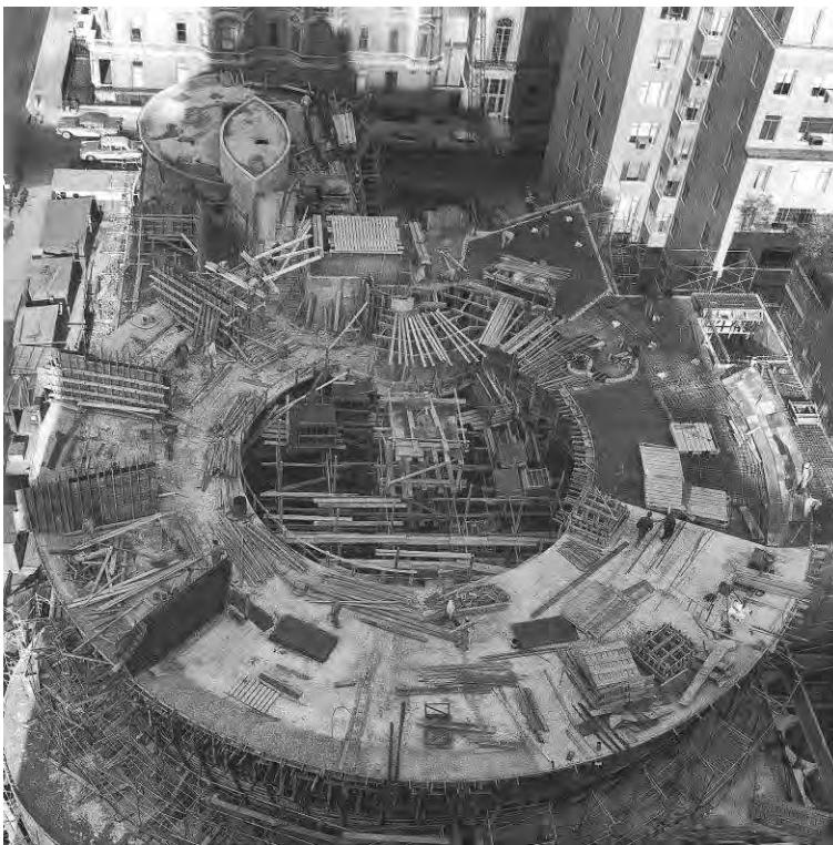
Fig. 3.9.3. El muro que forma el cilindro de la planta baja y primera nace de los pilares del sótano que delimitan la sala de actos. De este modo, el muro también tiene la función de una gran viga pared entre pilares, permitiendo la entrada de luz a la planta sótano a través de un patio inglés lateral. La intersección entre los pilares y el cilindro puede considerarse como una región “D” puesto que el gradiente de tensiones es muy alto alrededor del apoyo.
