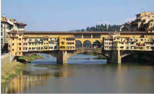
Fig. 1.2.10 Ponte Vecchio, Florencia, construido en 1345 por Tadeo Gaddi mediante elementos constructivos tradicionales, como las pilastras de piedra, los arcos de medio punto y muros, como si de un edificio se tratase.
