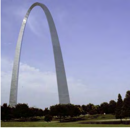
Fig. 1.2.1 Arco de San Luis. Eero Saarinen y Frank Severud, 1968. La estructura es el motivo en sí del edificio y no sirve de soporte para ningún otro elemento ni función.
