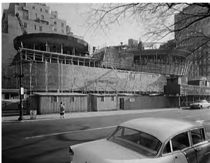
Fig. 3.9.9 Las fachadas de hormigón gunitado se fueron ejecutando a posteriori que los forjados. La necesidad de fijar el encofrado inclinado sobre el que se proyecta el hormigón, obligó a este desfase en el orden de ejecución de elementos.
