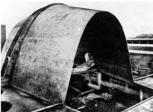
Fig. 3.1.13 Pabellón del hormigón, Exposición Nacional de Zurich 1939, donde la intención de Robert Maillart es la de expresar las posibilidades expresivas de este material, más allá de los entramados de pilares y vigas. La distancia entre soportes es de 12m y la altura de la parábola de 16m, lo que resuelve con una lámina de hormigón de 6cm de espesor.
