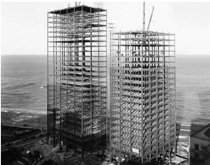
Fig. 1.6.3 Construcción de los edificios de apartamentos Lake Shore Drive en Chicago, Mies van der Rohe 1951, donde Kornacker aportó las pautas para definir una trama que permitiese combinar la posibilidad de construcción en altura con una retícula apropiada para la distribución de los apartamentos.
