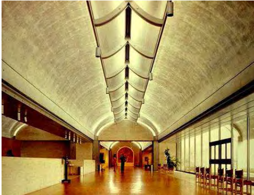
Fig. 1.3.13. El comportamiento laminar de las bóvedas del Museo Kimbell de Louis Kahn, 1972, posibilita la entrada de luz a través de los laterales y el centro.
