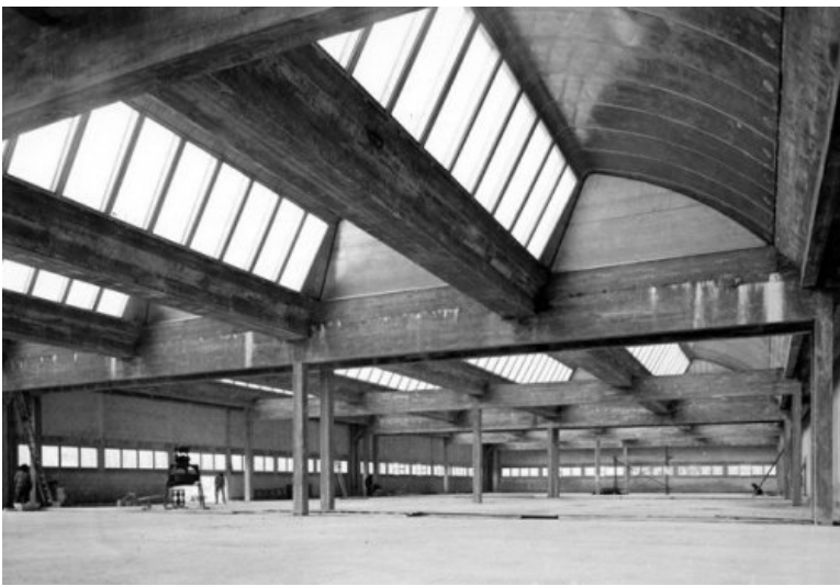
Fig. 1.6.5 Jean Prouvé, Shed Roof 1950. Las colaboraciones de Jean Prouvé con varios arquitectos de primera línea fueron múltiples (Robert Mallet-Stevens, Marcel Lods y Eugène Beaudouin entre otros) de manera directa o indirecta, otorgando a esos edificios un aspecto característico a través de su estructura.
