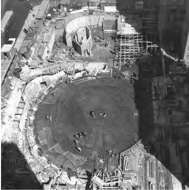
Fig. 3.9.1 Ejecución de la losa del techo del sótano, que finalmente se realizó plana y no en forma abovedada como había insinuado Wright en las versiones anteriores. La disposición radial de la armadura indica una lógica de aparente simetría radial de la estructura.
