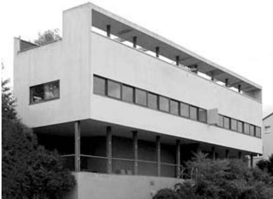
Fig. 1.1.6 Villas Weissenhof en Stuttgart. Le Corbusier 1927. Se manifiesta la clara separación entre estructura (retícula de pilares y losas planas) y el resto de elementos. En el caso de las distribuciones, la planta baja queda libre al liberar a los muros de su función portante. En cuanto a las fachadas, la manifestación de su función no estructural son los grandes ventanales rasgados.
