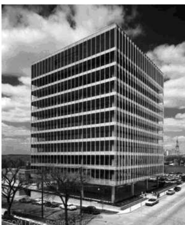
Fig. 1.2.8 Oficinas para la Warren Londres Petroleum en Chicago, SOM 1957. La estructura resulta ser la malla generadora del edificio, optimizada no sólo para su comportamiento estructural sino también para otorgarle una proporciones correctas que permitan un mejor aprovechamiento del espacio interior.
