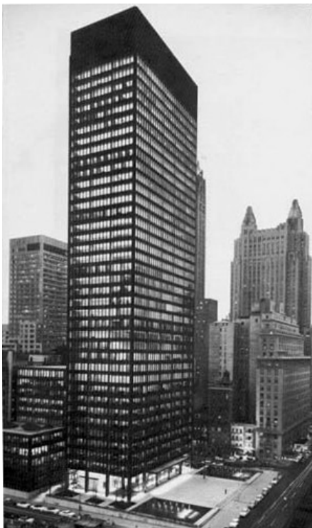
Fig. 1.3.7 Seagram Building en New York, Mies van der Rohe 1957. La estructura se dispone frente a un vacío de las mismas dimensiones del edificio. Está optimizada para su correcto funcionamiento resistente y sirve a la vez como referencia en distribuciones y resto de sistemas constructivos. Una superposición de órdenes: zócalo, planta baja, cuerpo y coronación ayuda a completar es esquema compositivo del conjunto.
