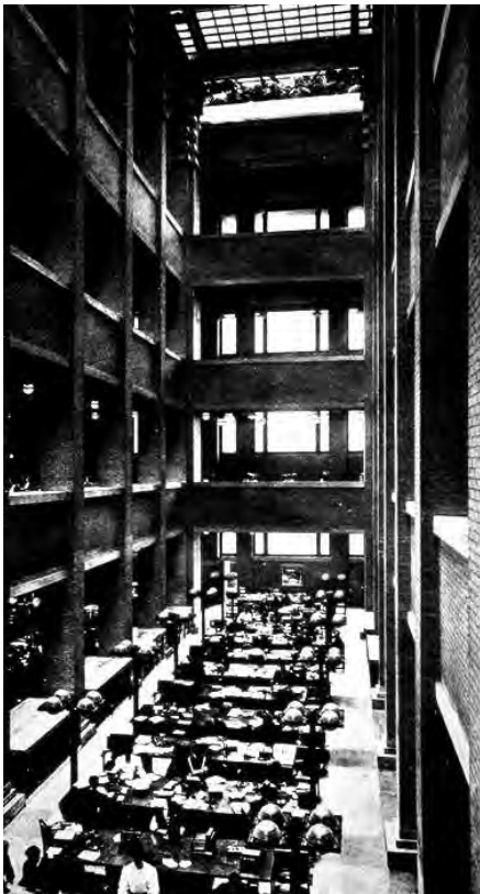
Fig. 1.5.3 Atrio interior del edificio Larkin. Frank Lloyd Wright, Buffalo 1903. En la huida hacia el voladizo, en edificios de mayor tamaño Wright siguió utilizando el entramado de acero durante un cierto tiempo. No obstante, en este caso, lo hizo permitiendo la entrada de luz a través de un gran atrio central
