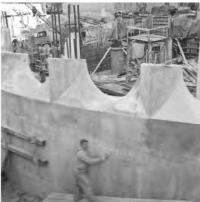
Fig. 3.9.12 El acabado final de los muros (planta sótano en la foto) y de las fachadas fue el de una superficie continua, acorde con el planteamiento unitario de Wright.
