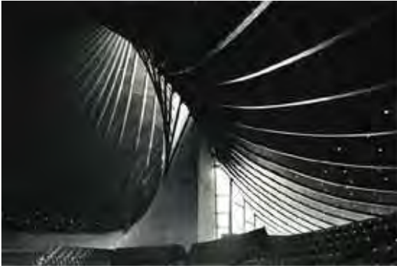
Fig. 1.3.15 Interior del Gimnasio Olímpico Yoyogi en Tokio, Kenzo Tange 1958. El espacio interior se consigue a través del planteamiento de una estructura singular formada por un sistema de catenarias principales y secundarias.
