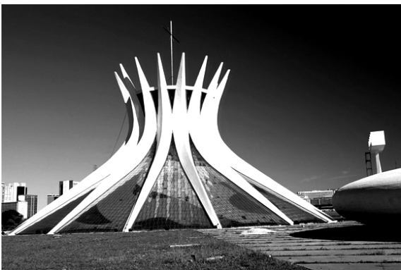
Fig. 1.3.18 Catedral de Brasília, 1970, Oscar Niemeyer. La estructura basada en una geometría a partir de secciones hiperbólicas se utiliza como la propia imagen del edificio.
