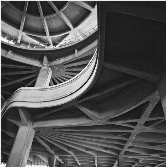
Fig. 1.1.5 Interior del edificio Fiat-Lingotto con estructura de hormigón. Mattè-Trucco, Turín, 1916-23. Posteriormente, en el caso del hormigón armado, el aspecto propio del material así como sus pautas de diseño, adoptan una nueva forma de expresión por sí mismas, al posibilitar la adaptación de sus elementos a cualquier forma preestablecida.
