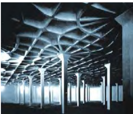
Fig. 1.2.4 Lanificio Gatti en Roma, de Pier Luigi Nervi, 1952. Aunque contenidas en el plano, las formas que adopta la estructura, basadas en la optimización de las trayectorias tensionales en el techo, determinan el carácter del espacio inferior.
