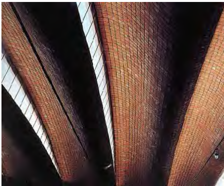
Fig. 1.2.3 Bóvedas gausas de Eladio Dieste en una nave en Montevideo, 1979. La forma de la estructura define el carácter del espacio interior, especialmente debido al matiz que adquiere la entrada de la luz a través de la misma.
