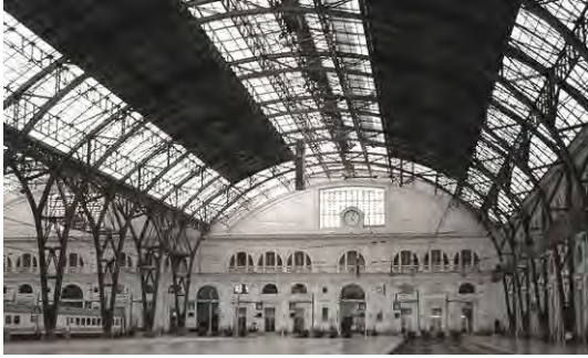
Fig. 1.1.4 Interior de la Estación de Francia, Barcelona, obra de los arquitectos Pedro Muguruza y Fernando Gallego Herrera y que se inauguró en 1929. A mediados del siglo XIX las nuevas estructuras de acero, con un lenguaje propio, deben convivir con los criterios arquitectónicos preexistentes.
