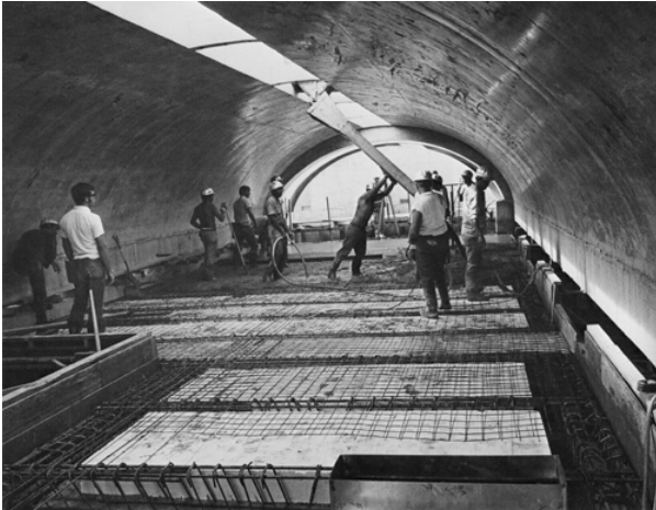
Fig. 1.6.4 Construcción del Museo Kimbell. Komendant ayudó a Kahn a proyectar el edificio en base a sus conocimientos sobre el comportamiento laminar y el pretensado, pero fundamentalmente a través de su particular sensibilidad del espacio.
