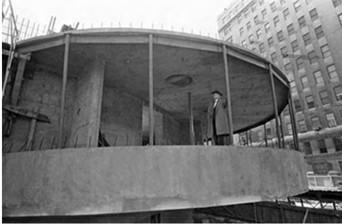
Fig. 3.9.7 El edificio monitor es, conceptualmente, una réplica a menor escala del edificio principal, donde las plantas en voladizo se sustentan en cinco pilares y el núcleo, en ambos casos con forma lenticular.
