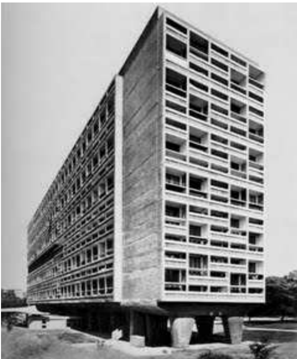
Fig. 1.6.6 En la Unité d'Habitation de Le Corbusier, la forma de los pilares y tablero de la planta baja que recogen el resto de la estructura, recuerdan en cierto modo a los planteamientos estructurales de Jean Prouvé sobre la canalización y lectura de los esfuerzos, aunque en este caso no colaborasen directamente.
