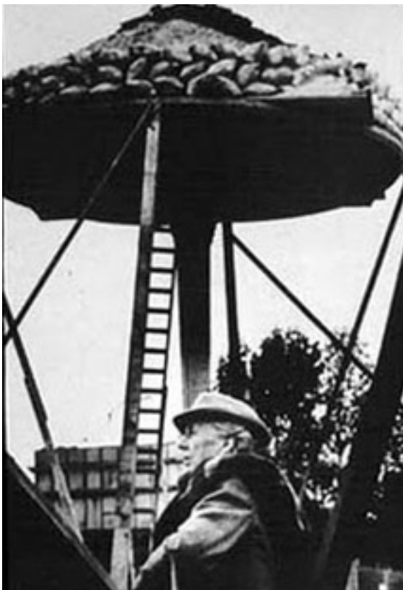
Fig. 1.2.19 Prueba de carga de una de las columnas dendriformes del edificio.
