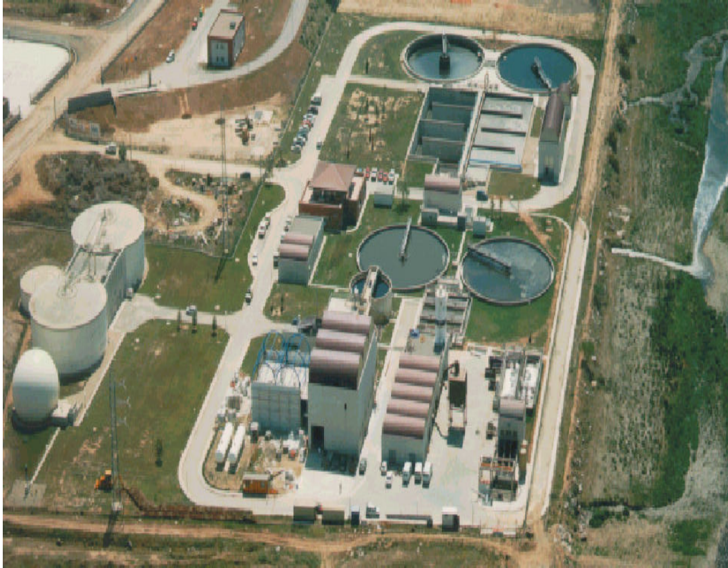
Figura 4-1 Vista aèria de l'actual EDAR de Granollers
