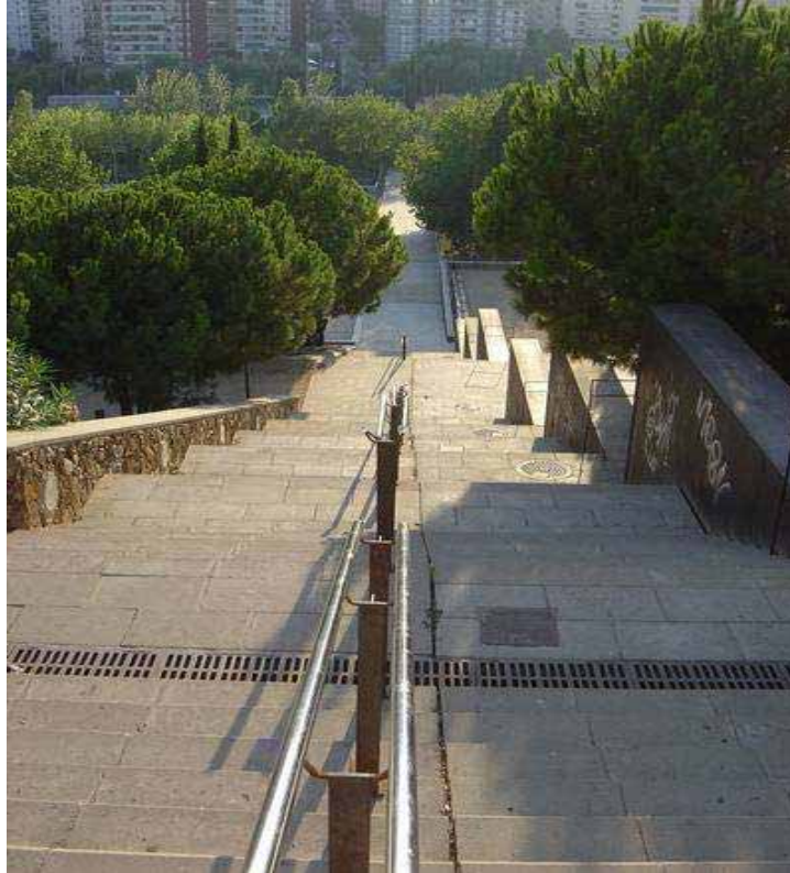
Foto 11: Vía principal y escaleras
