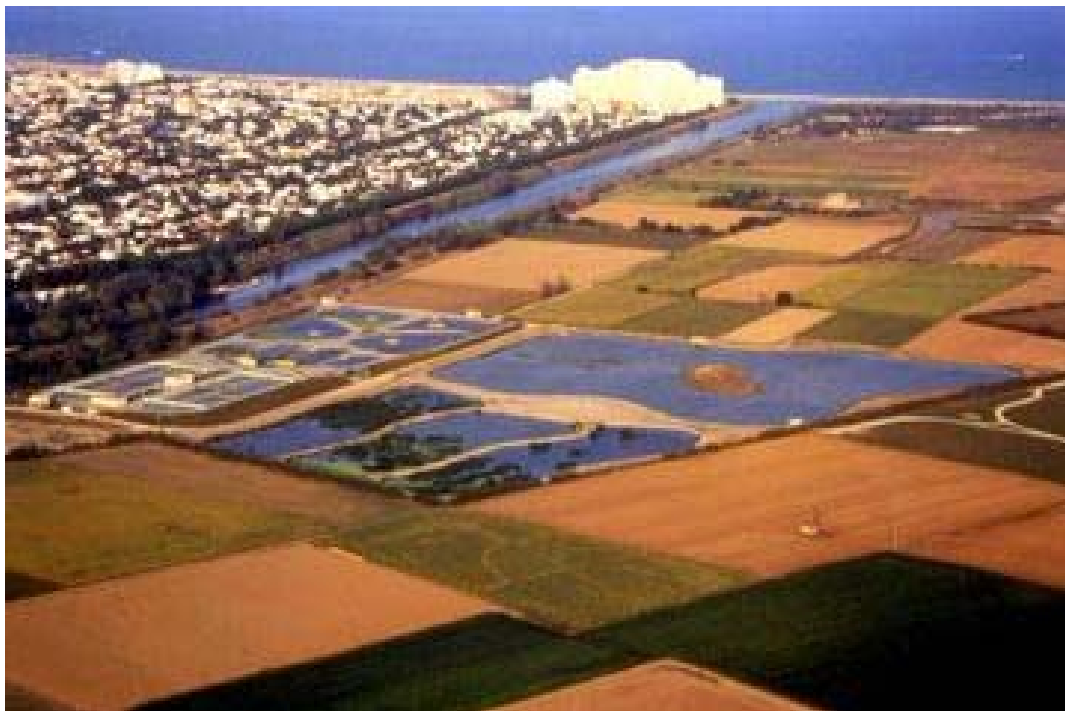
a) Vista aerea de la EDAR y el SAC de Empuriabrava.
