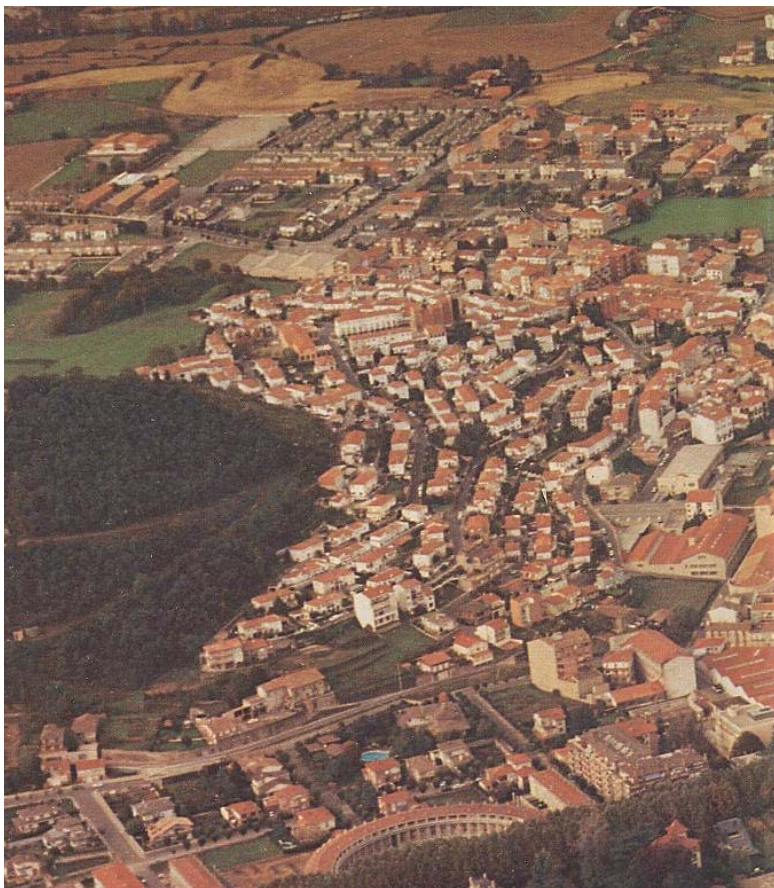
▲ Fotografia aèrea del conjunt. El projecte se situa en la falda de la muntanya de Sant Pere Màrtir, amb un fort desnivell. S'aprecia en la imatge la importància de l'edifici religiós i dels habitatges plurifamiliars que formalitzen la plaça principal de la intervenció.
