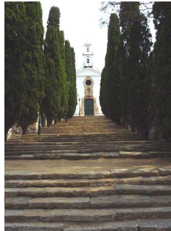
▲ Accés a l'església. La principal via peatonal d'accés a l'església de la Mare de Déu de l'Esperança queda magnificada per l'escalinata i la composició dels xipressos a banda i banda de les escales.
