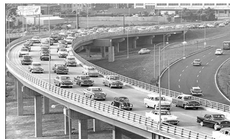
1,39 1,40 1,41 Construcción de la Arteria Central de Boston, J Fitzgerald Expressway, 1954.
