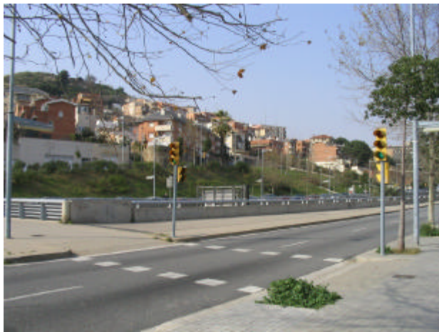
5.06, 5.07 y 5.08. La presencia de la vía rápida se convierte en parte integrante e integrada del paisaje urbano y el peatón recupera sus espacios de cruce y de permanencia. Ronda de Dalt
