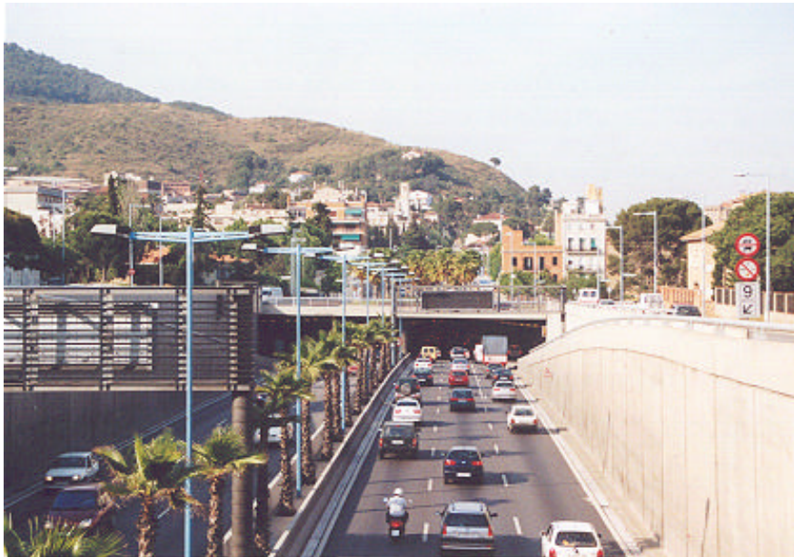
5.40. Las vías segregadas rápidas tienen una relación visual y funcional mucho más directa con el espacio urbano. La solución formal de la sección en alzada permite su integración de manera activa en la ciudad sin que se produzcan los efectos característicos de polución acústica e intrusión visual.
