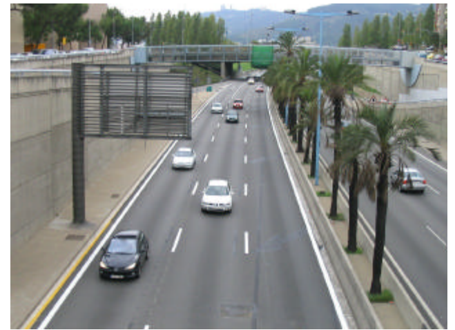
4.13 y 4.14. En la nueva sección, la estética convencional de una vía rápida es sustituida por otra más urbana donde los protectores laterales son reemplazados por una vereda y donde el separador central incluye la plantación de palmeras y la inserción de luminarias a pesar de su ancho mínimo
