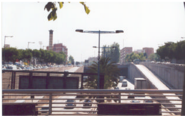
4.15, 4.16. y 4.17 Las imágenes muestran las pendientes de las rampas con mayor inclinación que las convencionales, obligando a los automovilistas a aceleraciones o desaceleraciones poco frecuentes pero perfectamente posibles con lo que se gana en menores desarrollo en planta.
