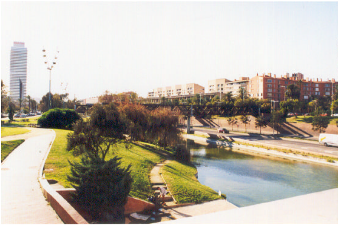
4.23. Las diferencias entre las rasantes de las vías segregadas y la vía urbana, salvadas por un nuevo parque urbano. Villa Olímpica
