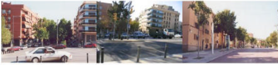
0.169. Continuidad entre la Rambla de Pablo Iglesias y la Rambla de las Clafarinas
