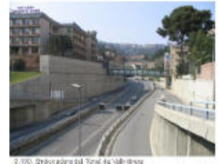
2.100. Ordenación del Túnel de Valdelella
