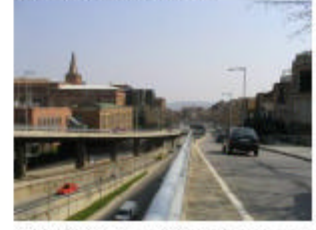
2.107. Ordenación de la zona urbana producida por la Vía Augusta entre desde la Plaza Dalí.
