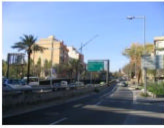
0.170. Esta imagen muestra el punto donde la vía segregada que viene a nivel de superficie (desde el Nudo de la Trinidad) trata su desnivel con respecto con el intento de acercarse a la ciudad existente.
