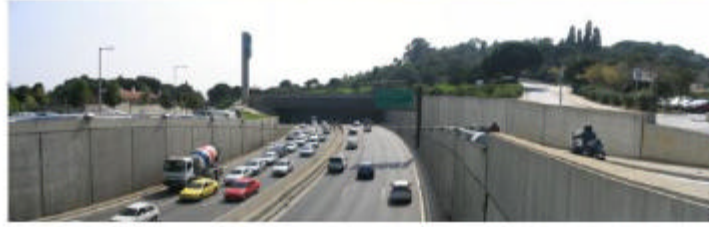
3.123 y 3.124. Restauración del Parque de P. Ovejas por entre de las vías segregadas. Entre nueva vía urbana desde el parque hasta la salida en la que la Avenida de San Juan ocupa un lugar privilegiado. Aquí, visión urbana hacia el Sur, la entrada a las vías segregadas y la salida se produce inmediatamente antes de éste.
