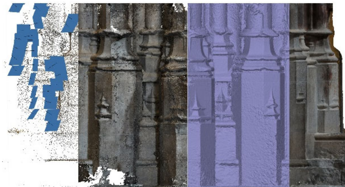
Figura 1: Ejemplo de los procesos fotogramétricos realizados para la obtención de un modelo sobre una basa de pilastra.
