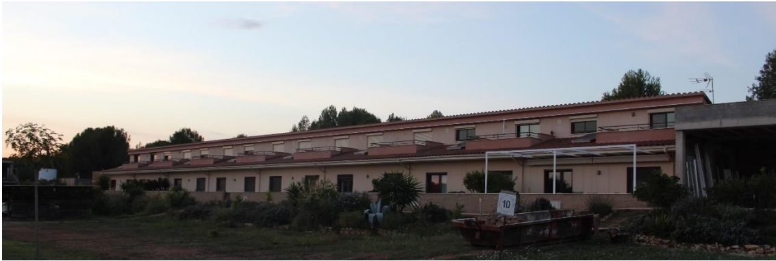
Figura 11: Vista frontal dels habitatges a La Muralleta. Cases de la 2 a la 8. Font: Pi (2021).
