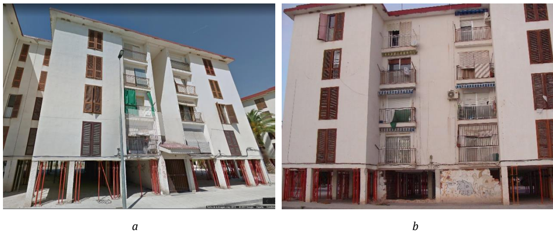
Figura 5-1: Imágenes del edificio San Fernando (Lorca). Vistas a) frontal, b) posterior (fuente: Google Maps)
