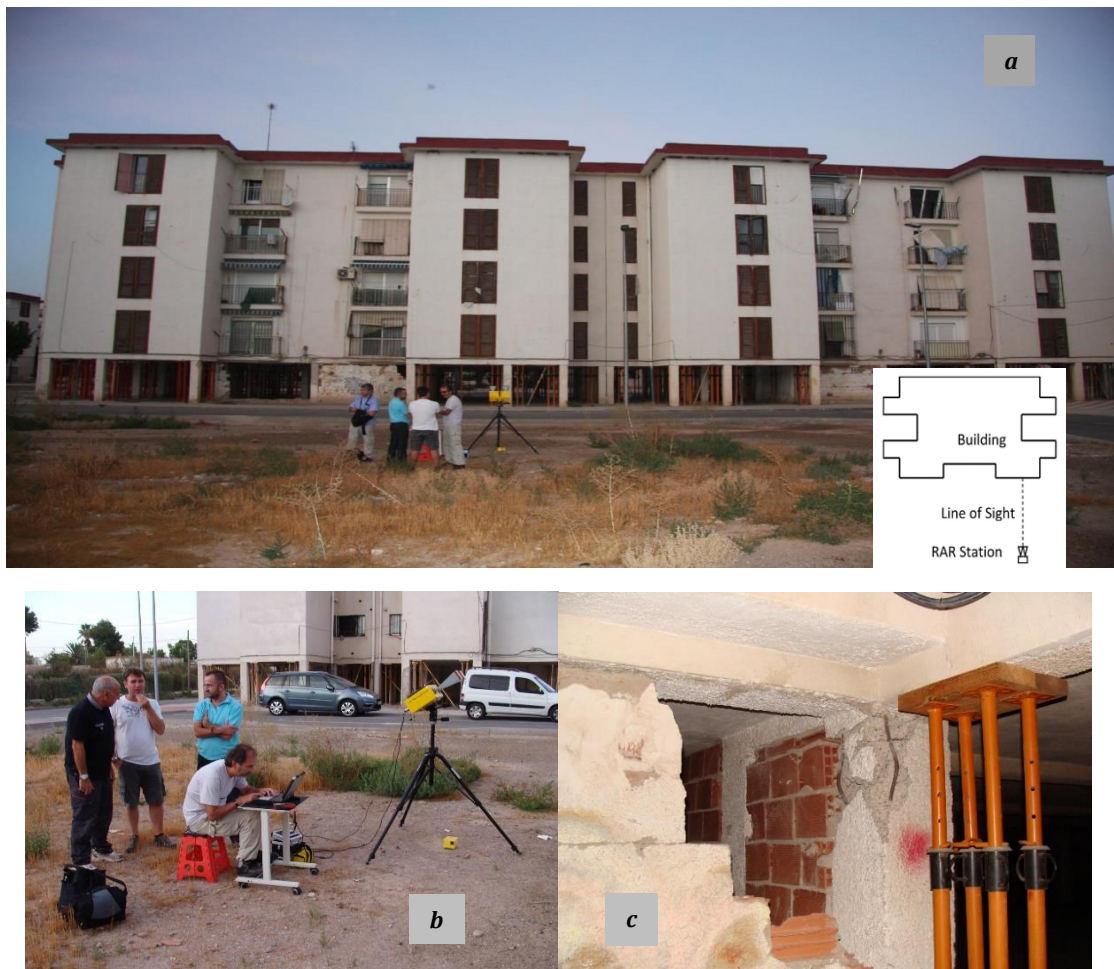
Figura 4-2: Monitoreo RAR del edificio San Fernando. a) Vista del edificio y orientación del equipo; b) Equipo técnico y c) Detalle de daños en las columnas de la planta inferior
