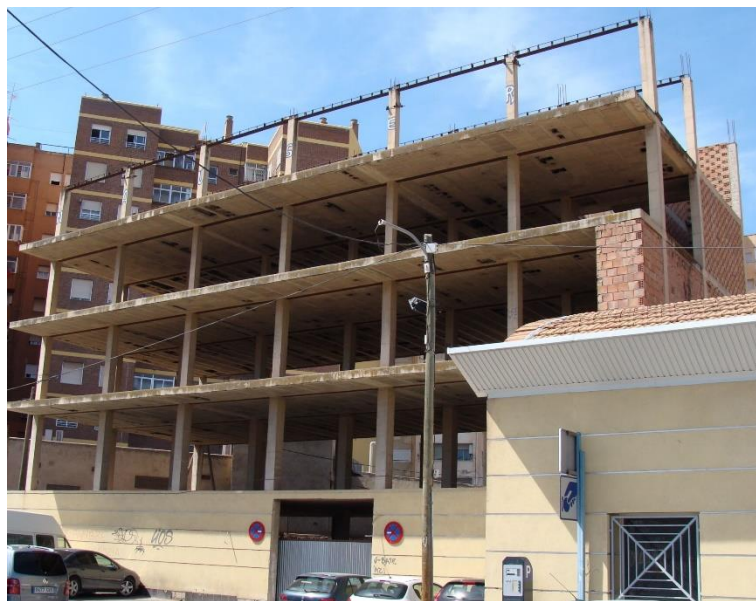
Figura 6-17: Edificio inacabado, sin cerramientos y exento de daño tras el sismo de Lorca de mayo de 2011. El edificio comparte dimensiones, tipología y detalles estructurales con el edificio de la Viña
