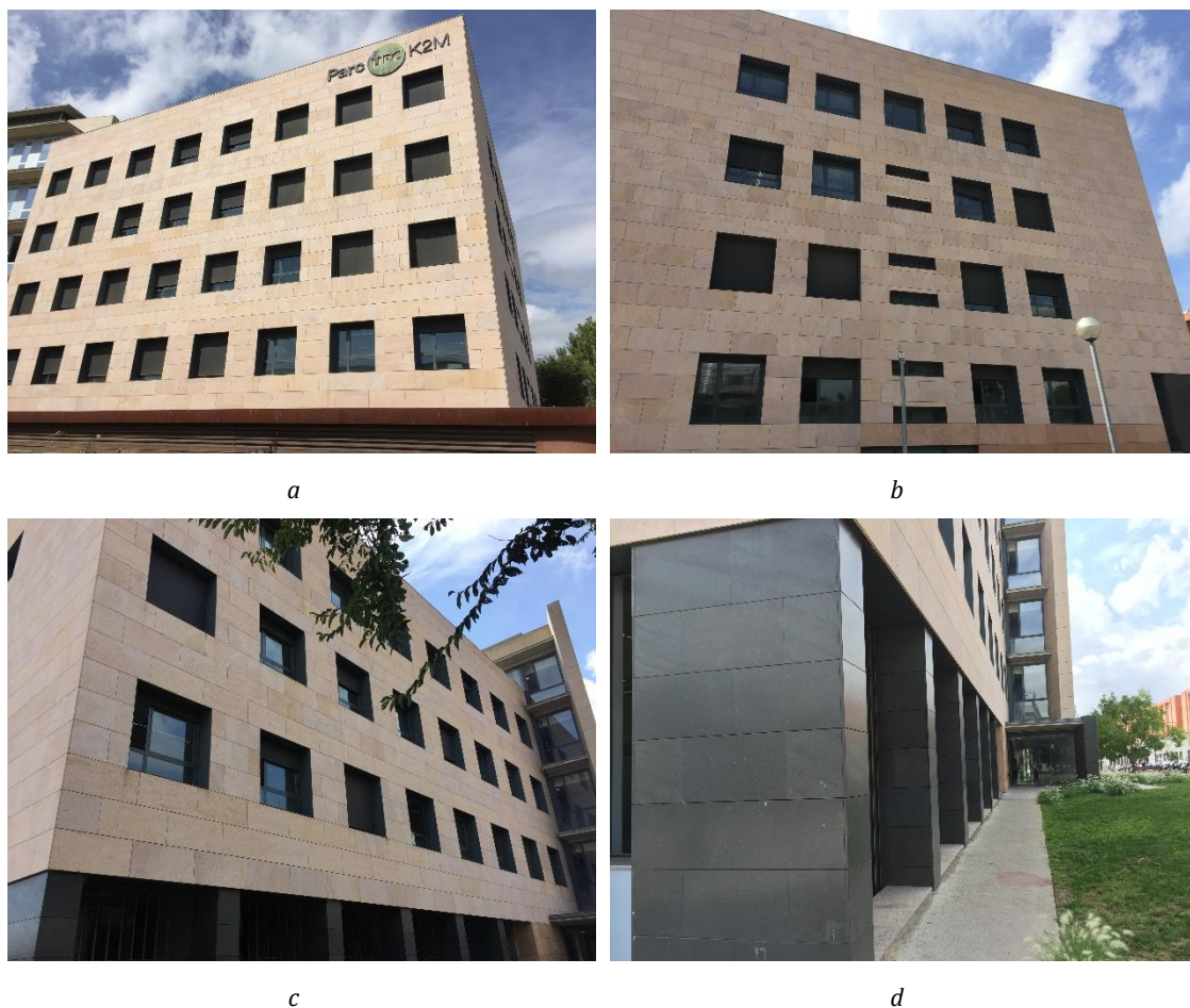
Figura 5-3: Imágenes del edificio Omega (Barcelona). Vistas a) frontal, b) lateral, c) posterior, d) acceso
