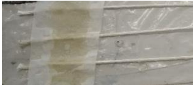
Figura 3. 2 Aplicació de 5cm de FRP de fibra de vidre.
