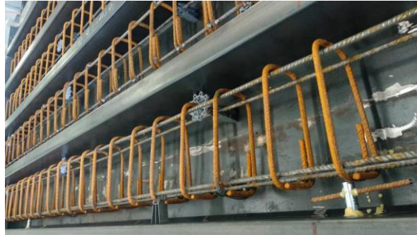
Figura 5. 2. Armadures de les bigues
