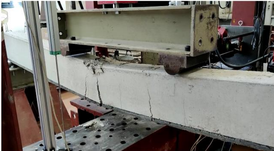
Figura 5. 24. Fissuració biga PESHE 1.
