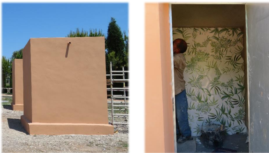
Figura 21. Construcción de los demostradores en el interior del campus de la Universitat Jaume I.
