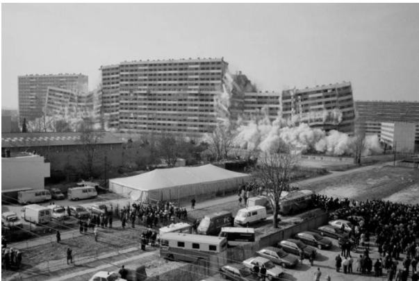
Fig. 61 - Demolición del Barre Debussy en la Cité des 4000 , 1986
