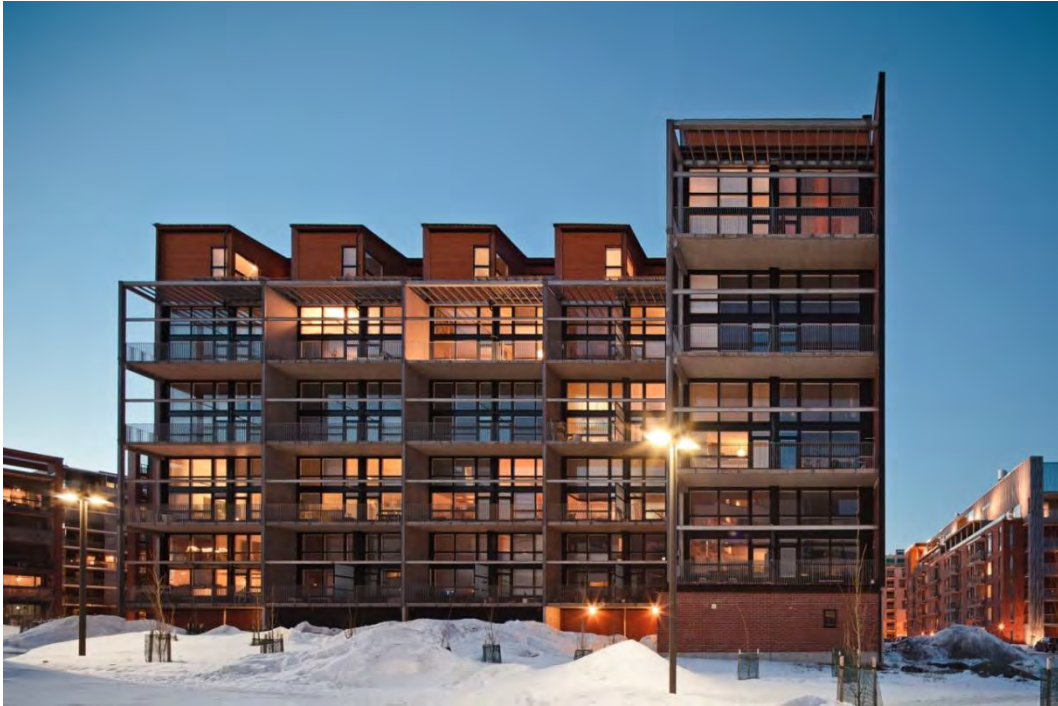
Fig. 43 - Fachada sur de Tila, 2011
