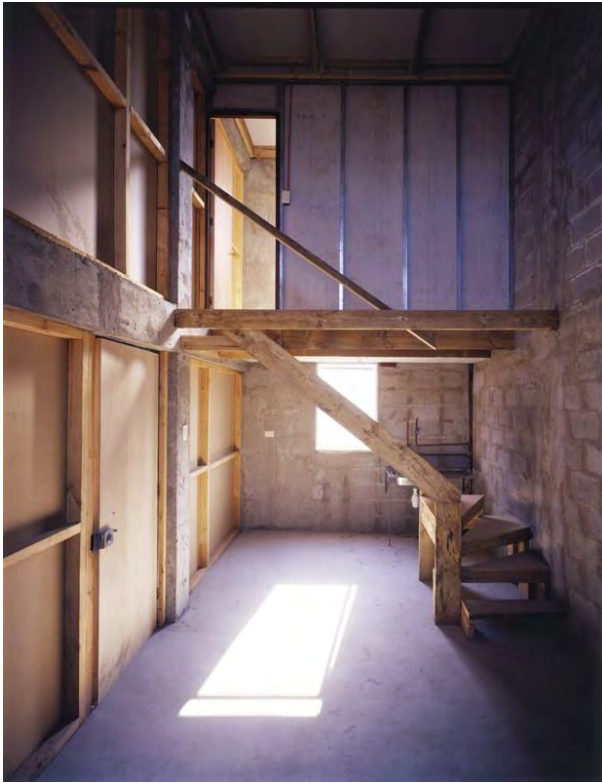
Fig. 81 - Espacio habitable inicial de 25 m 2 del apartamento dúplex con equipamiento básico según normativa, 2004
