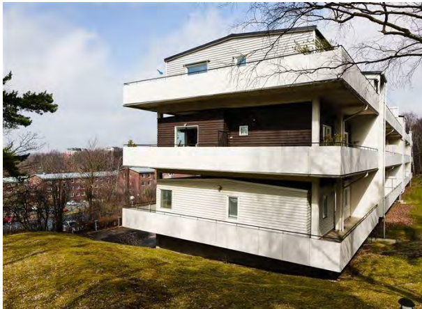
Fig. 15 - Vista lateral del proyecto de viviendas Kallebäck, realizado en 1960 por Erik Friberger
