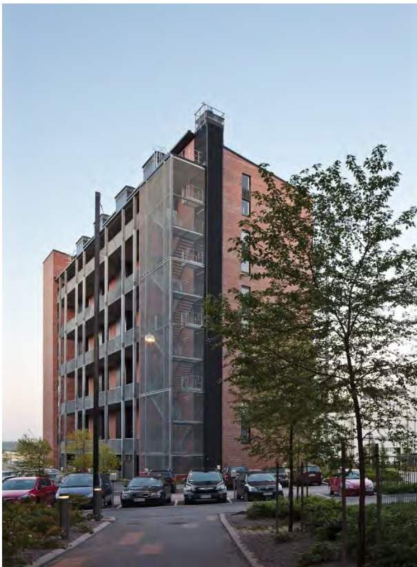
Fig. 44 - Fachada norte de Tila, 2011
