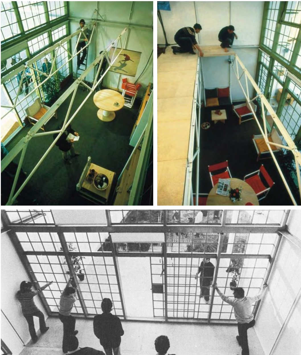
Fig. 19 - Arriba, proceso de autoconstrucción del piso superior mediante el ensamblaje de vigas metálicas a la estructura portante y colocación de paneles de madera prefabricados a modo de pavimento, 1978. Abajo, habitantes concebidos como agentes proactivos, capaces de transformar la vivienda (aumentar o disminuir) mediante la envolvente acristalada móvil
