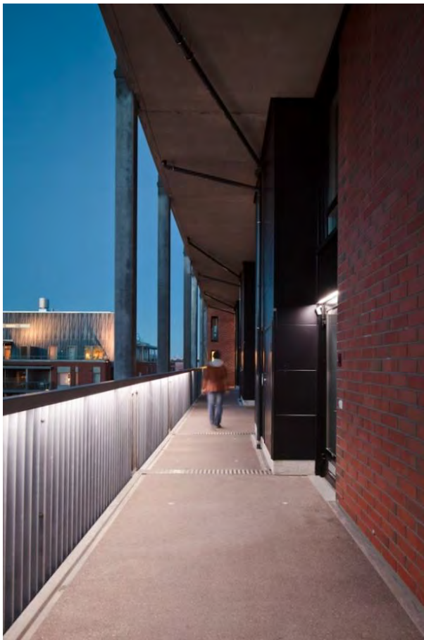
Fig. 52 - Corredor exterior de acceso con los núcleos de instalaciones verticales, 2011
