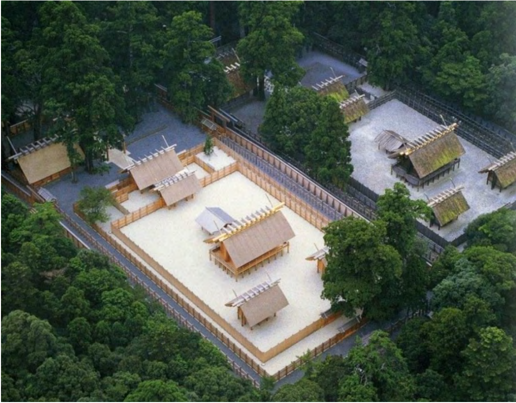
Fig. 14 - Reconstrucción del templo de Naikū junto al anterior antes de ser demolido
