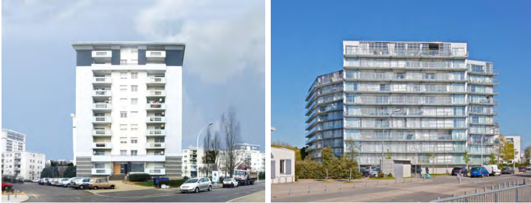
Fig. 49 - Proceso de transformación resiliente de la torre, 2012-2016
