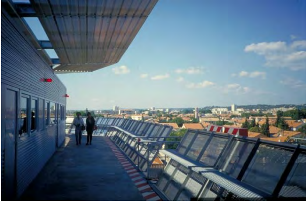
Fig. 68 - Vista de la cara noroeste de Nemausus, 1987. Corredor de acceso a las viviendas
