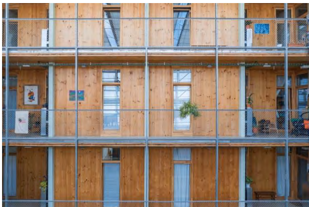
Fig. 172 - Apropiación de los corredores comunes y de los vestíbulos de acceso a las viviendas, 2019
