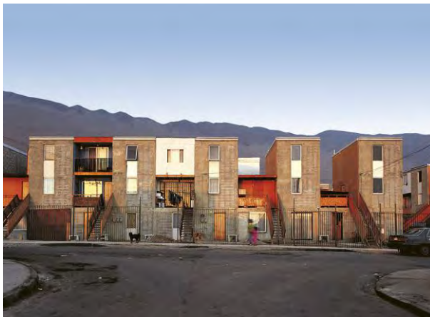
Fig. 76 - Transformación y apropiación de los slack spaces de las viviendas, 2006
