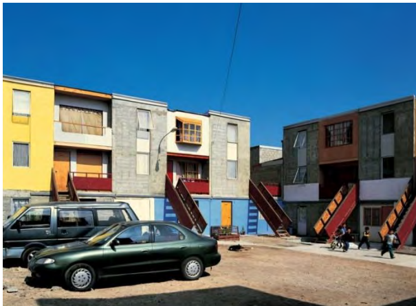
Fig. 79 - Transformación y apropiación de los slack spaces de las viviendas y del freespace exterior comunitario, 2006
