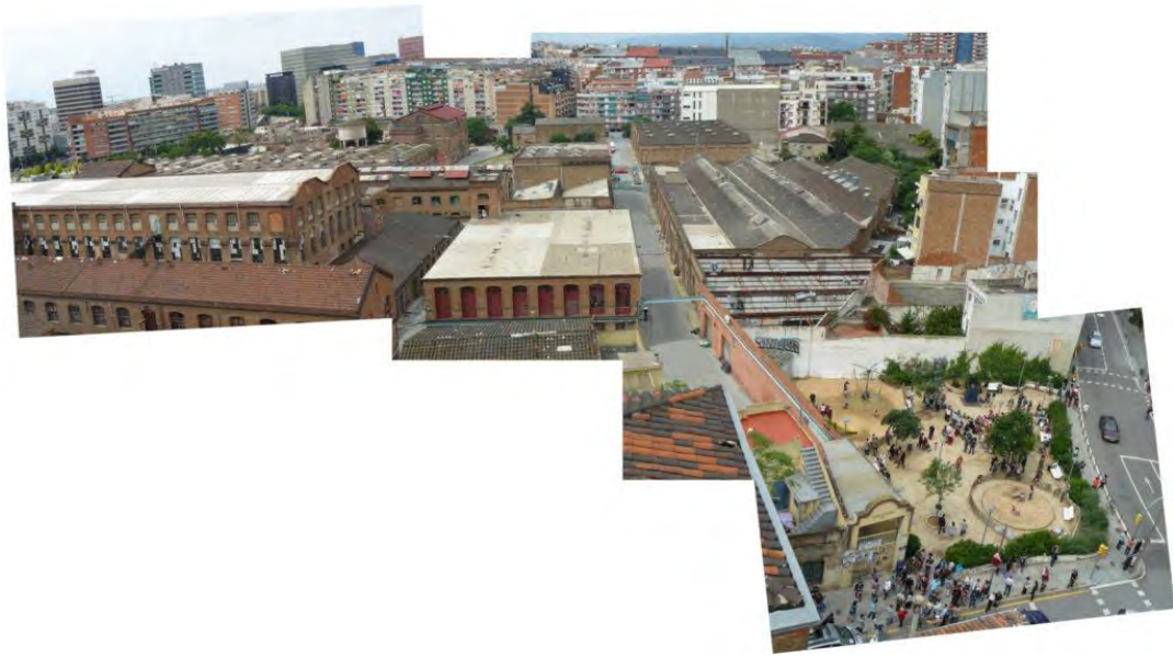
Fig. 117 - Vista aérea de la puerta acceso al recinto de Can Batlló el 11 de junio de 2011
