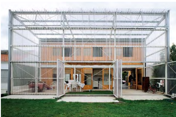
Fig. 5 - Casa Latapie, 1993. Freespace intermedio realizado con un sistema constructivo de invernadero agrícola. Espacio extra que interrelaciona el entorno exterior y el interior de la vivienda
