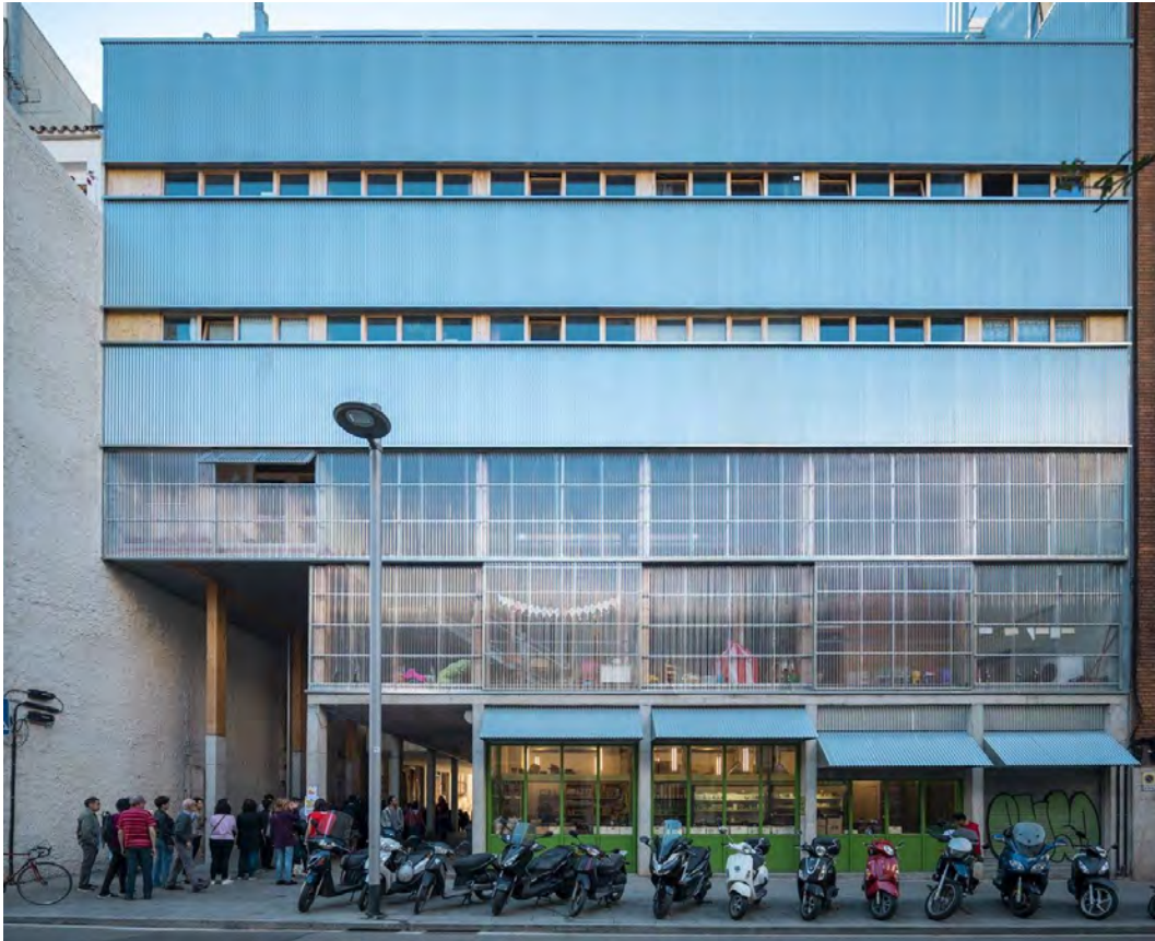
Fig. 143 - Fachada norte de La Borda en 2019. Vista del soportal de acceso
