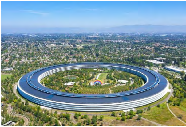
Fig. 6 - Megaestructura tecnológica. Apple Park Campus (Nueva sede para Apple) en Silicon Valley. Proyecto en forma de panóptico de Foster + Partners, 2017
