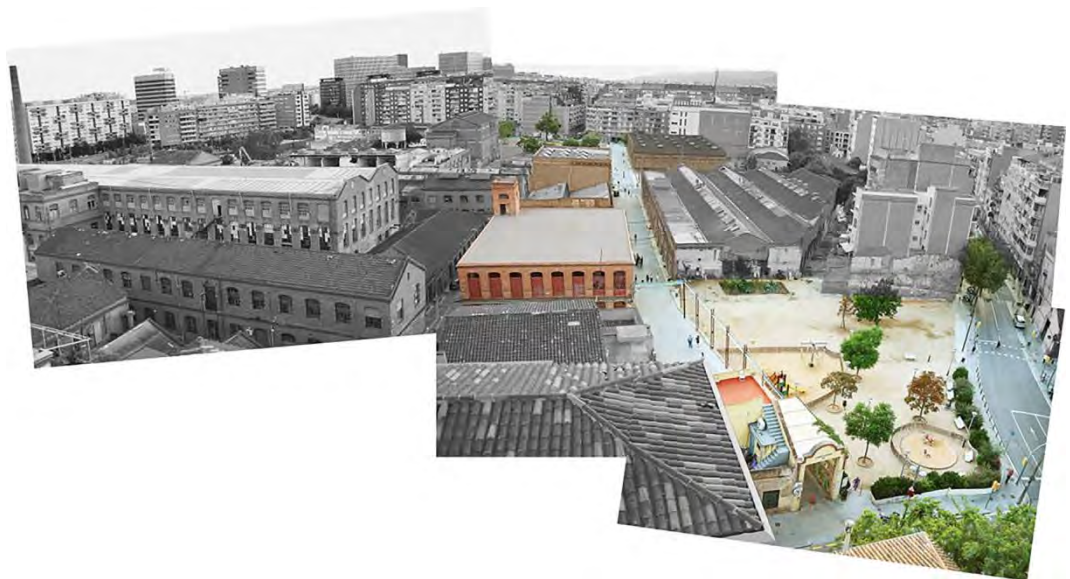
Fig. 118 - Vista aérea con la tercera fase ejecutada, 2013
