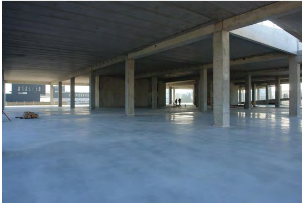
Fig. 22 - Estructura principal de hormigón sobredimensionada. Fase de construcción de la Escuela
