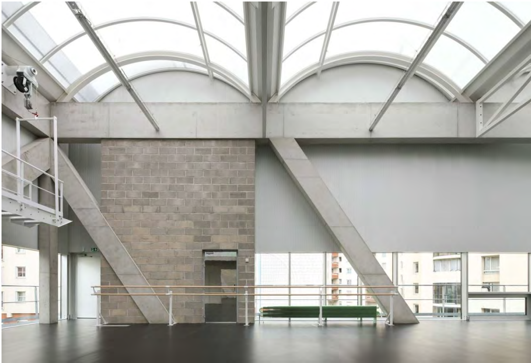
Fig. 217 - Freespace de la planta tercera. Confrontación del muro cortafuegos con el sistema portante triangular
