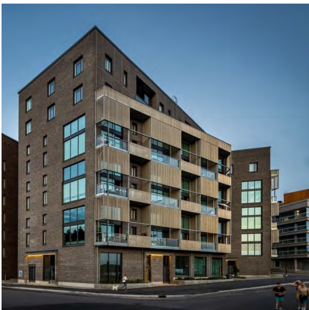
Fig. 77 - Fachada noroeste de Harkko, 2019
