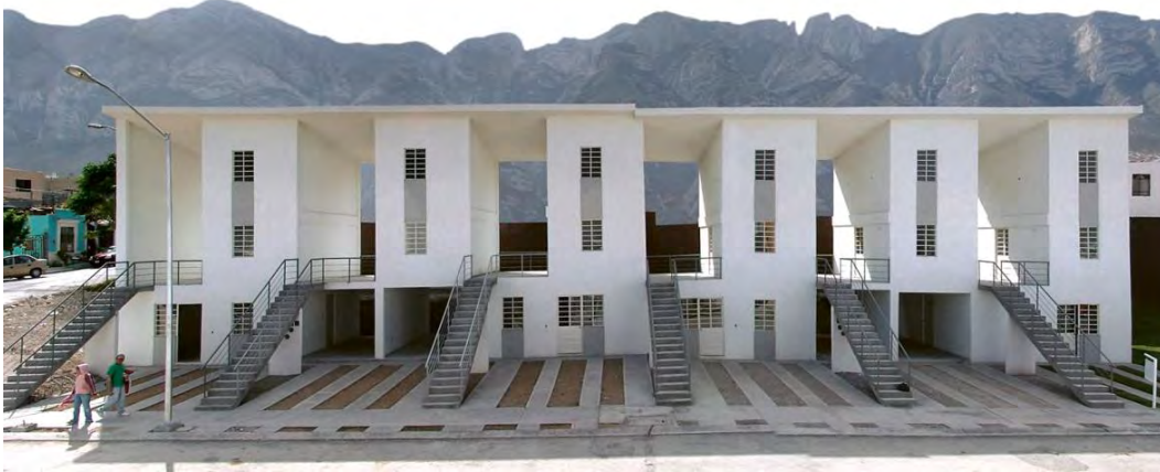
Fig. 97 - Viviendas Las Anacuas. Casas en planta baja y apartamentos dúplex en planta primera con slack space , 2010
