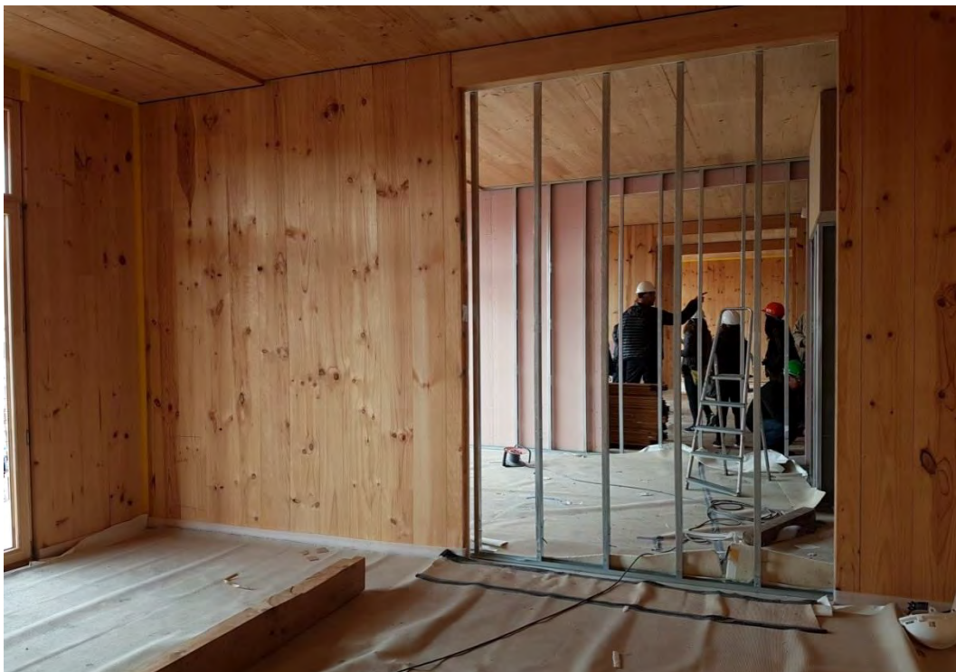
Fig. 155 - Proceso de cerramiento de las aberturas de los slack spaces para la formación de los distintos tipos de vivienda, 2017
