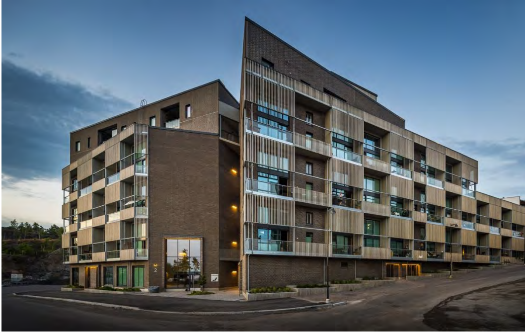
Fig. 75 - Fachada suroeste de Harkko, 2019
