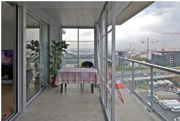
Fig. 46 - Transformación de una vivienda a través de su ampliación con freespace : jardín de invierno y balcón
