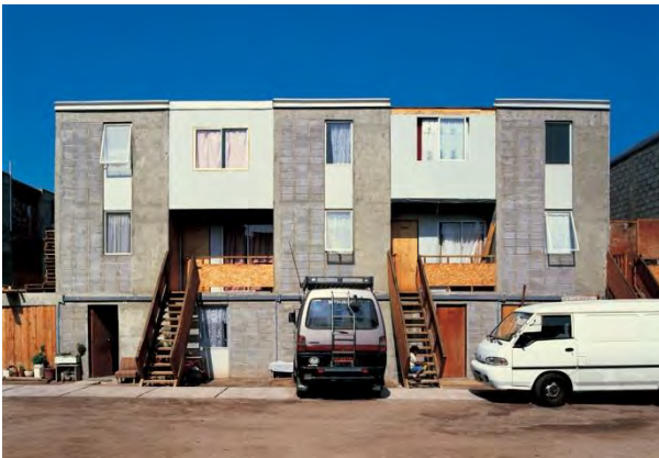
Fig. 87 - Viviendas de 72 m 2 de la Quinta Monroy, 2006
