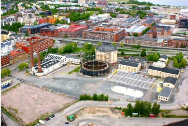
Fig. 39 - Complejo de Suvilahti. Freespace de la Energy field sin actividad. Tiene un uso pasivo de área de acceso y espacio urbano
