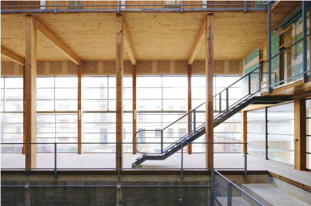
Fig. 160 - Freespace en doble altura de la planta primera. Pendiente del acabado interior de los tabiques por parte de la comunidad, 2018
