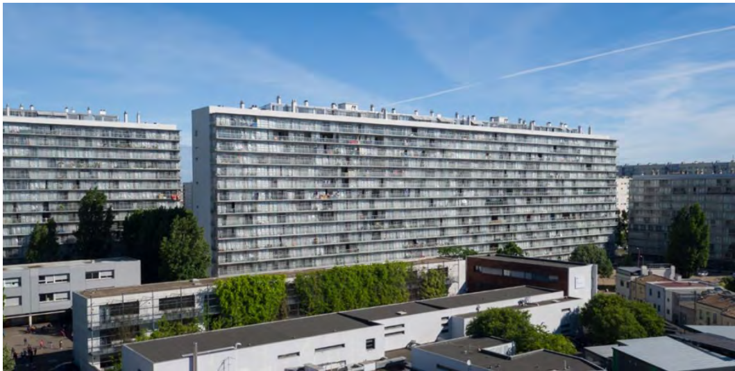
Fig. 52 – Arriba, edificios G, H e I existentes, 2013. Abajo, transformación resiliente de 530 viviendas, 2017
