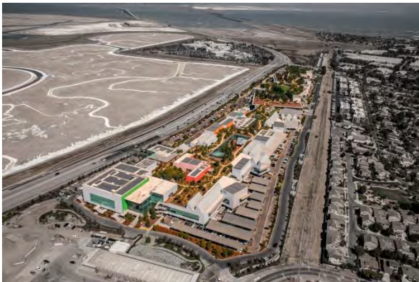
Fig. 7 - Megaestructura tecnológica. Campus de oficinas para Facebook (MPK 20 y 21) en Silicon Valley. Proyecto de Gehry Partners, 2018
