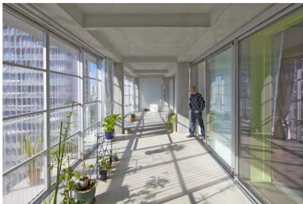
Fig. 58 - Transformación de una vivienda del edificio G a través de su ampliación con freespace : jardín de invierno y balcón, 2015
