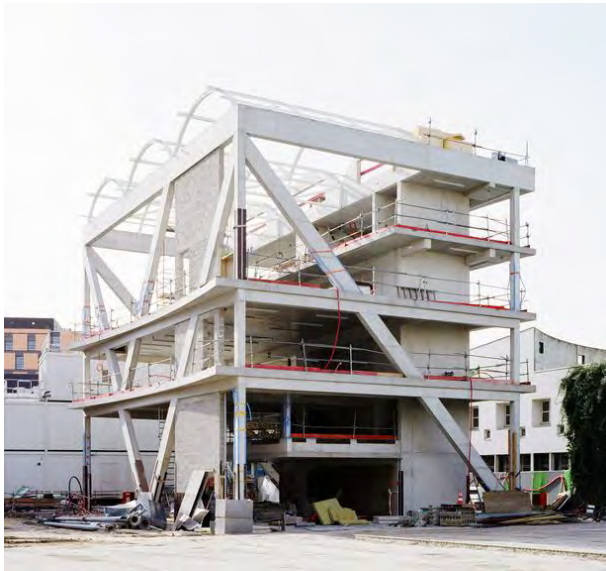
Fig. 213 - Esqueleto estructural del Centro Wangari Maathai, 2013
