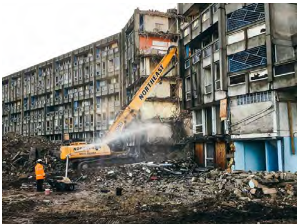
Fig. 64 - Proceso de demolición del bloque occidental de Robin Hood Gardens, 2017
