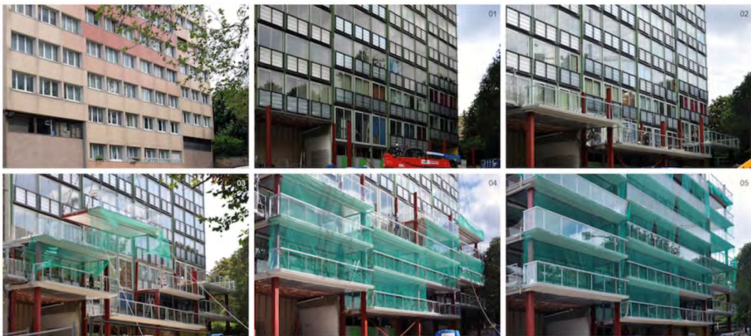
Fig. 45 - Proceso de la ampliación por fases mediante módulos prefabricados, 2010-2011
