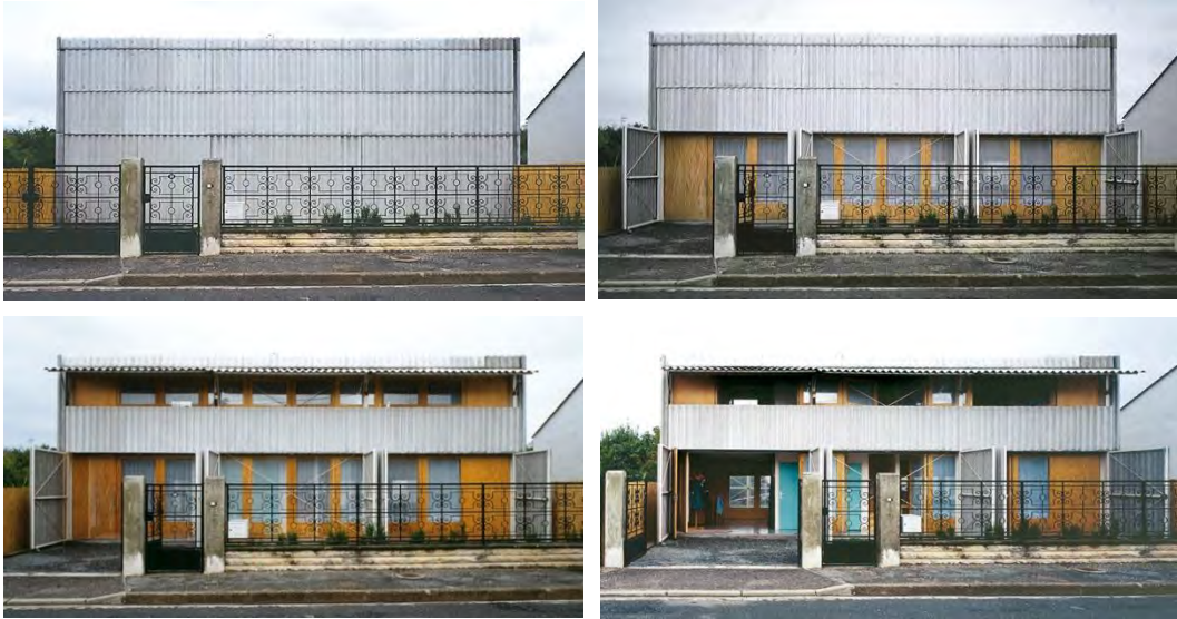
Fig. 6 - Proceso evolutivo de la vivienda. Accionamiento manual de los paneles móviles de la fachada oeste para adaptar el grado de porosidad del espacio según las necesidades de sus habitantes
