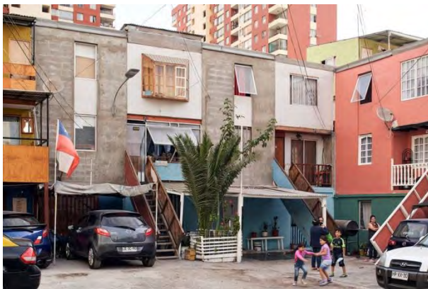
Fig. 80 - Proceso de evolución de las viviendas mediante slack space y del freespace exterior comunitario, 2020
