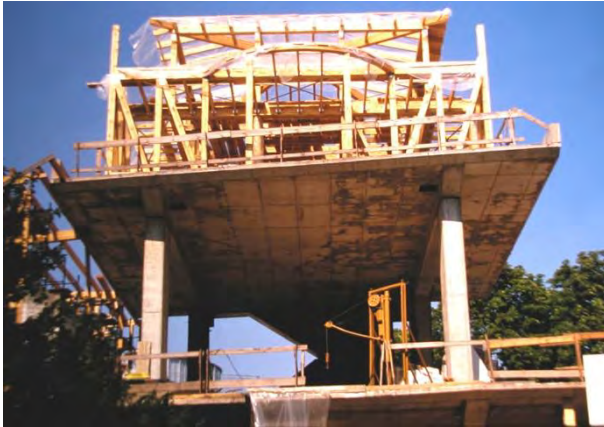
Fig. 23 - Proceso de construcción de una de las viviendas con una subestructura ligera de madera separada de su estructura de soporte, 1989-91
