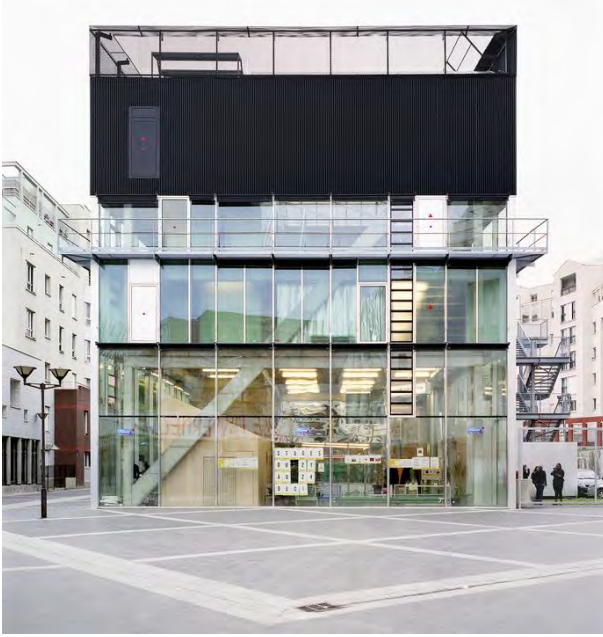
Fig. 214 - Fachada principal del Centro, 2015
