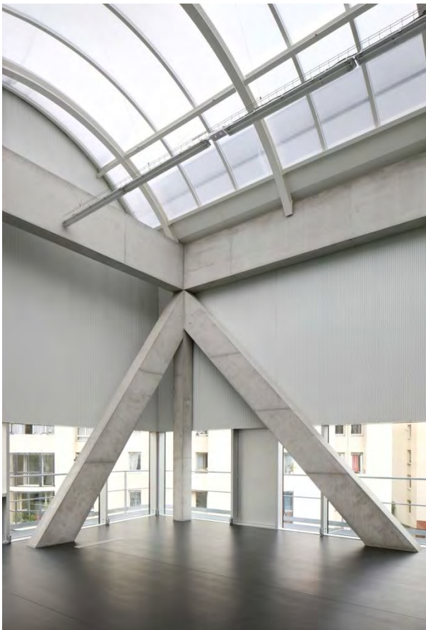
Fig. 218 - Inteligibilidad de elementos del freespace de la planta tercera. Articulación entre las vigas, el pilar y el sistema portante triangular
