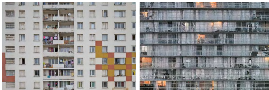
Fig. 53 - Transformación de la fachada del edificio H
