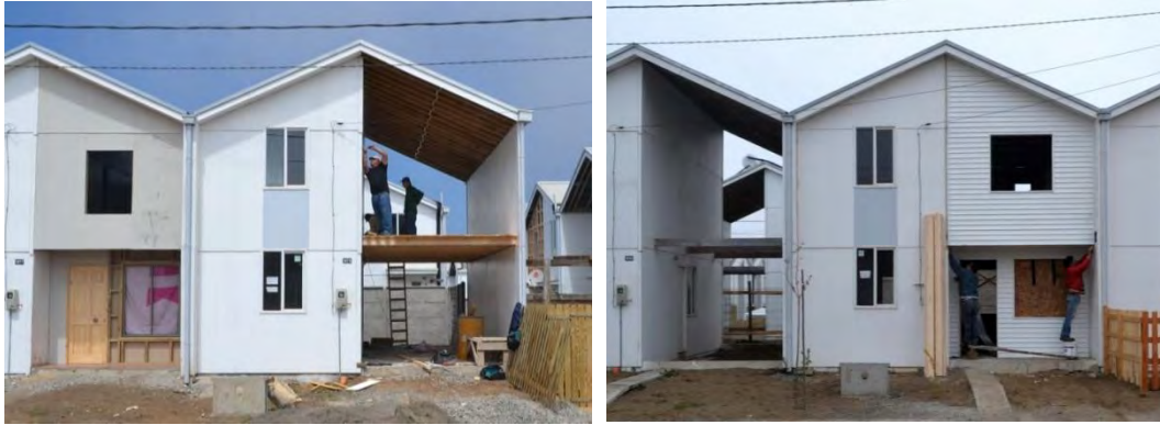
Fig. 108 - Proceso de autoconstrucción en el slack space , 2013
