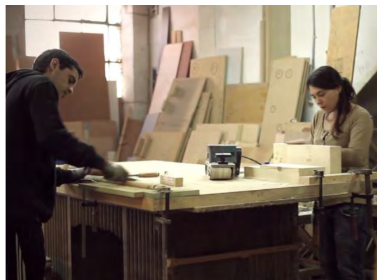
Fig. 104 - Jornadas de trabajo colectivo y voluntario. Proceso de autoconstrucción en el Bloc Onze de Can Batlló, 2011-2013
