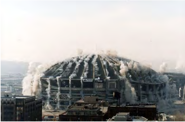
Fig. 60 - Demolición del estadio Kingdome en Seattle, 2000
