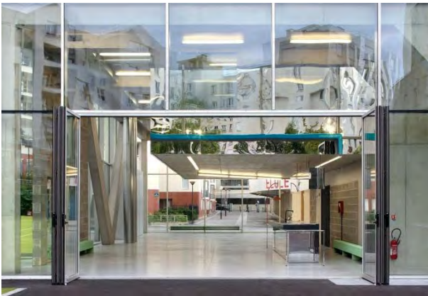
Fig. 215 - Continuidad espacial del freespace de la planta baja con los vacíos generados en el solar ( freespaces exteriores) mediante puertas correderas plegables en el cerramiento acristalado posterior
