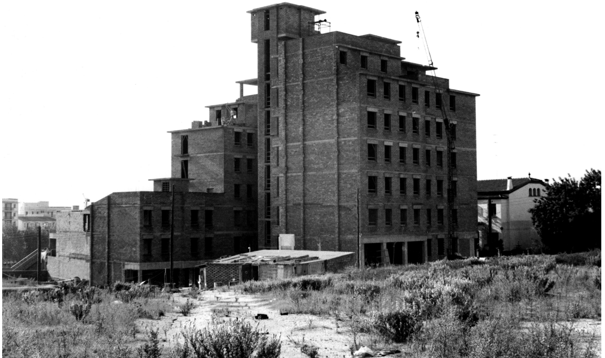
Construcció del bloc de pisos de la Cooperativa Laye al barri de Rocafonda, Mataró (1969), de J. M. Rovira [Fotografia]. Arxius personals de Josep Maria Rovira.
