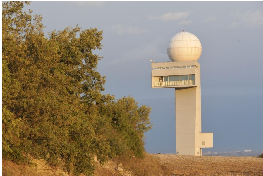
Figura 1. Radar meteorològic Doppler de banda C del Servei Meteorològic de Catalunya ubicat a La Panadella [Font: pàgina web de l' Ajuntament de Montmaneu ]
