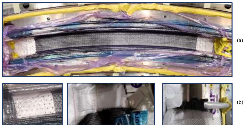
Fig. 5-23: Montaje de consumibles para la fabricación de la cuaderna en: (a) detalle de la etapa de llenado y (c) detalle de los consumibles empleados.
