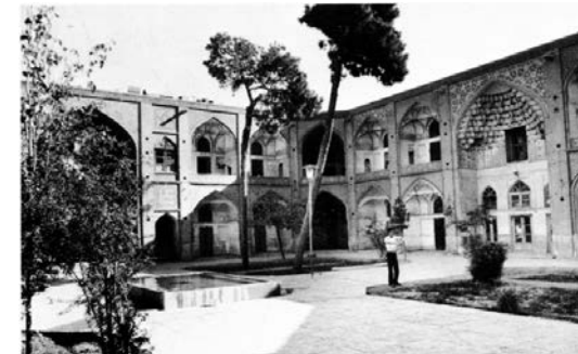
Fig. 54. Madrasseh Nimavard. Source: Der Bazar von Esfahan, Heinz Gaube and Eugen Wirth, 1978.
