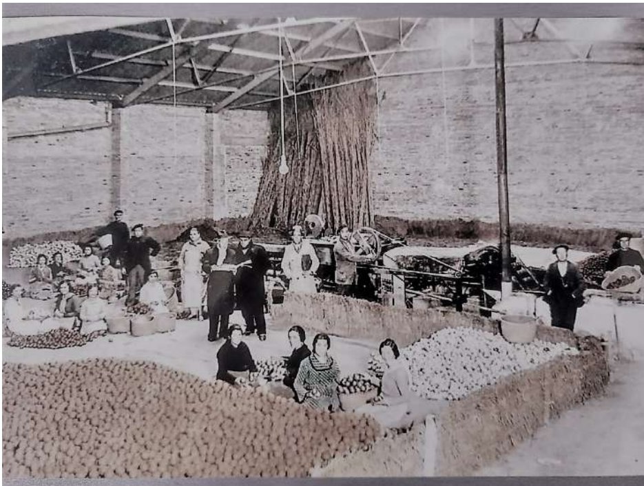
Fotografía 1: Antiguo almacén de naranjas de Castellón, años 20-30. Fondo documental: Sucine Aplicaciones de la Imagen, S.L.
