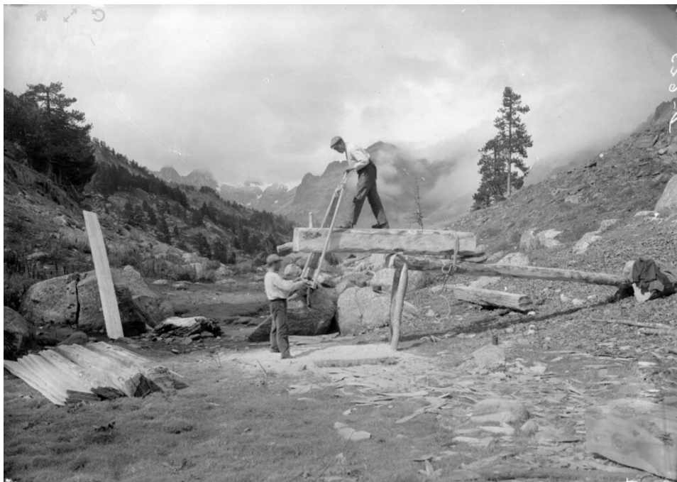
Fig. 401: Serra de pollina al Pirineu durant la construcció del refugi de la Renclusa, vers 1913 (Fotografia de Juli Soler i Santaló, Arxiu fotogràfic del Centre Excursionista de Catalunya, SOLER_D_0623, foto https://mdc.csuc.cat/digital/collection/afceccf/id/8208/rec/13 [09/2021]).
