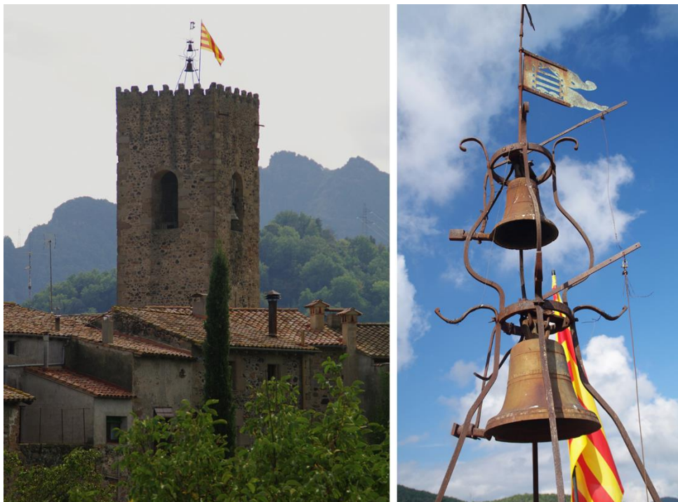
Fig. 206: Estructura de ferro del campanar de Santa Pau amb la campana de les hores i, damunt seu, la dels quarts, gòtica. Foto LdC.
