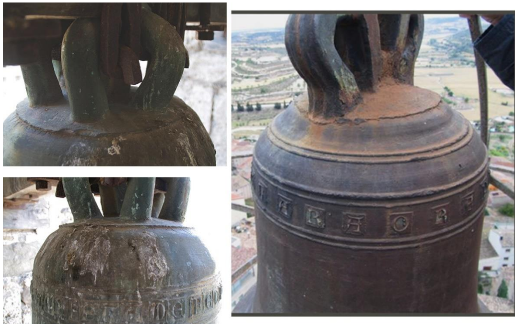
Fig. 176: Unió de la corona amb les nanses, i rebava que queda després de la fosa: campanes de Sant Pere de Besalú (Foto LdC) i dels quarts de Cervera, de principis del s. XIV; foto http://campaners.com/php/campana1.php?numer=4675 [11/2020].
