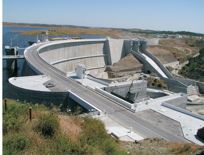
Figura 6.71: Presa de Alqueva. Perspectiva.
